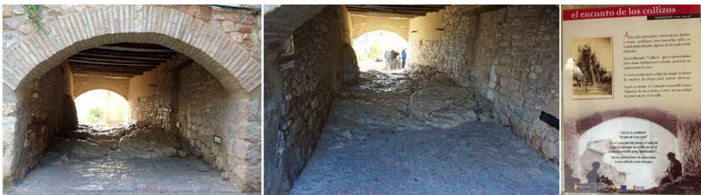
❶ Pasador Casa Laila. ❷ Sobre este pasaje existe una habitación volada con lo que consiguen ampliar el espacio de las casas. ❸ Además estos espacios eran usados para guardar enseres como las escaleras de la recolección de la aceituna.
