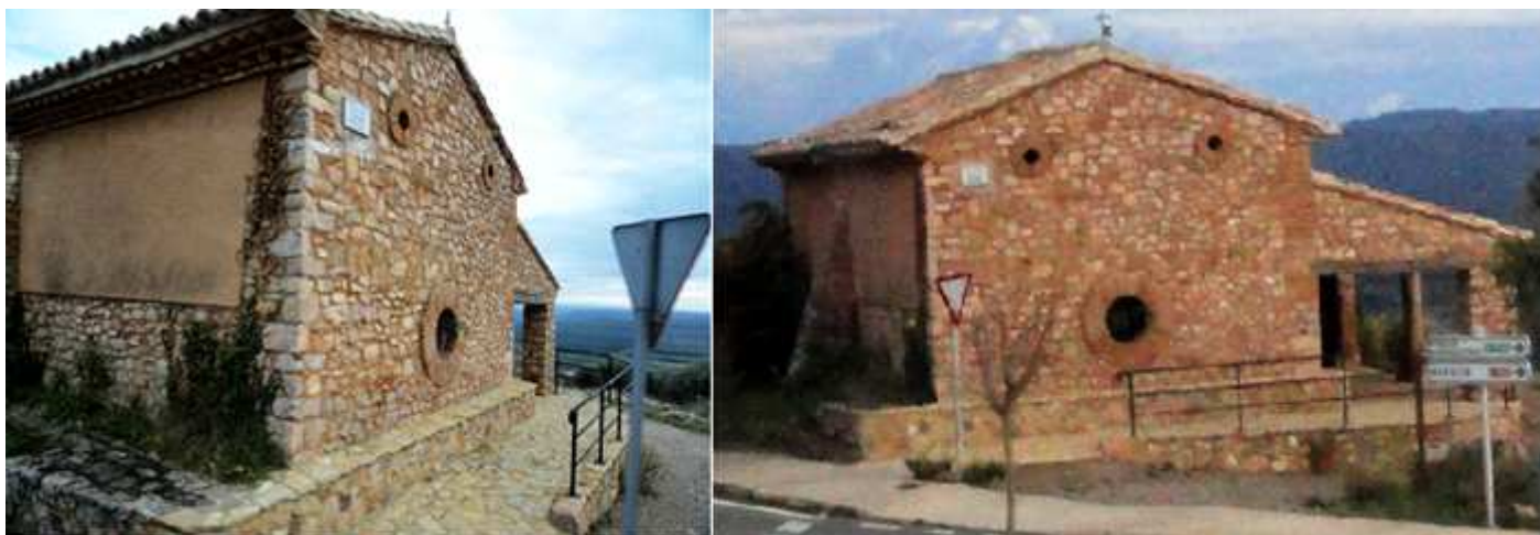
① Templo de una nave construido con cantería. ② El porche adintelado sostenido por una columna con una puerta de medio punto
