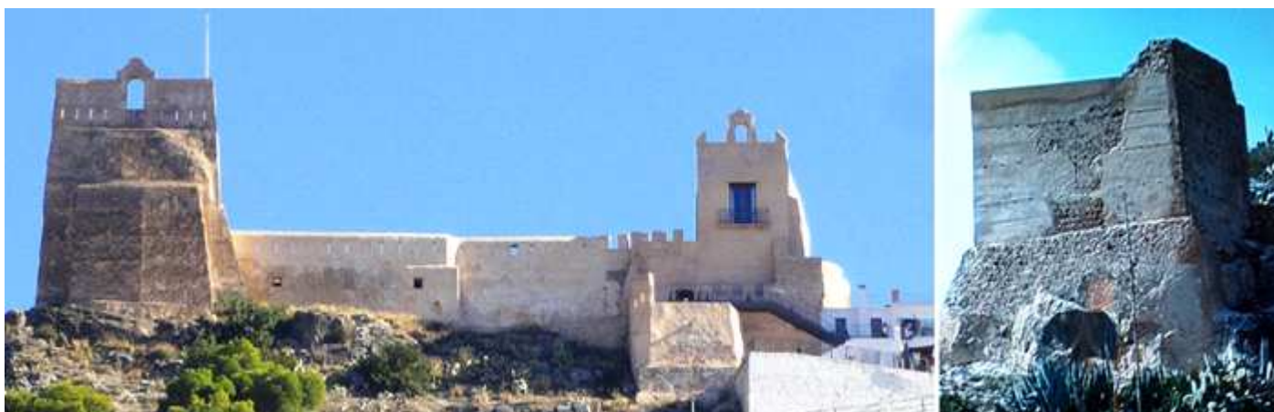
1 Silueta del castillo con la espadaña de la capilla que disponía en su interior. 2 Uno de sus torreones construido con cantería y tapial. El castillo estaba rodeado de murallas con la Torre de la Reina Mora o de Santa Ana, la Torre Miranda, Torre Raco de San Antonio, la Torre desmochada y la Torre Octogonal, que se pueden visitar por la senda que rodea al castillo.
