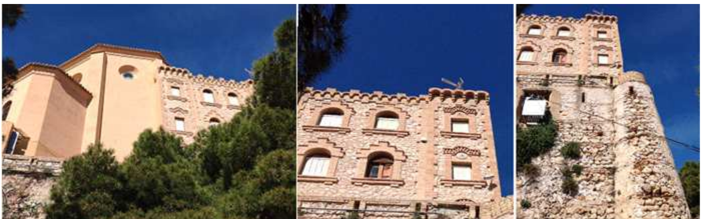
❶ Lateral del Santuario. ❷ Construido en cantería y ladrillo con ventanas de medio punto y adinteladas. ❸ Detalle de la construcción antigua en forma de talud de esta plataforma.
