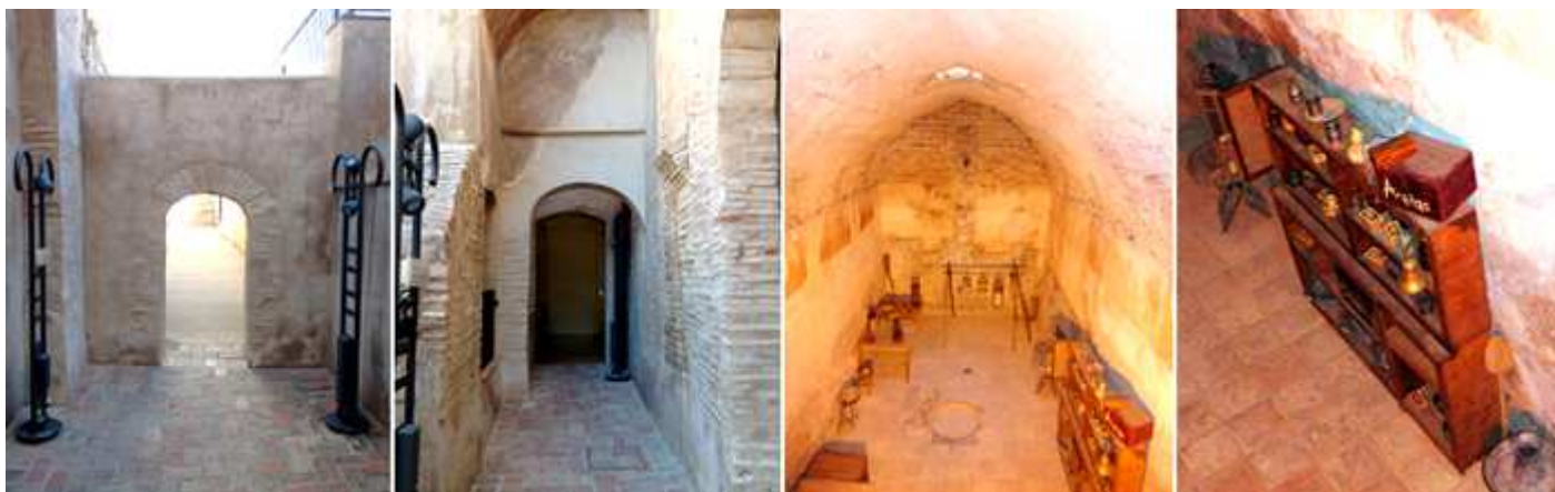
❶ Rampa que baja de la plaza de armas. ❷ Pasillo a las cisternas. ❸ Las cisternas de origen árabe que abastecían de agua a la fortaleza captada por los tejados los días de lluvia. ❹ En ellas se aprecia la notable altura que disponían para almacenar agua.
