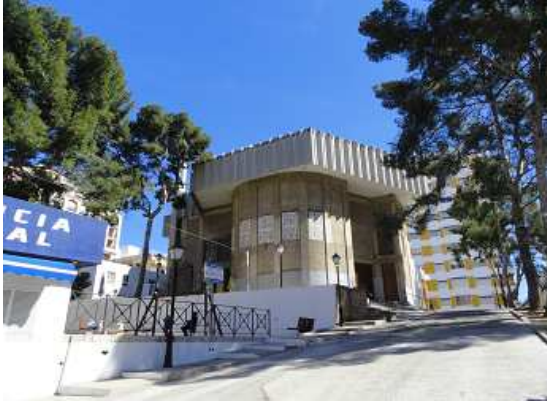
❶ Fachada de la parroquia.
