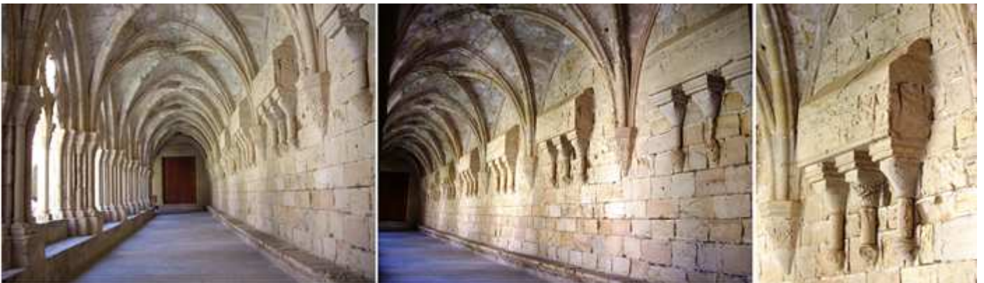
❶ Pandas del claustro construidas en el S. XIII ya en estilo gótico. ❷ Cubiertas con bóvedas de crucería. ❸ Con numerosos sepulcros de nobles y benefactores. Tres lados son góticos y uno románico adosado al templo.
