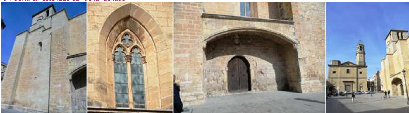
❶ Latorre en este lado epistolar y la pequeña ventana románica en el primer cuerpo de la nave. ❷ La ventana gótica sobre la puerta de esta con gran derrame exterior y doble arco con tracería, cerrada con una vidriera. ❸ Pórtico de arco rebajado entre los dos contrafuertes y que cobija la puerta de este lado. ❹ Vista de la Plaza de la Iglesia o de la Villa.
