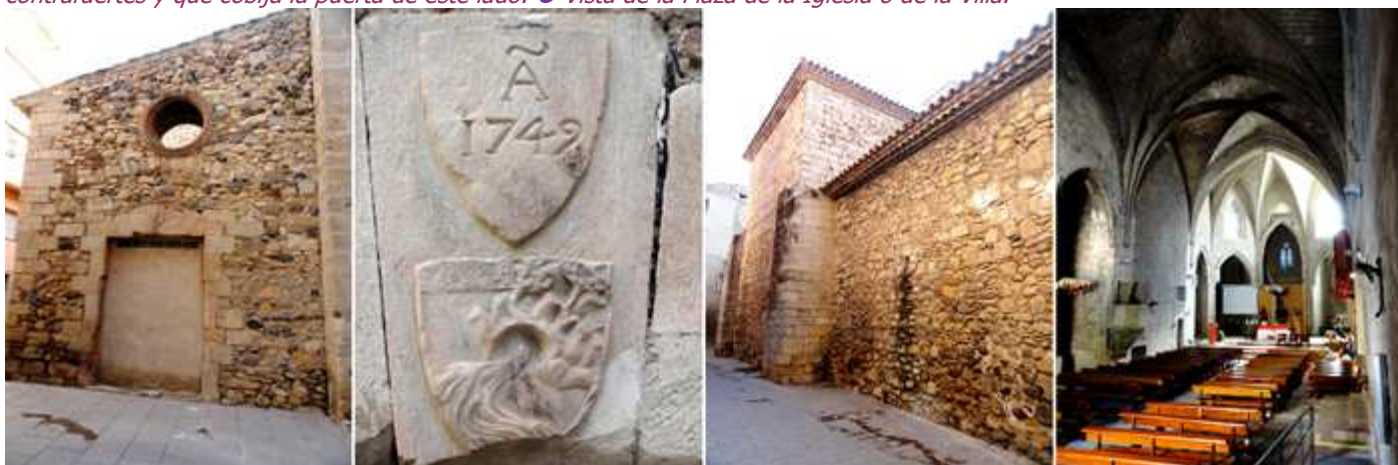
❶ Puerta cegada con un óculo. ❷ Y en la clave de su dintel este escudo fechado en 1742. ❸ Lateral del templo que en este caso construido con cantería y adosado al mismo. ❹ Vista interior de la iglesia con su bóveda de crucería, cuyos nervios arrancan de las ménsulas laterales.
