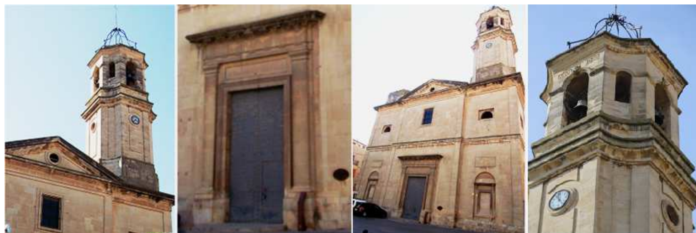
❶ Otro detalle de los dos cuerpos de la torre culminado con la estructura de forja. ❷ Puerta principal adintelada de estilo neoclásico. ❸ En este lado frontal de la torre en su parte superior consta la fecha del año 1888. Con ventanas de medio punto en sus caras y el los chaflanes.
