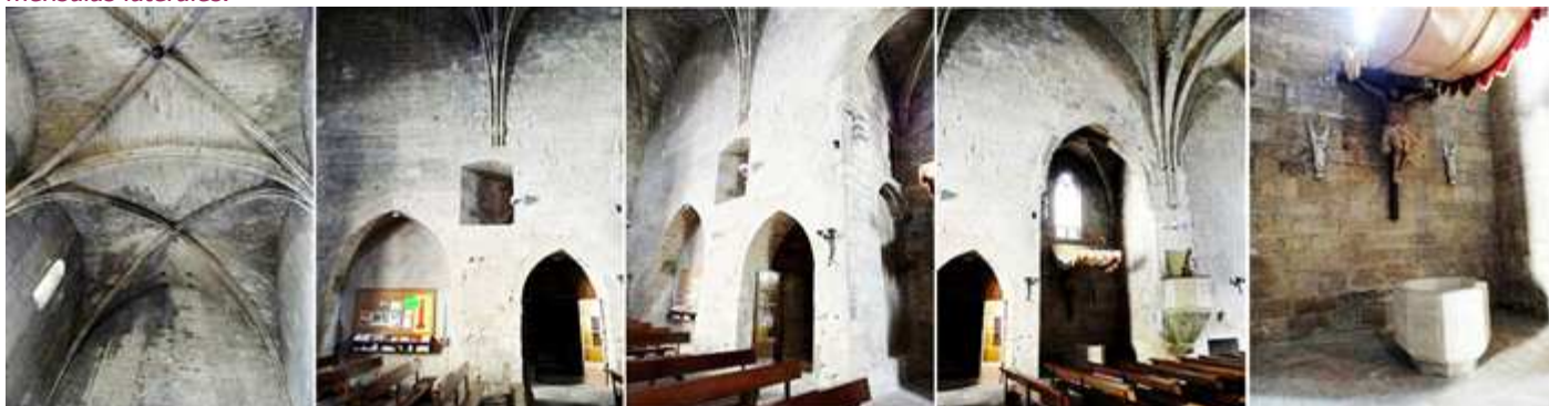
❶ Bóveda de los dos tramos iniciales del templo y a la izquierda la ventana románica. ❷ Lateral del primer tramo en el lado izquierdo con un arcosolio apuntado y una puerta de acceso a una dependencia. ❸ Imagen de este tramo. ❹ Un gran arco apuntado se abre en este tramo que cobija la capilla del baptisterio. ❺ Capilla con un Santo Cristo y la pila bautismal.
