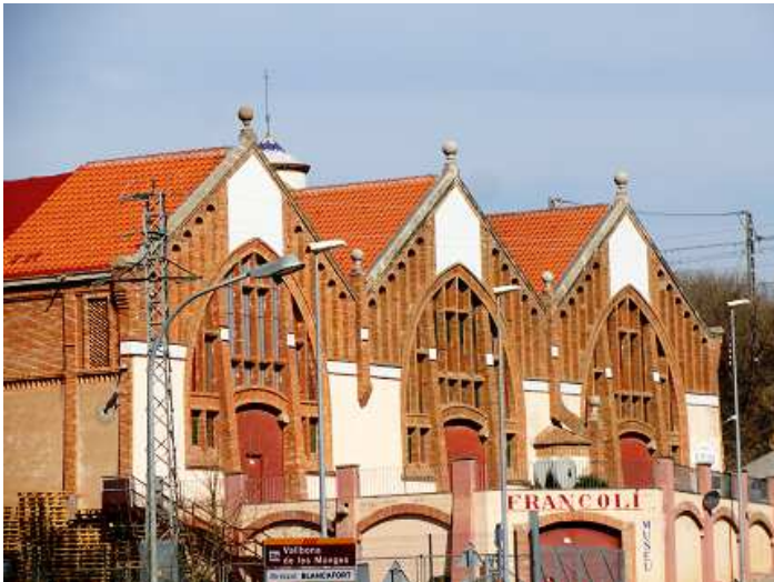
1 Detalle de las tres naves con cubiertas a dos aguas y los característicos arcos y alargadas ventanas que aportaban la luz del día 2 Esta bodega modernista fue proyectada por Luis Domenech y Montaner y la construyó su hijo Luis Domenech y Roura.
