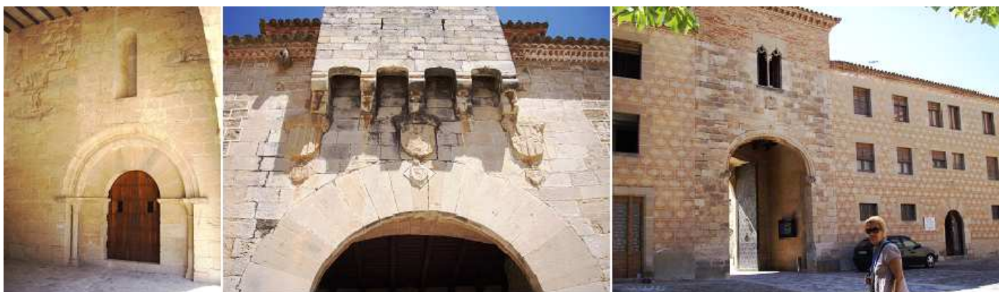
1 Puerta de medio punto de la Capilla de Santa Catalina. 2 Parte superior de la Puerta dorada con los escudos y el matacán. 3 Dorsal de la puerta Dorada y con las dependencias. Ante esta puerta se efectuaban las ceremonias de recepción de los reyes, y también era el inicio de la zona de clausura de los monjes.
