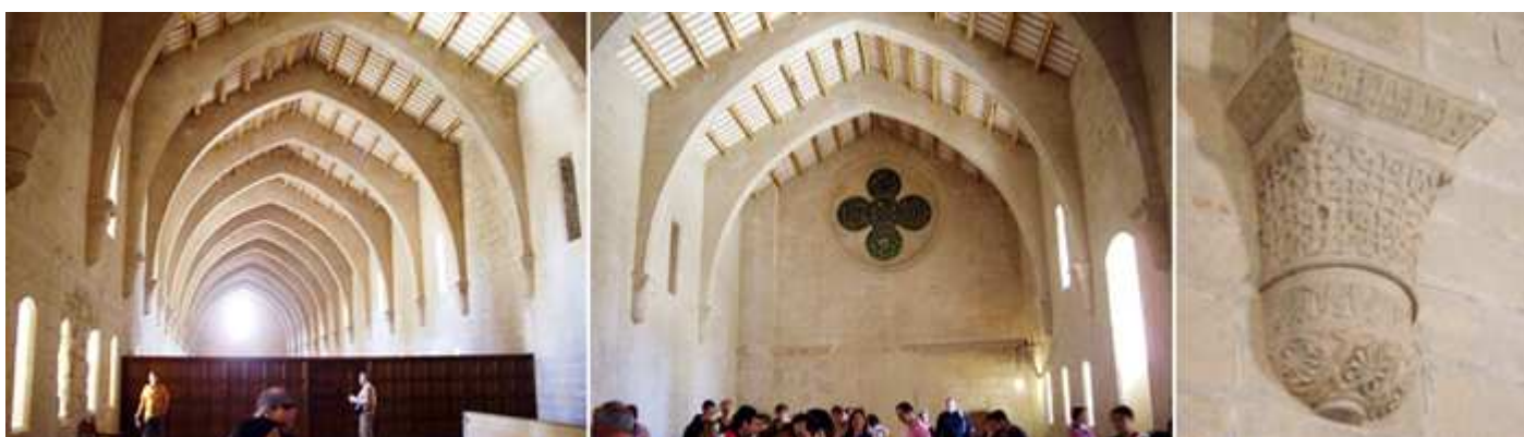
❶ El dormitorio de los monjes S. XIII. Actualmente solo es visitable la mitad. ❷ Sala de estilo gótico de 87 x 10m con grandes arcos ojivales. ❸ Una ménsula de los 19 arcos que posee para soportar su techumbre a dos aguas. Con una decoración típica del Cister.
