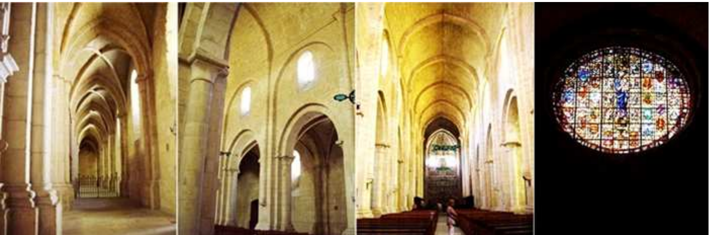
❶ Naves laterales del templo con arcos apuntados y crucería simple. ❷ La nave de la Epístola desde la nave central. ❸ La parte baja del templo desde la cabecera. ❹ Vidriera rosetón abierto en el muro oeste.
