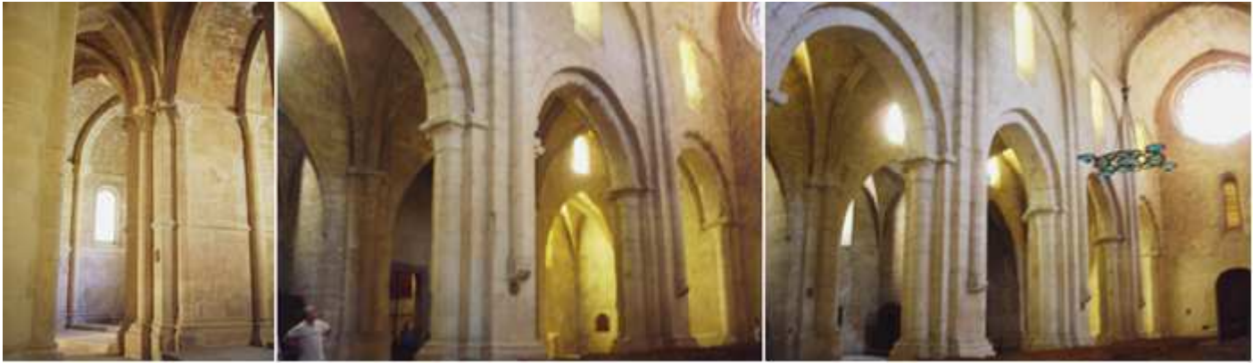
❶ Tramo inicial del ábside. ❷ Lateral de la nave de la Epístola gótica. Del tiempo del abad Copons S. XIV. ❸ Las naves separadas por potentes pilastras con columnas adosadas y arcos.
