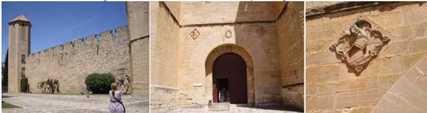
❷ Una de las torres con planta hexagonal y las murallas con almenas. ❸ Entre dos torres protegida esta la Puerta Real. ❹ Uno de los escudos de la Corona de Aragón de Pedro el Ceremonioso (1336-1387).
