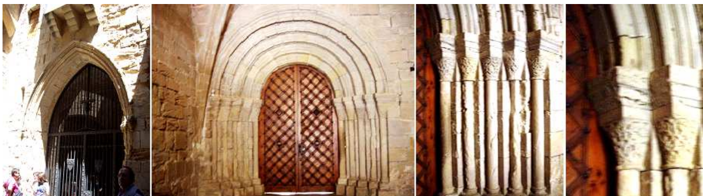
❶ Atrio del claustro. ❷ Puerta románica que da acceso al claustro. ❸ Con cinco arquivoltas. ❹ Detalle de los capiteles.
