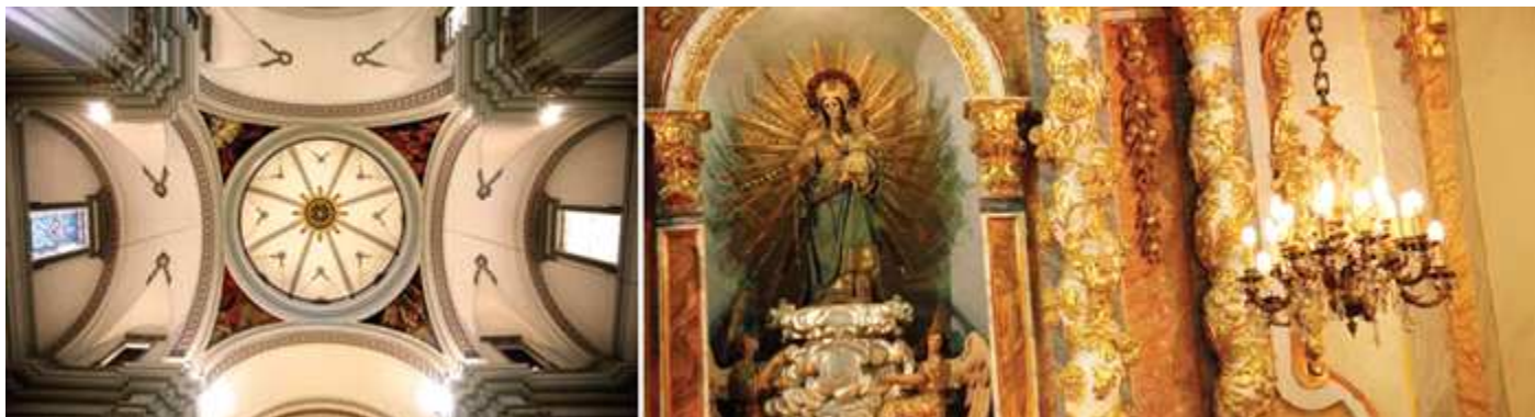
❶ Bóveda de crucero sobre pechinas. ❷ Cabecera de la Capilla de la Virgen del Rosario. Esta capilla se construyó entre 1654 y 681 y tiene planta de cruz griega, siendo desde el S. XVII la capilla de la Comunión. Ambas fotos tomadas del folleto del templo.
