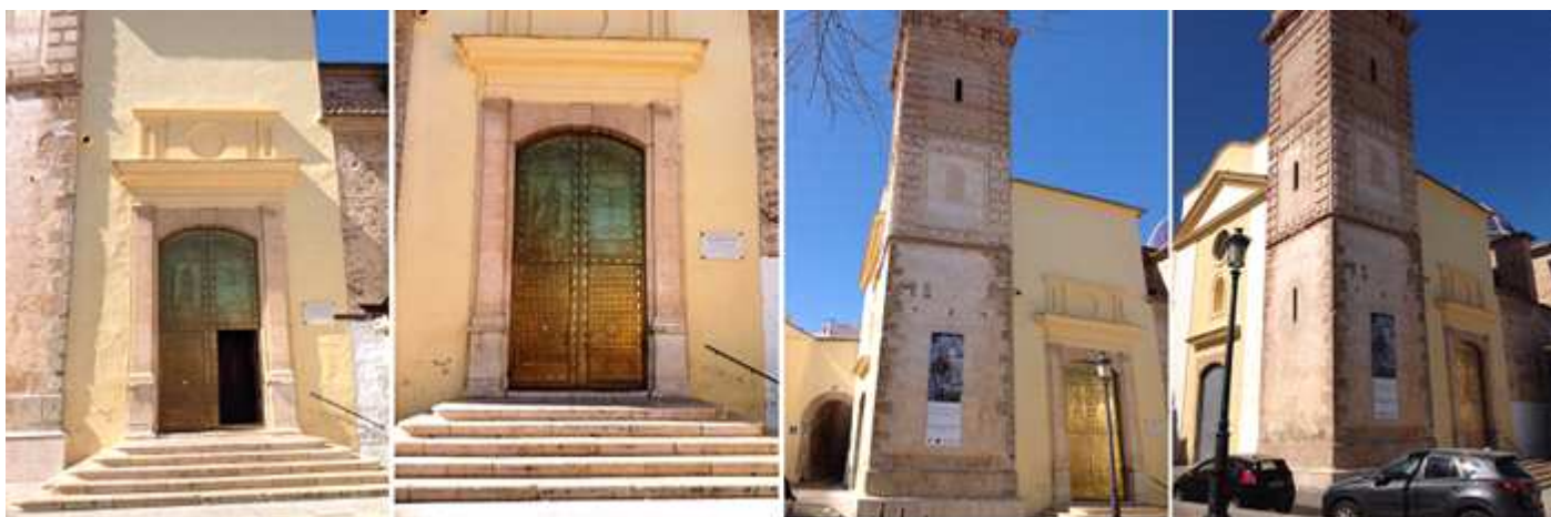
❶ Portada en el lateral de la Epístola. ❷ Con una escalinata ante la misma y con puertas contrachapadas y doradas. ❸ Adosada a esta parte inferior del templo tiene su torre de planta cuadrada de tres tramos. ❹ Perspectiva de esta parte inferior de la iglesia.
