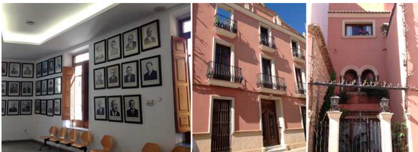
❶ Interior del Ayuntamiento. ❷ Edificio contiguo en la calle del Hospital y esquina con Santo Domingo. ❸ Espacio lateral del mismo.
