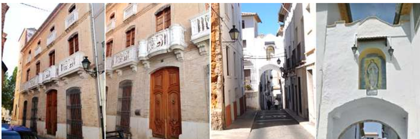
❶ Edificio junto a la iglesia de Santa María totalmente restaurado. ❷ Situado en el nº 7 de la calle de la Iglesia. ❸ A continuación por esta calle está el Portal con un arco de medio punto. ❹ Sobre el mismo hay un retablo de cerámica con la Virgen.
