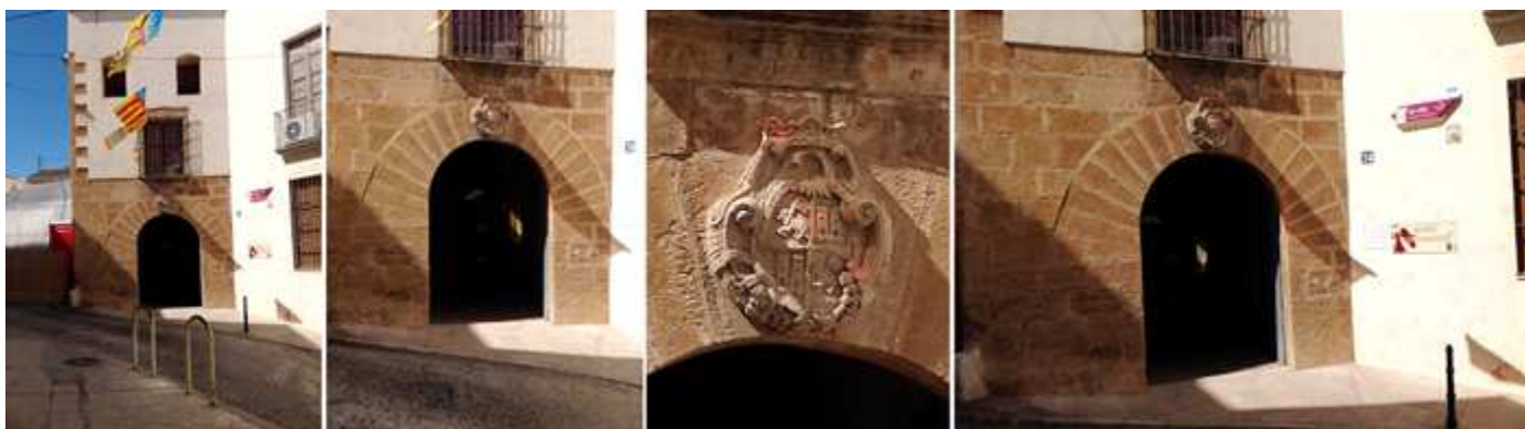
❶ Fachada en la calle de las Moreras, 38.. ❷ Con una portada el edificio de la casa Pascual de medio punto. ❸ Sobre la clave de la misma puerta ostenta un escudo nobiliario. ❹ Su puerta con grandes dovelas lisas.
