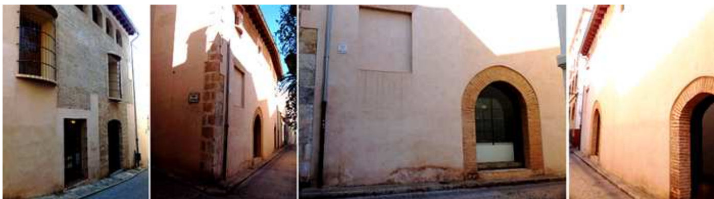
❶ Fachada principal a la calle Tamarit. ❷ Lateral de la calle Virgen del Pilar. ❸ En este lateral posee de dos puertas de medio punto de ladrillo. ❹ La fachada de esta última calle.
