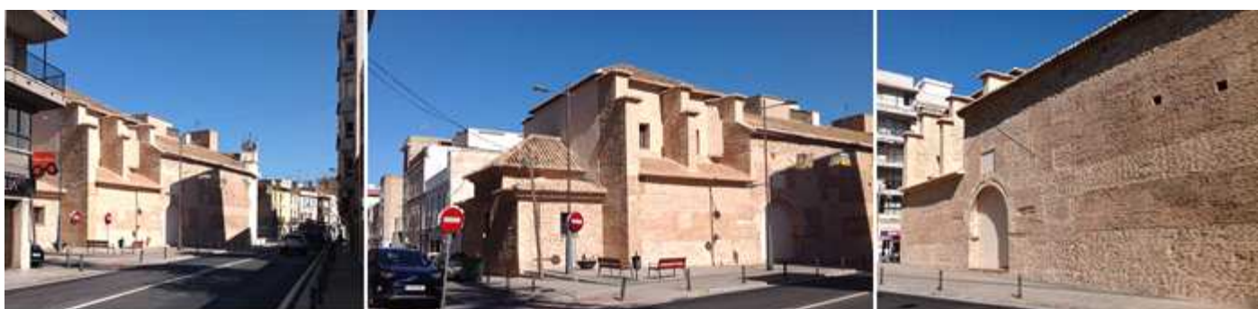
1 Lateral del templo del lado del Evangelio que da a la carretera del Convento. 2 Parte de la cabecera recta del templo. 3 En este lateral conserva una puerta, hoy cegada y la parte posterior de las capillas de este lado.
