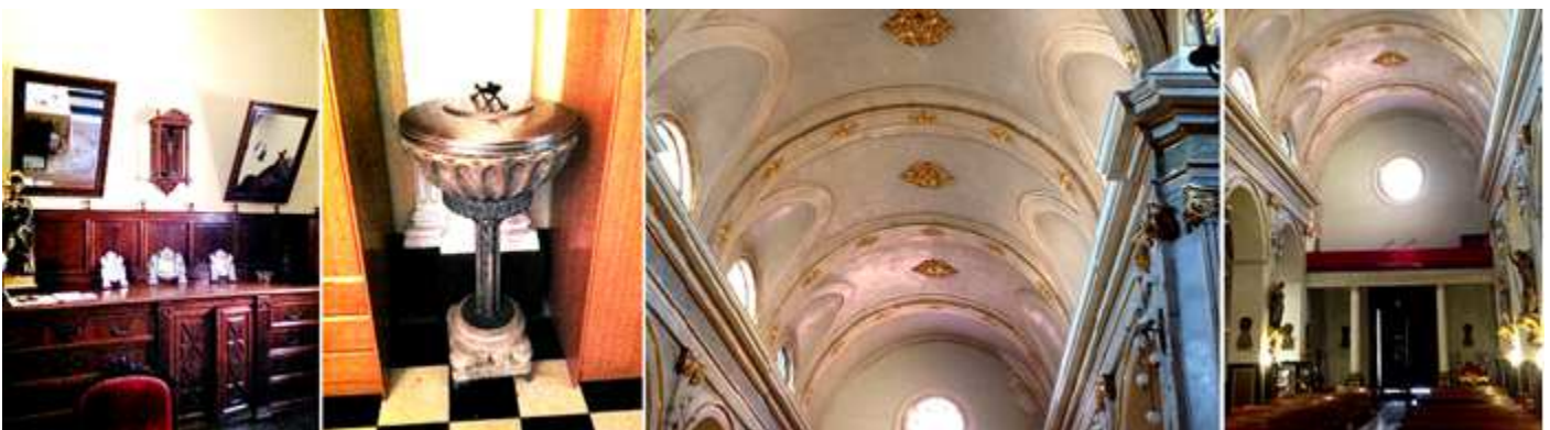
1 Cajoneras de la sacristía. 2 Pila bautismal moderna con tapa metálica y taza gallonada sobre pedestal y basa cuadrada, en la sacristía. 3 Bóvedas de cañón de la nave central abiertas con lunetos. 4 Y la parte inferior del templo que sobre columnas tiene el coro elevado.
