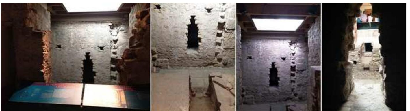
❶ Esta estación se componían de horno, caldera y una leñera. ❷ El horno estaba entre las pilas de la sala caliente conservando su conducto y la cámara de combustión. ❸ La construcción del horno está con ladrillo refractario, y solo se apagaba para reparar la caldera. ❹ Bajo el suelo se pueden observar las conducciones.
