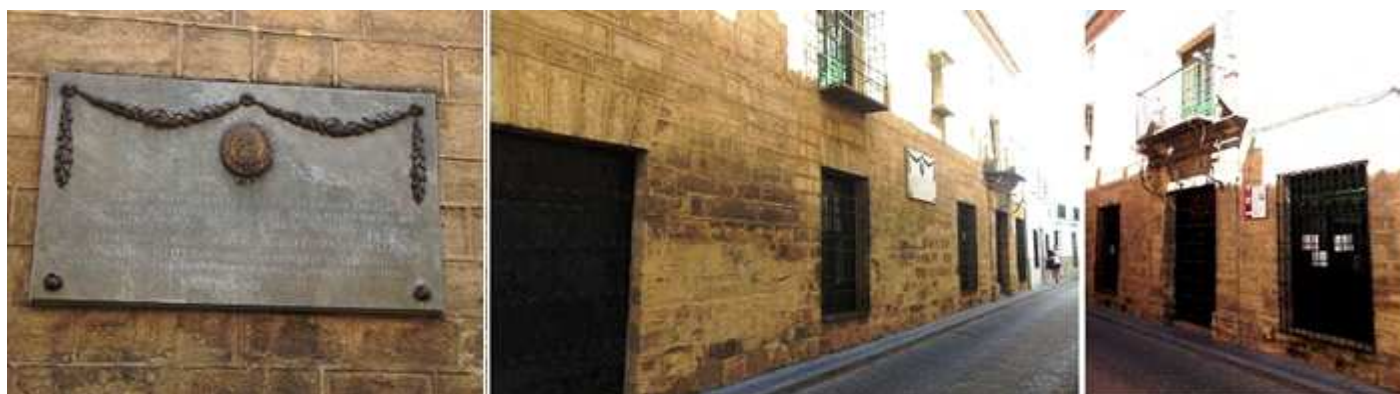
❶ Inscripción sobre su fachada: El Inca Garcilaso de la Vega hijo de la ciudad imperial del Cuzco, que vivió en esta casa. ❷ Casa de tres planta construida con piedra sillar caliza. ❸ Sobre su puerta adintelada u discreto balcón.
