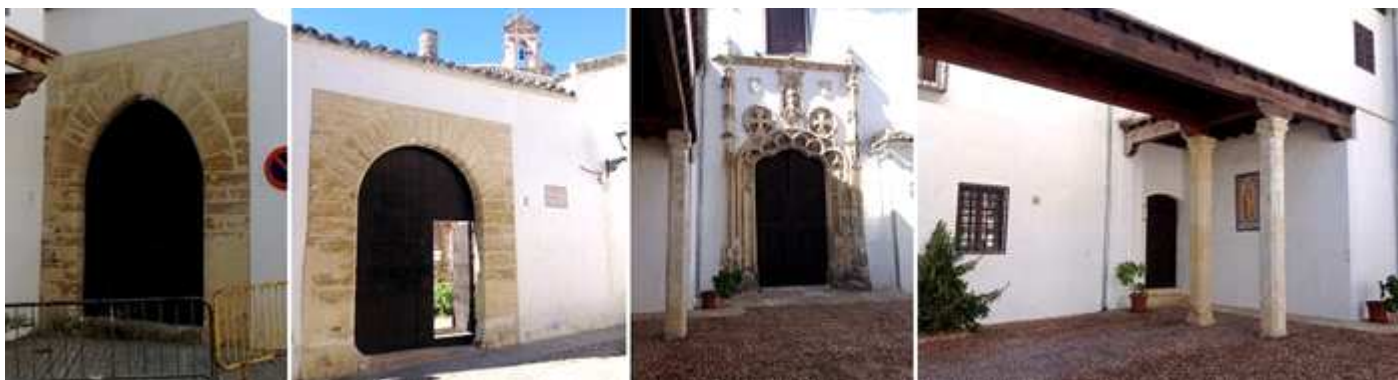
❶ Portada de arco apuntado en el rincón con el arco de tránsito de la calle. ❷ Portada del convento de pedio punto y dovelas lisas. ❸ Portada gótico plateresca. ❹ Lateral de este patio empedrado ante la puerta de la iglesia.
