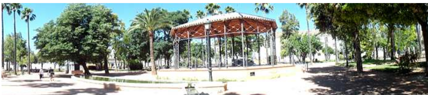
❺ Y también con un quiosco de música cuya estructura es metálica.
