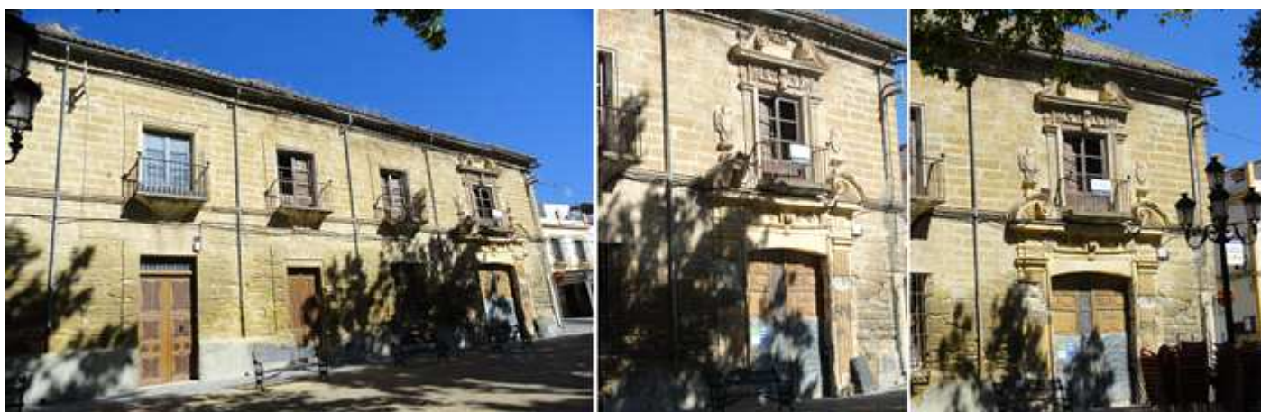
❶ Es un edificio construido en piedra sillar de dos plantas. ❷ Su portada situada en su lado izquierdo con arco muy rebajado y a sus lados columnas rectas estriadas adosadas. ❸ Sobre su puerta un frontis curvo abierto con pináculos a sus lados y sobre estos los escudos de la Casa de Priego y Feria.
