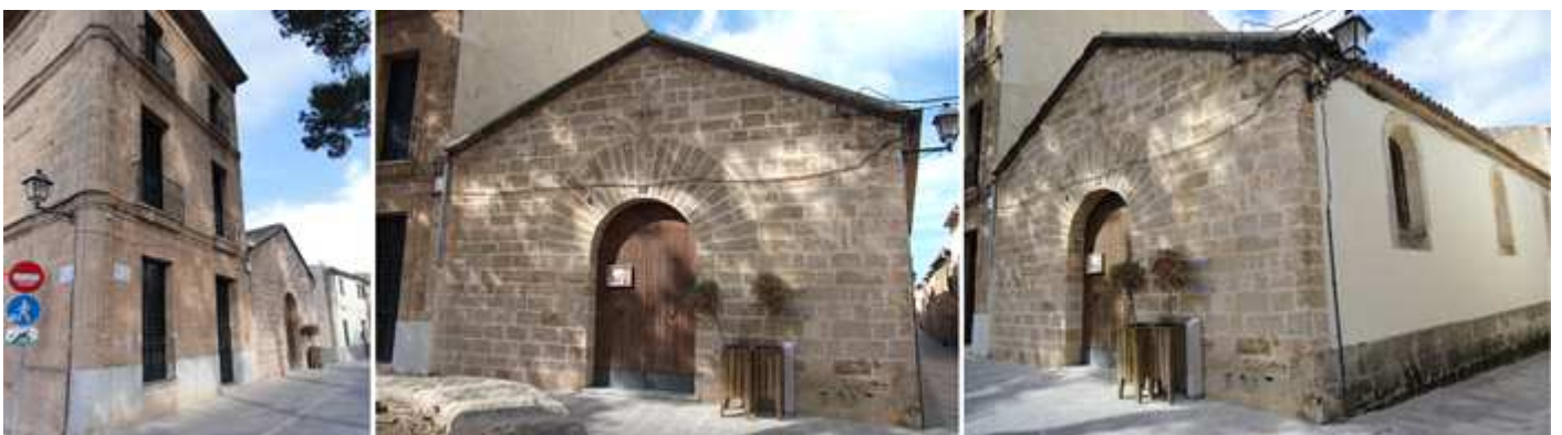
❶ Fachada frente al lateral epistolar de la iglesia. ❷ Fachada y puerta de medio punto del Museo. Sobre la clave central de la puerta ostenta esta curiosa cruz que en sus extremos ostenta unas rosas y en el centro hay bajo ella una cruz patada. ❸ Lateral.
