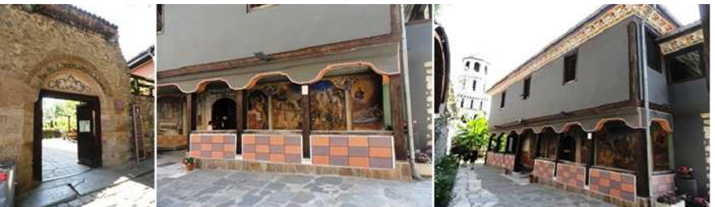
❶ Su puerta de acceso de la tapia que la rodea. ❷ Un pequeño nártex antecede al templo. ❸ Con sus muros pintados.
