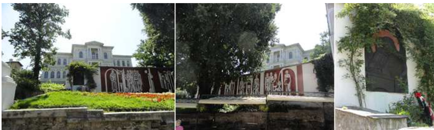
❶ La construcción del mismo, en esta zona aterrazada. ❷ Es un edificio rectangular que su cuerpo central sobresale con tres alturas. ❸ Relieve con inscripción en el frontal de este talud decorado.
