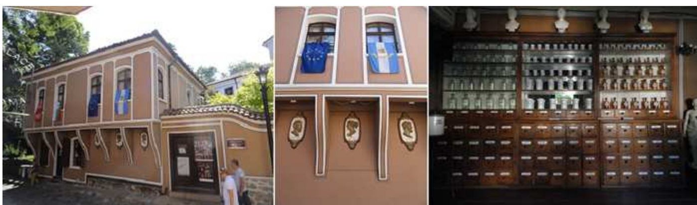
❶ Situado en la casa del Dr. Sotir Antoniadi, construido en 1872, uno de los primeros médicos en graduarse antes de la Liberación y un destacado representante de la comunidad griega en Plovdiv. ❷ Es un edificio con una distribución asimétrica, en la planta baja de la cual había una farmacia y el piso superior se usaba como vivienda. Los techos de la casa están ricamente decorados con rosetas y adornos pintados. ❸ Mueble del despacho de la farmacia. Con los botes para fabricar los medicamentos mediante las formulas magistrales. Posee estos objetos de finales del S. XIX.
