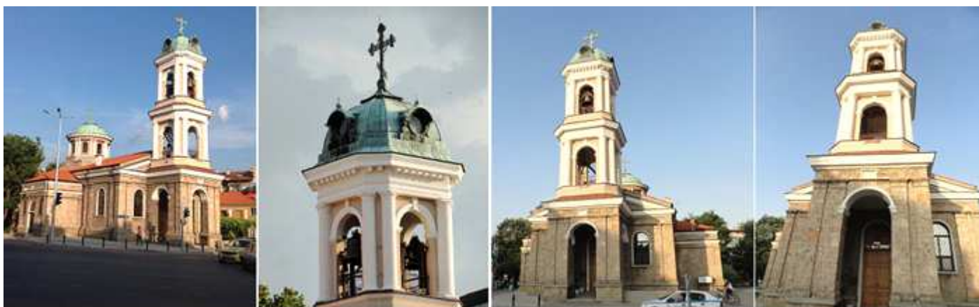
❶ A ambos lados del templo se prolongan los brazos de crucero. ❷ Cuerpo superior del campanario. ❸ Ante el templo se alza su torre de planta cuadrada con tres pisos. ❹ El espacio inferior de la torre hace de pórtico con sus arcos abiertos.
