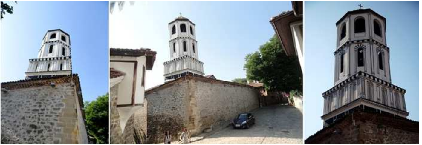
❶ Lateral de su torre a la calle Ul. "Stramna". ❷ La iglesia está rodeada por unos altos muros de mampostería, esta parte da a la plaza. "Hisar kapiya". ❸ La torre es de planta cuadrada dos cuerpos y dos más de planta octogonal y cubierta con una cúpula metálica dorada.
