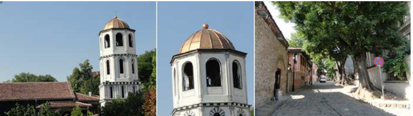
❶ Las cubiertas de la nave y a su derecha de forma exenta su torre. ❷ Último cuerpo y penúltimo con planta octogonal y abierto con ventana de medio punto. ❸ La calle ul "Saborna" que tras la puerta de acceso continúa.
