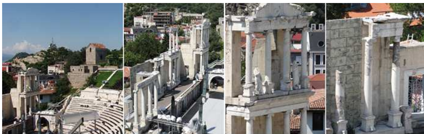
❶ Su estructura aprovecha la pendiente natural del terreno. ❷ Parte de la escena. ❸ Espacio derecho de la misma que conserva los pisos 2º y 3º, situado a la derecha. ❹ Y el espacio opuesto del lado izquierdo que conserva parcialmente segundo piso.
