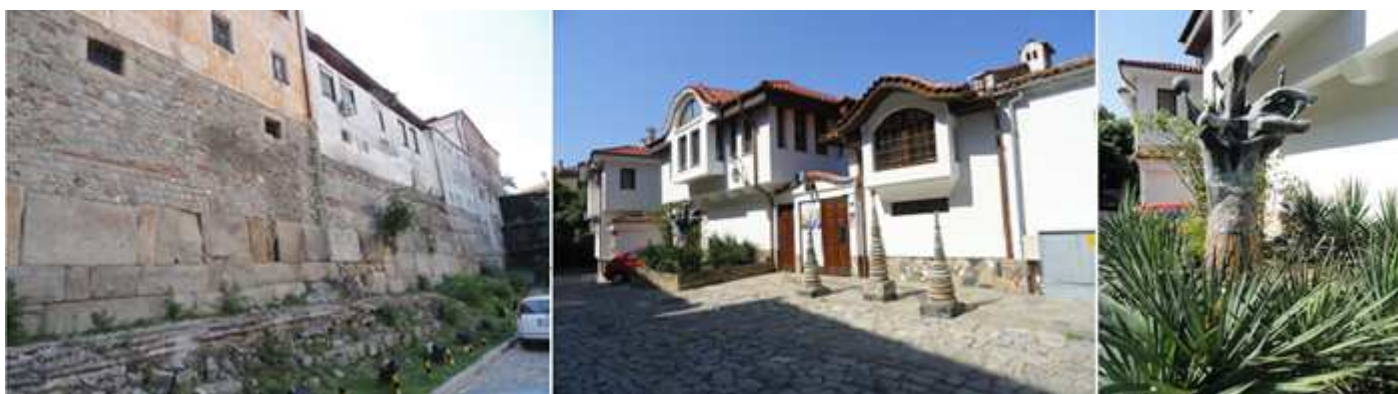
❶ La construcción comienza con un cinturón de piedra. Tiene un frente de bloques cúbicos de sienita en mampostería de capas y en el interior de la pared se rellena un bloque de piedra triturada soldada con grandes piezas de ladrillo. La siguiente capa de ladrillo está parcialmente conservada. Lo que no encontramos son: "Las torres triangulares y los contrafuertes se construyen adyacentes al muro. Las torres tienen la forma de un triángulo isósceles con una longitud lateral de 7,80m. y espesor de las paredes de 1,55m. Están a una distancia de 34m. el uno del otro" "Los restos de dos contrafuertes se encuentran entre las dos torres triangulares. Están situadas a 16m. a parte y sobresalen unos 1,70m. desde la cara exterior de la pared." que indica el cartel informativo. ❷ A la derecha de esta calle construcciones modernas. ❸ Con algún elemento decorativo.
