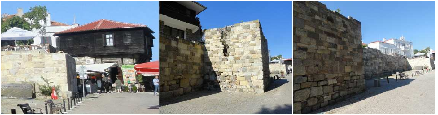
❶ Casa que hace esquina con Appollonia y Ribarska. ❷ Los muros entre las construcciones modernas. ❸ A lo largo de esta calle.
