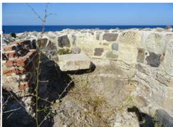
❷ Detalle interior del ábside la nave izquierda.
