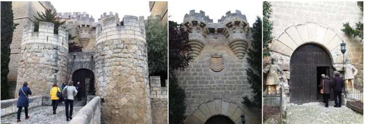
❶ Puente de piedra elevado con una rampa en forma de L. Entramos con un grupo. ❷ Sobre la puerta dos matacanes redondos. Y el escudo del Duque de Lerma. ❸ Y esta está construida con grandes dovelas lisas, y custodiada a los lados con dos guerreros de piedra.
