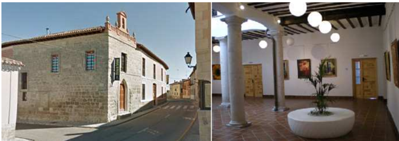
❶ Esquina de su fachada a las calles Doña Josefa Gromaz y Duque de Alba, con una puerta apuntada y corona su fachada una pequeña balaustrada con un espadaña. ❷ Foto del patio interior del Ayuntamiento.
