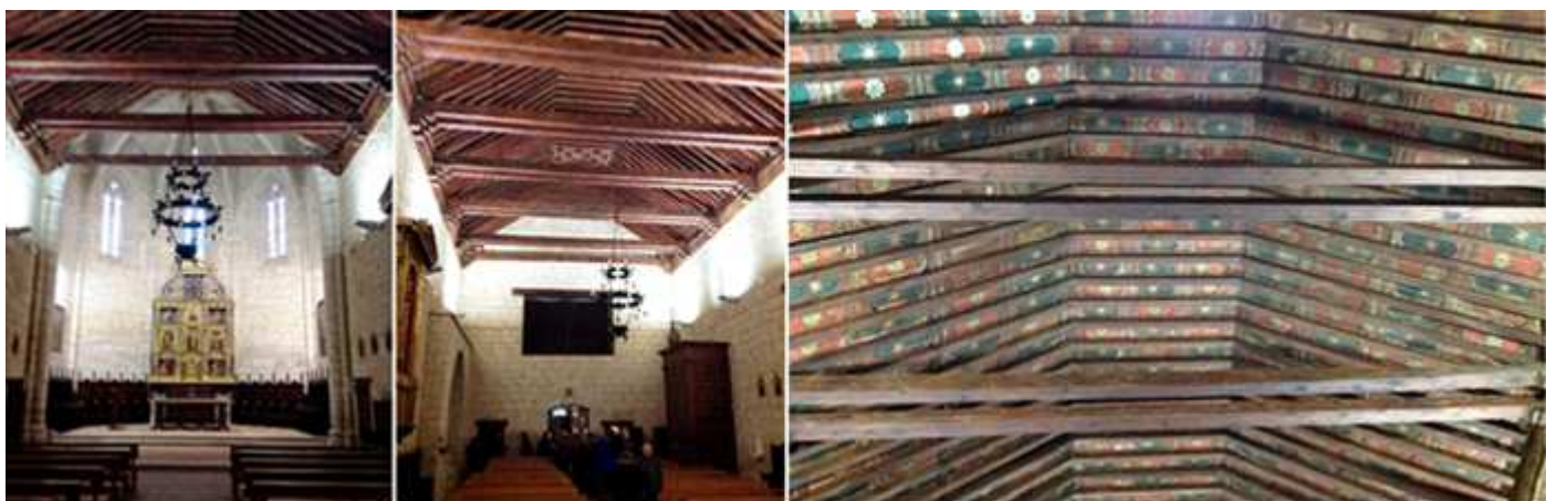
❶ Tras la cabecera el templo posee un artesonado a dos aguas. ❷ Parte inferior de la iglesia con el coro elevado y a la derecha el cajón de la puerta de entrada. ❸ Detalle de los tirantes y el artesonado policromado.
