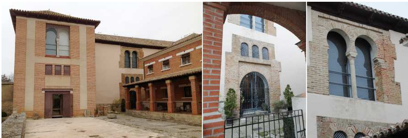
❶ Fachada interior del palacio con este cuerpo de reciente construcción tras su restauración. ❷ La portada por este lateral de medio punto realizada con ladrillo y sobre su parte superior tres ventanas de medio punto. ❸ Este par de ventanas geminadas con arcos de herradura con una columna de piedra central y con capitel floral.
