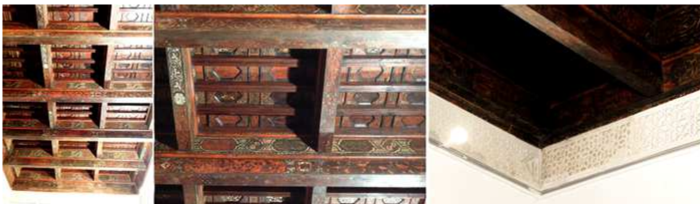
1 Artesonado del zaguán del palacio. 2 Travesaños policromados. 3 Detalle del friso que recorre este espacio con la parte antigua y lo restaurado.
