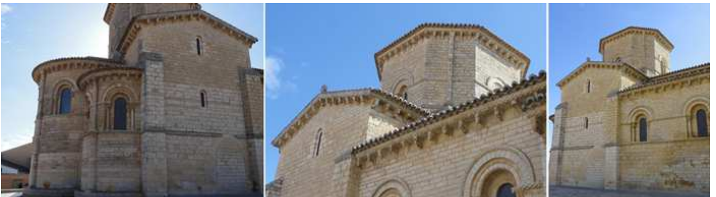
❶ Vista desde el exterior con el brazo del crucero del Evangelio. ❷ El crucero esta coronado con un cimborrio octagonal. En sus lados más anchos dispone de ventanas. ❸ Los lados estrechos, con columnas redondas adosadas. ❹ Este lado tiene tres ventanas la nave lateral y dos más estrechas el paño del crucero.
