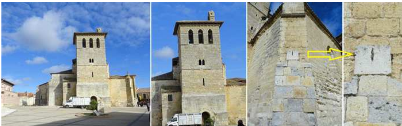
❶ Lateral con su torre de cuatro cuerpos. ❷ Ante la Plaza de Tuy, 2 ❸ En el ángulo de la fachada a los pies del templo y a la derecha de su torre conserva este reloj de sol. ❹ Tipo: horizontal, rectangular. Con los números y horas excavados. Orientación al mediodía Traza: de las 5 a las 5 h. p.m. en números arábigos. Gnomon de escuadra (roto). Estado: totalmente erosionado que apenas se percibe el semicírculo de donde radian las horas y las medias, en la parte superior la inscripción Año (ilegible).
