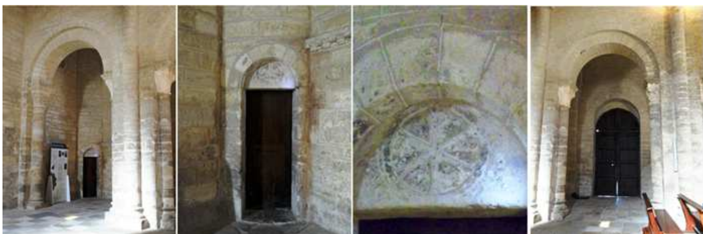
❶ En el ángulo de esta nave tiene una pequeña puerta para subir al torreón de este lado. ❷ Puerta de medio punto con tímpano. ❸ Donde posee un crismón ❹ Crismón de doble aro con seis brazos patados acanalados, en los brazos superiores A a Alfa y \Omega Omega pinjantes en el vertical la P con su vano abierto, está en la puerta interior al torreón derecho, se encuentra muy erosionado. ❺ Puerta del lado del Evangelio.
