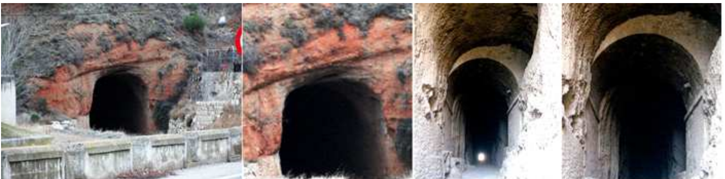
1 Junto a la carretera N-234, hay un barraco que desemboca en esta mina. 2 Fue excavada con la finalidad de canalizar las aguas torrenciales, para que no entraran a la ciudad por la puerta Baja. 3 Vista del interior de la Mina de Daroca desde la boca sur. 4 Con parte de este tramo con revestimientos en bóveda y muros.
