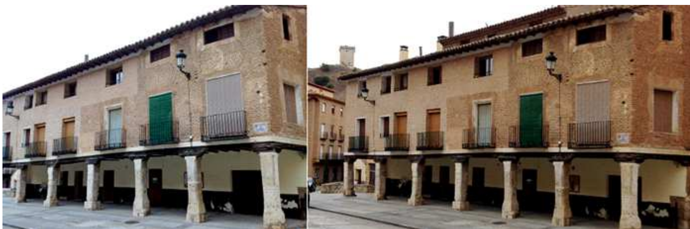
❶ Con una galería abierta con pilastras que servirá para los días de mercado. ❷ Dispone de dos plantas realizadas en ladrillos.
