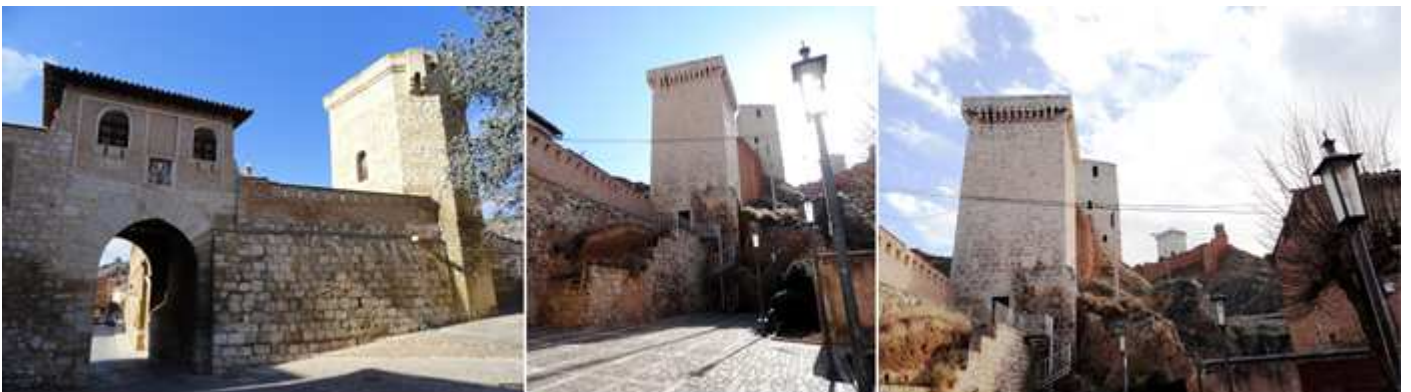
❶ A la derecha en este Torreón de los Escolapios, el Padre Blas de la Virgen del Pilar. Pionero de la observación meteorológica moderna, instaló uno de los observatorios meteorológicos más antiguos de Aragón. Es de planta pentagonal. ❷ Torre planta cuadrada rodeada con matacanes. ❸ Tras ella en el cerro, la torre de las Cinco Esquinas.
