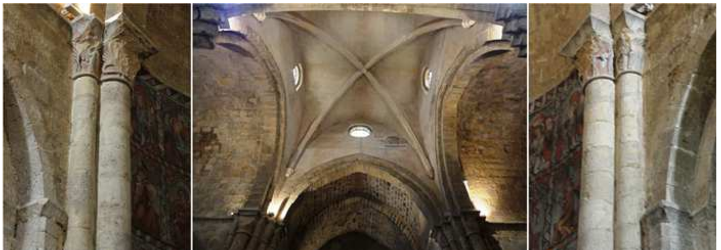
❶ Columnas y capiteles del arco triunfal en la cabecera con capiteles historiados el de la izquierda una persona sostiene una balanza. Aún conserva parte de policromía. ❷ En el crucero un cimborrio de planta cuadrada con crucería simple del S. XV. Sobre el que esta su cimborrio, este perdió su linterna en 1946. ❸ La parte opuesta, parte de sus imágenes han sido destrozadas.
