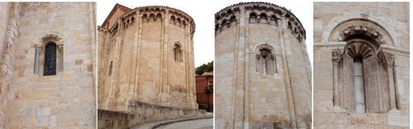
❶ Ventana del presbiterio. ❷ El templo sobre una plataforma que lo nivela visto desde el sureste. ❸ Paño central del ábside. ❹ Y su ventana que en su interior se encuentra cegada por el revoque necesario para las pinturas murales.
