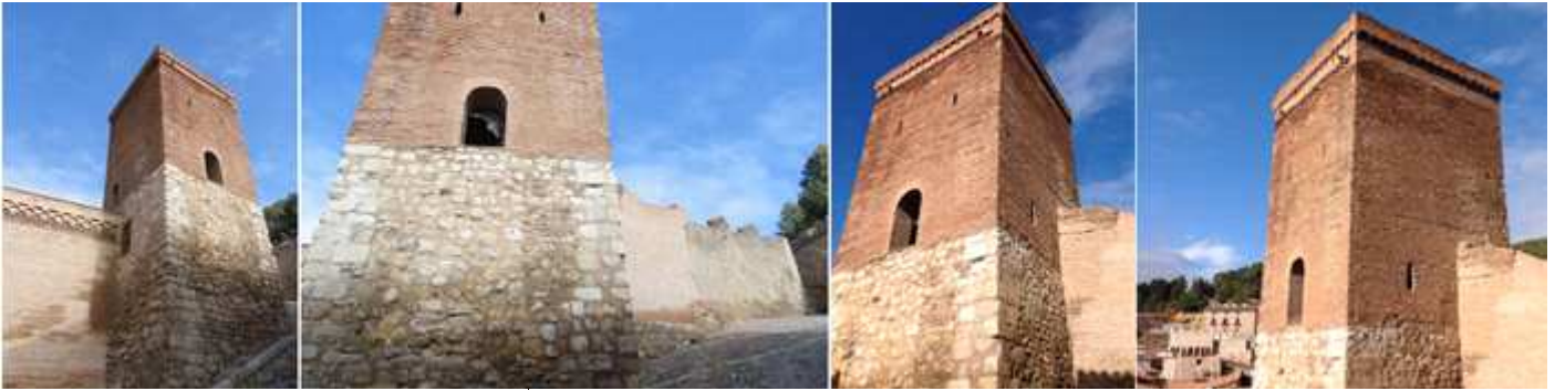
❶ Torreón del flanco derecho. ❷ Con media altura construido en piedra sillar y el resto de ladrillos. ❸ Dispone de una ventana de medio punto en su frontal y dos aspilleras. ❹ Y esta coronada su barbacana o terraza con una decoración de esquinillas y ménsulas realizadas con ladrillos.
