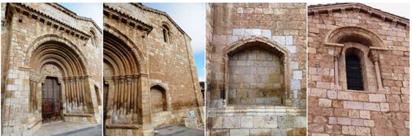
❶ Su puerta adelantada y cubierta con tejazoz con canecillos lisos. ❷ Lateral derecho de la portada donde se encuentra los capiteles historiados muy degradados con columnas sobre un pedestal. (En la parte opuesta al ser restaurados están lisos ). ❸ Arcosolio en este brazo del crucero. ❹ Ventana del crucero con imposta corrida biselada sobre la que descansa su guardapolvo con una arquivolta con capiteles (con leves hojas vegetales en uno y bolas) y columnillas.
