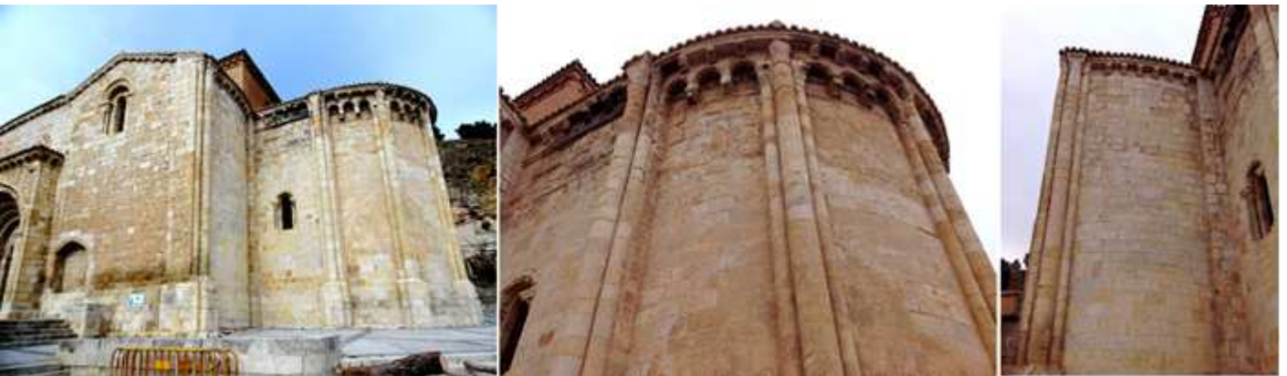
❶ Perspectiva epistolar. ❷ Con triples columnas adosadas en su ábside. ❸ Lateral del brazo del crucero.
