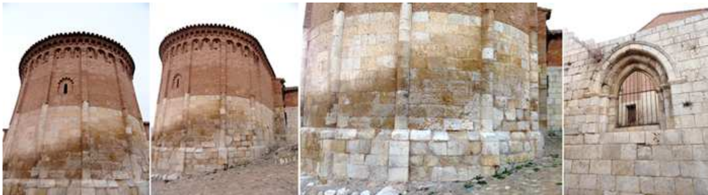
❶ Su construcción se inició por esta cabecera. ❷ Otra imagen con la parte derecha de la nave. ❸ Parte inferior del ábside con piedra sillar y columnas redondas adosadas sobre un murete o basamento. ❹ Ventana del muro de los pies. Fue parroquia hasta 1905.
