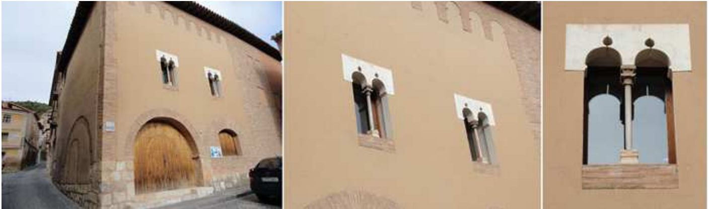
1 Fachada del hospital de finales del S. XV. La existencia del mismo está documentada desde el S. XIV. 2 Que posee dos ventanas geminadas. 3 Ventanas con arcos de yeso y estilizadas columnas con capiteles con motivos vegetales
