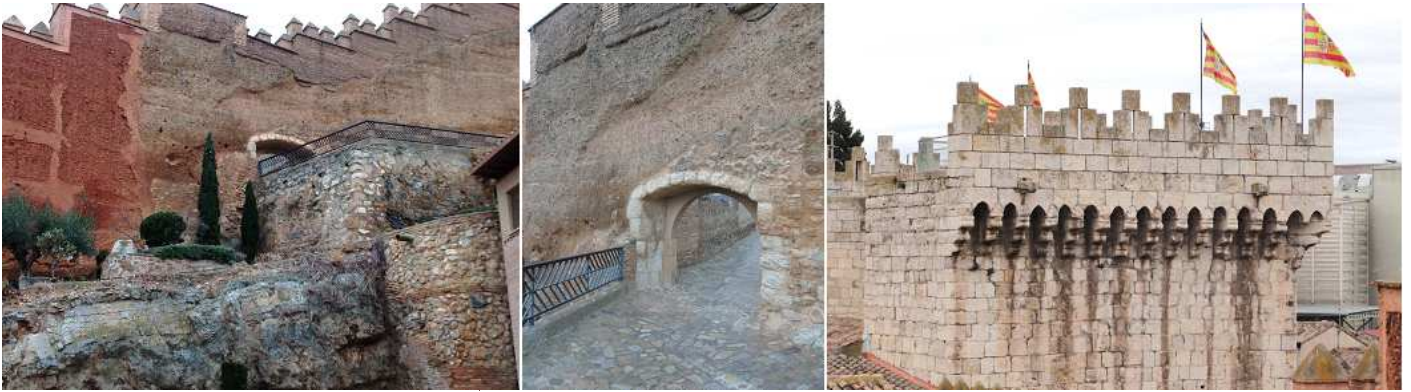
❶ Las murallas y la puerta vista por la parte interior de Daroca. ❷ Con un arco rebajado de piedra por si interior. ❸ La parte superior del torreón de la puerta baja.
