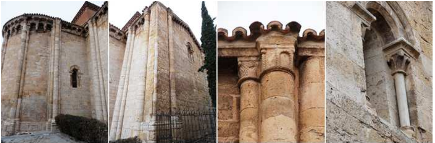
❶ Lateral derecho exterior del presbiterio, que dispone de una ventana. ❷ El brazo del crucero que tiene una dimensión reducida. ❸ Detalle de las columnas y capiteles en este ángulo del brazo del crucero. ❹ Ventana con capiteles con palmas y volutas.
