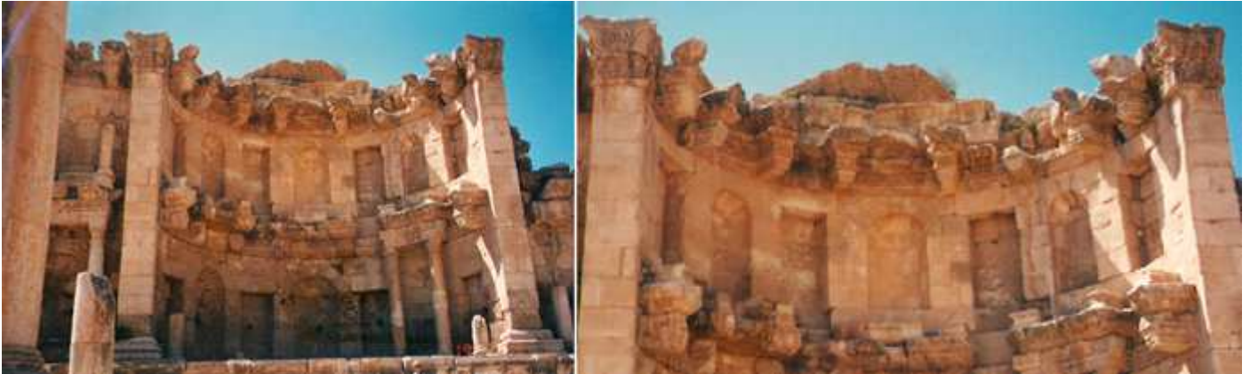
❶ Formando un semicírculo la parte central con dos pisos de nichos. ❷ Y su parte superior estaba cubierta con una concha que protegía el ninfeo.
