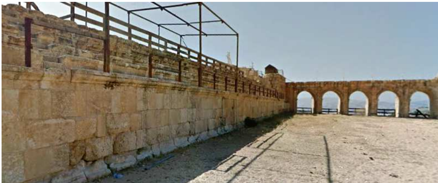
❶ El hipódromo con forma de U alargada y en la parte superior con unas arcadas, cinco a cada lado de la central, total 11 arcos, del Acueducto que proporcionaba el agua a la ciudad.
