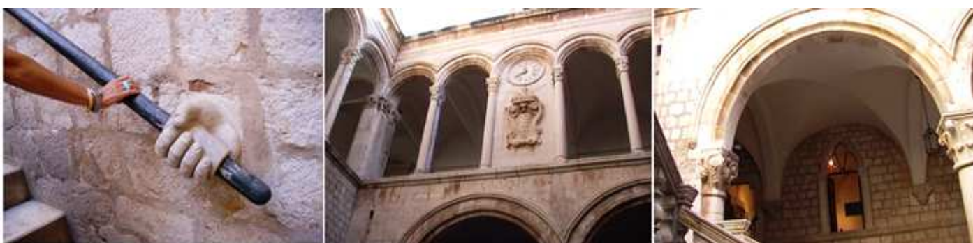
❶ Original barandilla de la escalera ❷ En la planta superior en su frontal entre los arcos posee un escudo y sobre él un reloj. ❸ Bóveda de crucería simple con arranque en las ménsulas laterales.
