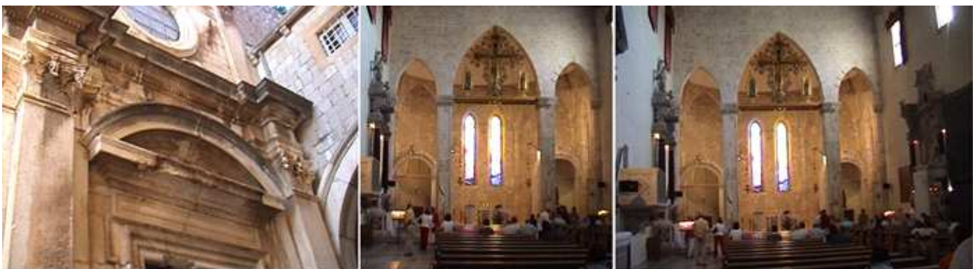
❶ Fachada de la iglesia restaurada tras el terremoto de 1667. ❷ En su interior permanecen las ventanas góticas que se salvaron en el terremoto. ❸ Cabecera poligonal y a los lados dos arcos con forma de hornacinas.
