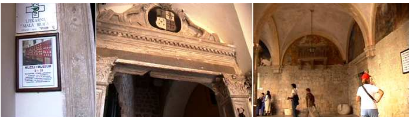
❶ Cartel informativo de horario y precio de la visita. ❷ Puerta de entrada al claustro adintelada y con un escudo. ❸ Una de las pautas con los nervios de las mismas que nacen de las ménsulas hasta las pilastras opuestas.
