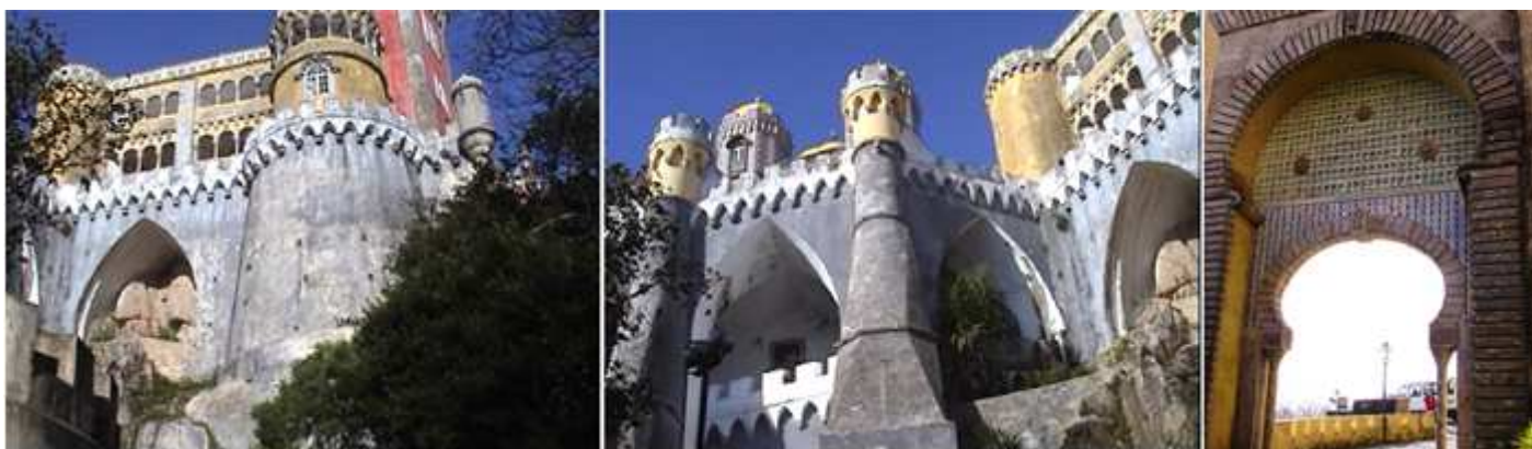
❶ Está asentado sobre la roca viva y estos arcos van nivelando la plataforma de sus construcción. ❷ Otra vista desde el camino que nos lleva a la puerta de acceso primera. ❸ Puerta de herradura tomada desde su interior.
