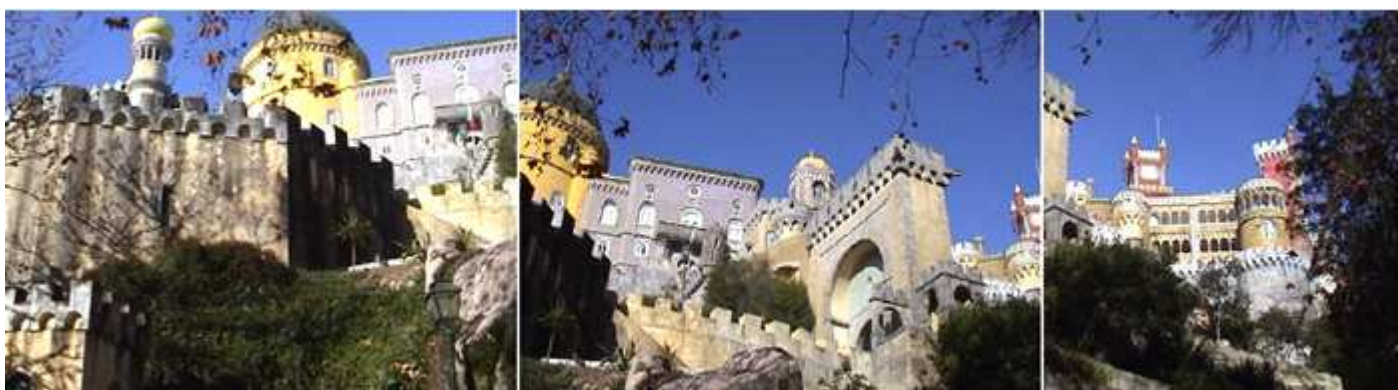
1 Estos son los últimos metros desde donde te deja "el tranvía" totalmente encaramado en el alto las instalaciones del palacio 2 A las que se accede por una sinuosa rampa. 3 A medida que subimos ya vamos observando las diferentes partes del palacio.
