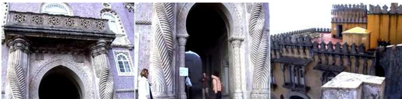
❶ Otra de la puerta con tres columnas trenzadas y estriadas con un balcón sobre el arco. ❷ Parte inferior de esta puerta. ❸ Parte superior del edificio de las cocinas con su terraza almenada
