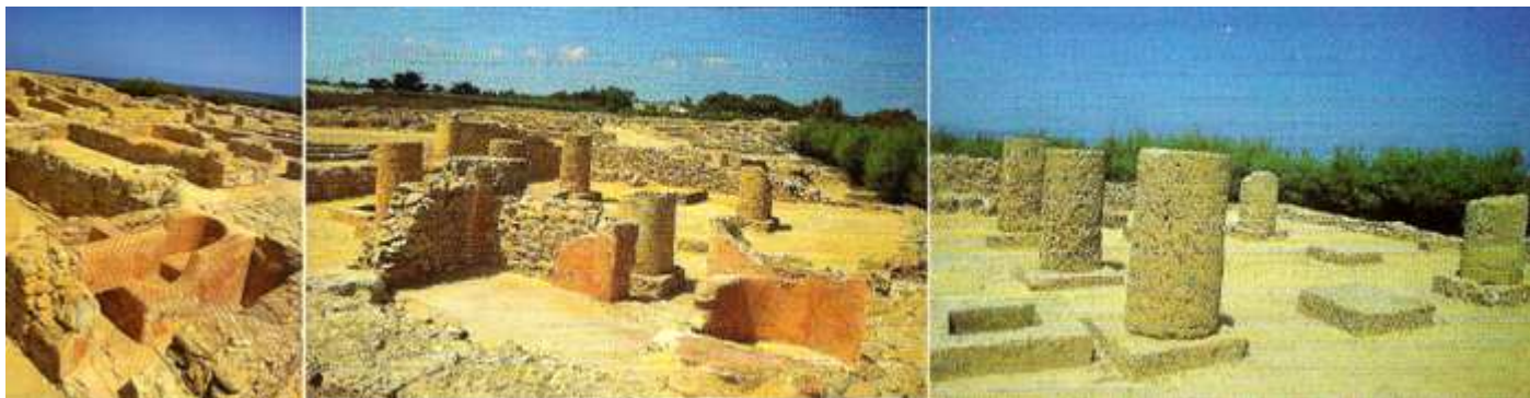
❶ Dado que en la ciudad no existían baños públicos cada casa disponía de su baño, y podemos apreciar estos baños revestidos de yeso coloreado. ❷ Las columnas de un patio y a la derecha otro baño. ❸ Columnas de otra vivienda.
