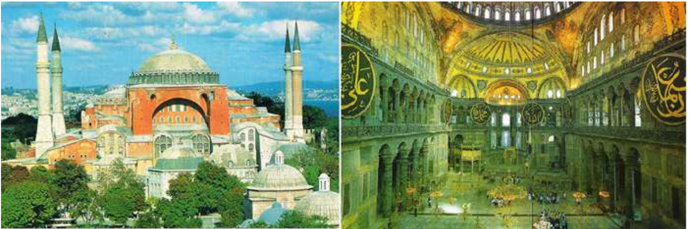
1 Imagen frontal del templo con sus cuatro minaretes. El sultán Murad III encargó al arquitecto turco Sinan, 1535-1574, la construcción de los dos minaretes frontales de la iglesia. 2 Y otra con la exuberante decoración que posee en su interior.
