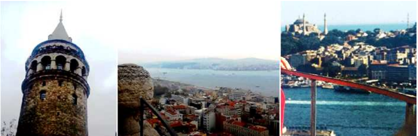
❶ La torre también tiene el nombre Chistea Turris (torre de Cristo) por los genoveses. Y Megalos Pyrgos (la Gran Torre) por los bizantinos. ❷ La torre tiene una gran terraza en su última planta como mirador de 360°. ❸ En los años 60 su estructura interior de madera fue sustituida por una construcción de hormigón y fue abierta al público.
