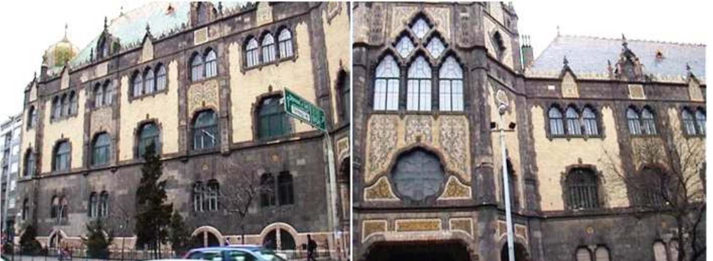
❶ Lateral izquierdo de la fachada principal. ❷ Está es asimétrica su fachada con un cuerpo central con diversos tipos de ventanas.
