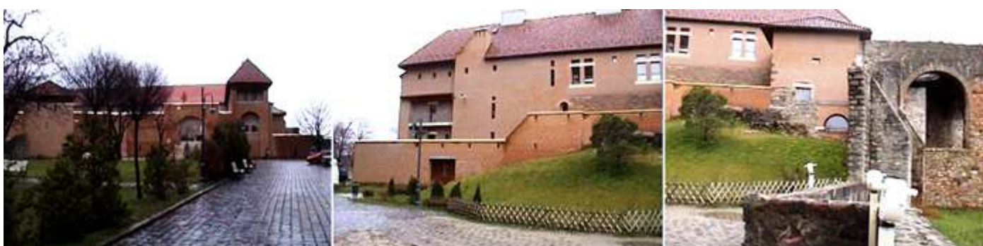
❶ Y lo rodea estos jardines. ❷ Parte de la construcción moderna. ❸ Reconstrucción con ladrillos modernos y piedras medievales.
