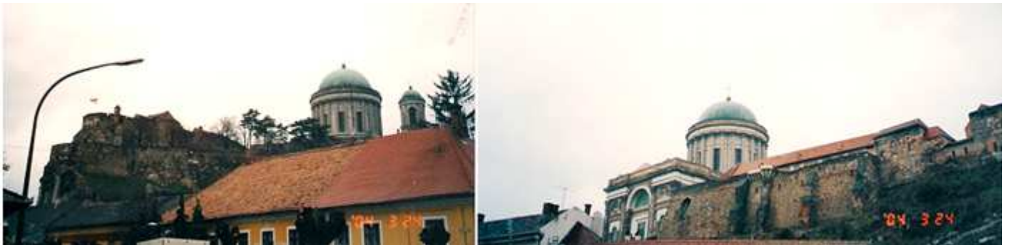
❷ Desde la parte baja se observan los restos del castillo junto a la catedral. ❸ Y parte de sus murallas en la ladera.
