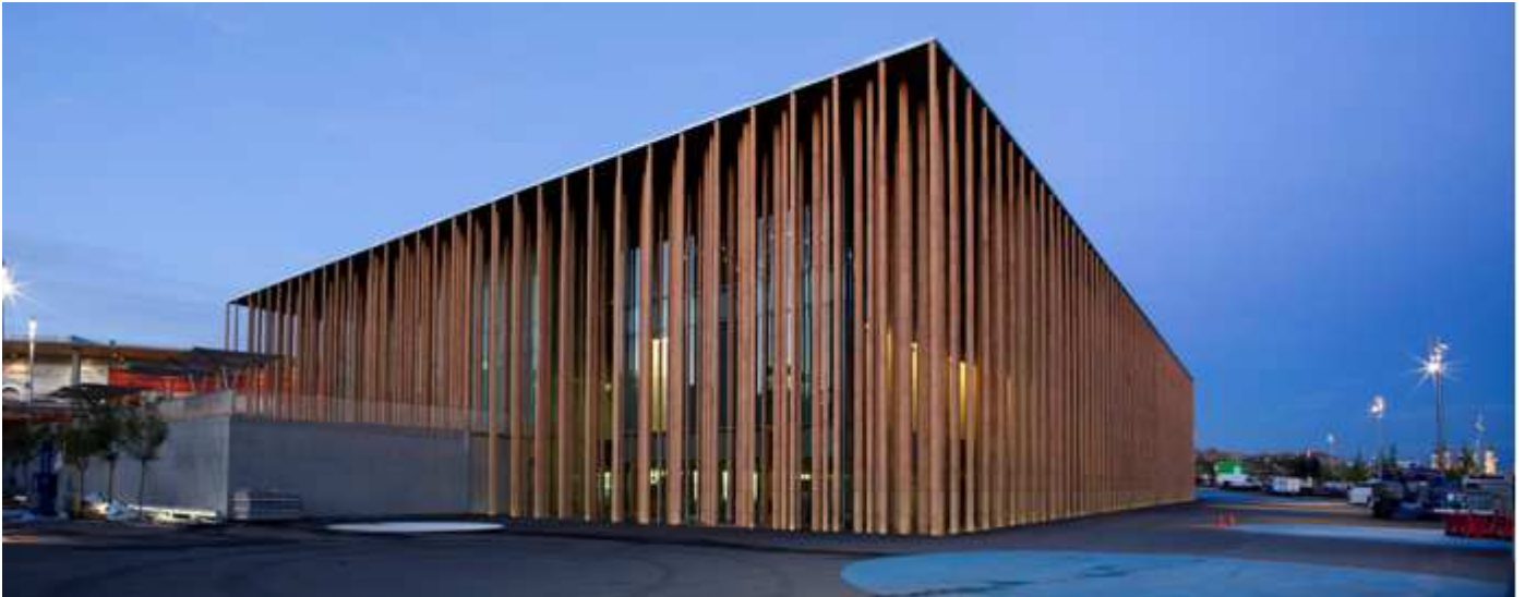
❶ Los pilares son los que soportan la cubierta del edificio.
