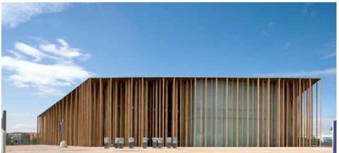
2 Fachada con la zona de entrada.
