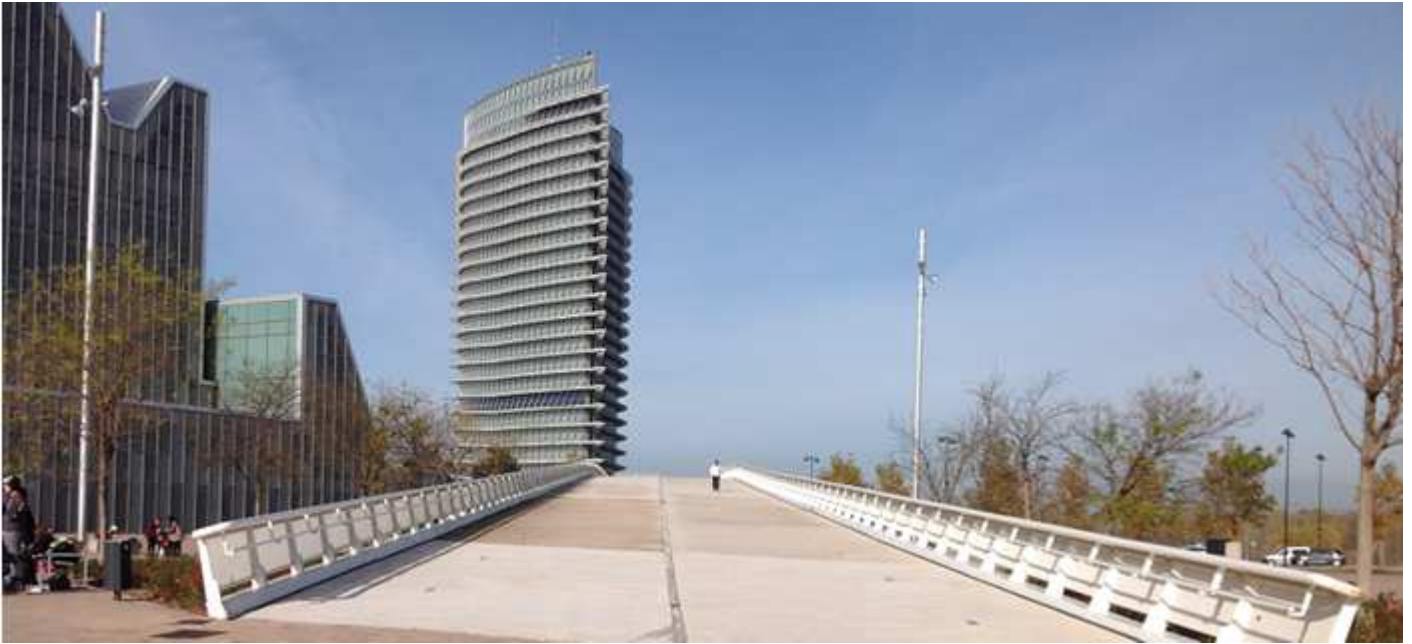
❶ Junto al palacio de Congresos el puente que conecta con la torre del Agua.
