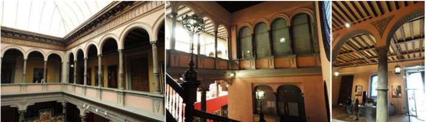
❶ La segunda planta con galerías abiertas con arcos de medio punto, y con una claraboya acristalada moderna que cierra el patio. ❷ Escalera con tres tramos. ❸ Zona de recepción entre las dos puertas del palacio.
