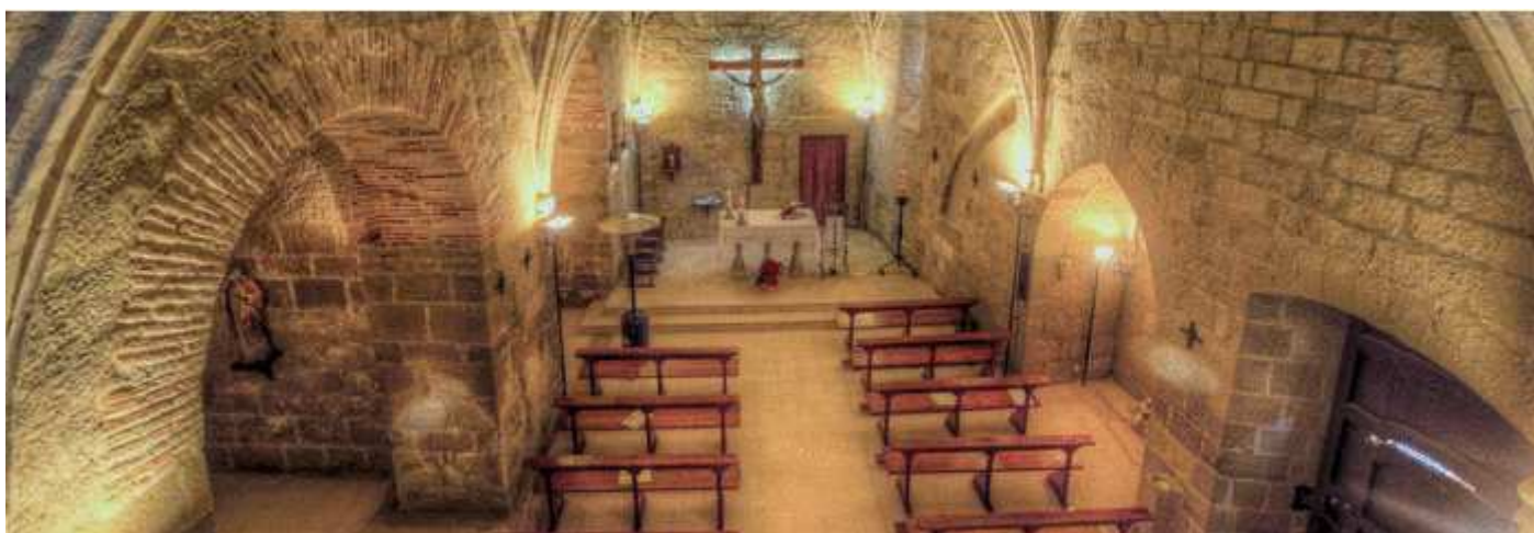
1 El interior del templo desde coro, con bóvedas de crucería y a los lados arcosolios y capillas. Foto Ayuntamiento.
