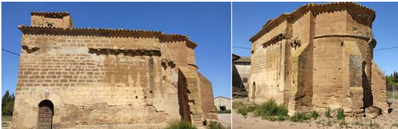
❶ En su exterior se aprecia el recrecimiento del templo y las reformas sobre sus muros con sillares menos trabajados. ❷ Su ábside semi circular que en su parte derecha aún conserva algunos canecillos. Fotos Ayuntamiento.
