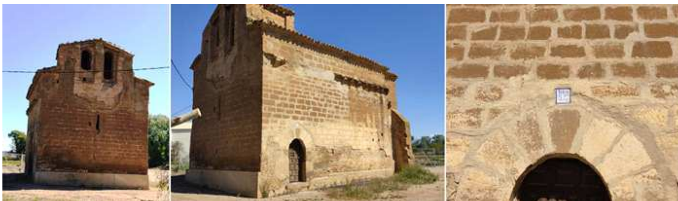
📍 Templo de finales del XII o principios del XIII. 📍 Perspectiva del templo con la torre sobre el primer cuerpo, lo mismo que su puerta epistolar. 📍 Puerta de dovelas lisas. Fotos Ayuntamiento.
