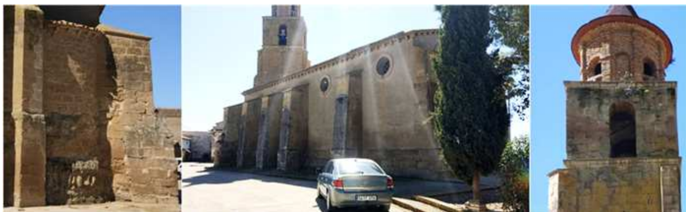
❶ Junto a la torre se aprecia una parte del ábside semicircular con canecillos lisos. ❷ Perspectiva de este lado exterior del Evangelio. ❸ Último cuerpo de la torre construido en ladrillo en el S. XVII. Fotos Ayuntamiento.
