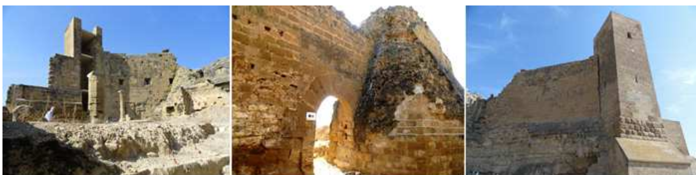
❶ La estructura de la torre de planta cuadrada con tres cuerpos desde la plaza de armas. ❷ Su puerta de acceso vigilada por el torreón que dispone a su derecha. Ubicada al norte. ❸ La torre con los lienzos de la muralla que mantiene.
