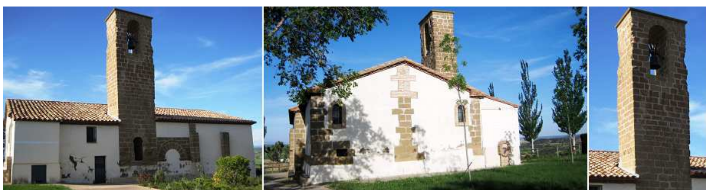
❶ Su torre campanario y a su derecha la puerta de grandes dovelas lisas enmarcada con una imposta y un grueso guardapolvo. Parte posterior de la ermita. ❷ Su gruesa España abierta con un solo vano. Fotos Ramón Ferrer.
