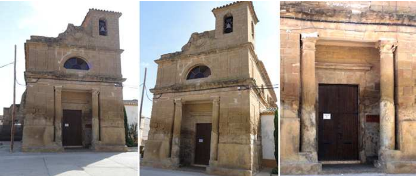
❶ Iglesia San Ramón Nonato ante la gran plaza. ❷ En su primer cuerpo alberga un pórtico con columnas sobre pódium. ❸ Dos columnas lisas con capiteles jónicos.
