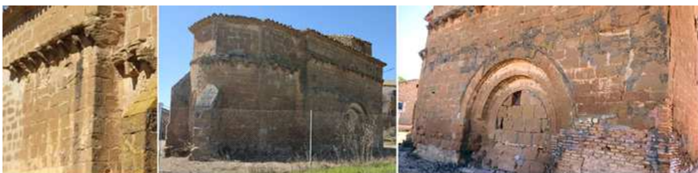
❶ Detalle de los canecillos en el lado epistolar y del presbiterio. ❷ Su ábside semicircular abierto con una ventana con sendos contrafuertes a sus lados, sobre el mismo su recrecimiento fue poligonal. ❸ En este lado su puerta con tres arquivoltas con leves baquetones en su interior y la exterior de arista recta con un fino guardapolvo. Se encuentra cegada. Fotos Ayuntamiento.
