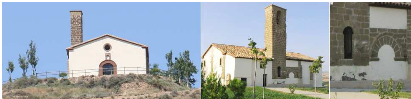
❶ Ermita Virgen Nuestra Señora de la Victoria encaramada en una loma frente al río Alcanadre. Con una puerta de medio punto con una hornacina vacía y un óculo. ❷ De la que sobresale su espadaña de bloques de piedra. ❸ Detalles de su portada y acceso a su torre. Fotos Pilar Samperiz.
