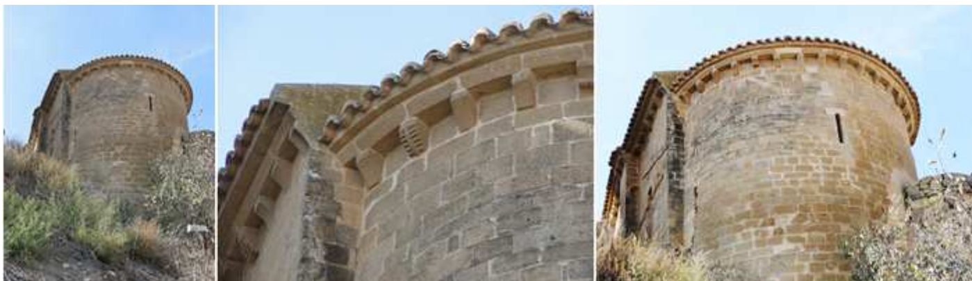
❶ Su cabecera se adapta al desnivel del terreno con la cripta. ❷ Conserva en sus aleros canecillos de rollos, de nacela y geométricos. ❸ Su ábside semicircular y abierto con una ventana saetera.
