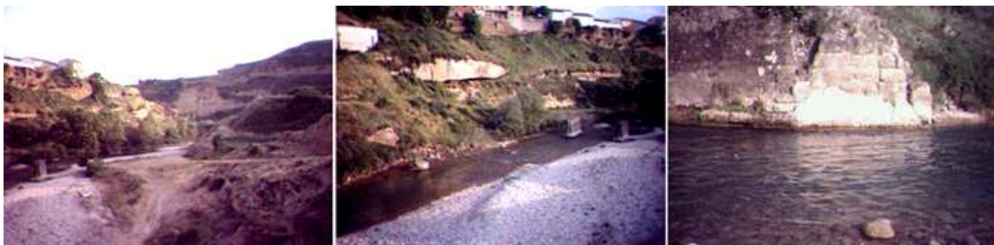
1 El río Alcanadre rodea parte de la localidad de Pertusa, formando una U 2 Estos restos de que son las antiguas pilastras de un puente. 3 Estribo del puente Romano en uno de los lados del río. Hasta el mismo se aprecia la calzada romana.
