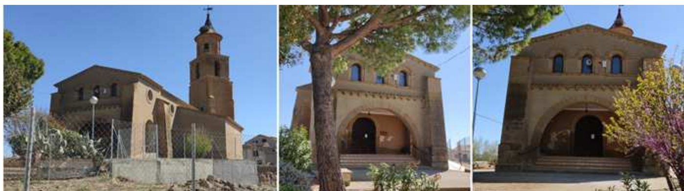
❶ En el lado de la Epístola se amplió junto a la cabecera. ❷ Hastial con un gran arco que alberga el pórtico con su puerta, y sobre el tejazoz con canecillos se abren tres ventanas. ❸ Una sencilla puerta de medio punto para la entrada al templo. Fotos Ayuntamiento.
