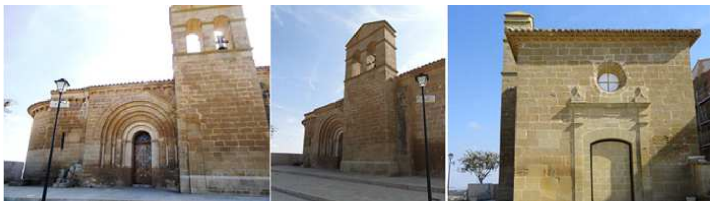
1 Frontal del templo con su espadaña con dos vanos de medio punto para las campanas, con una portada con cinco arquivoltas. 2 En este lado esta adosada su espadaña. 3 Puerta a los pies del templo con arco rebajado y pilastras a los lados sobre el entablamento un óculo.
