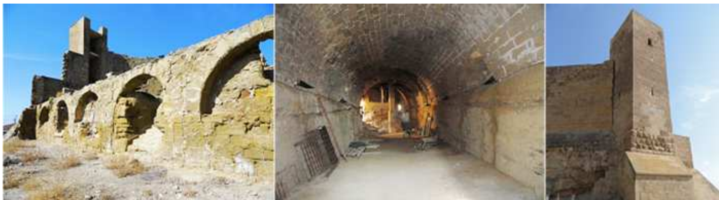
❶ Arcadas frente al lienzo del castillo que falta.
