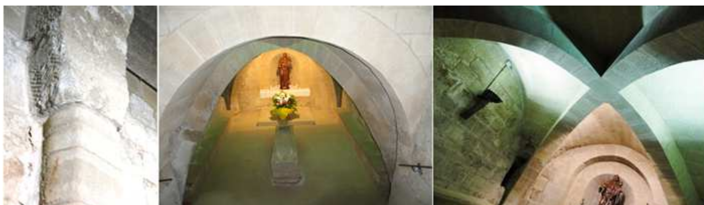
❶ Detalle de las columnas adosadas en la nave con un sencillo capitel con hojas esquemáticas y el arranque del arco fajón. ❷ Entrada a la cripta bajo el altar Mayor por medio de unos escalones. ❸ Crucería con nervios rectos que descienden hasta el suelo.
