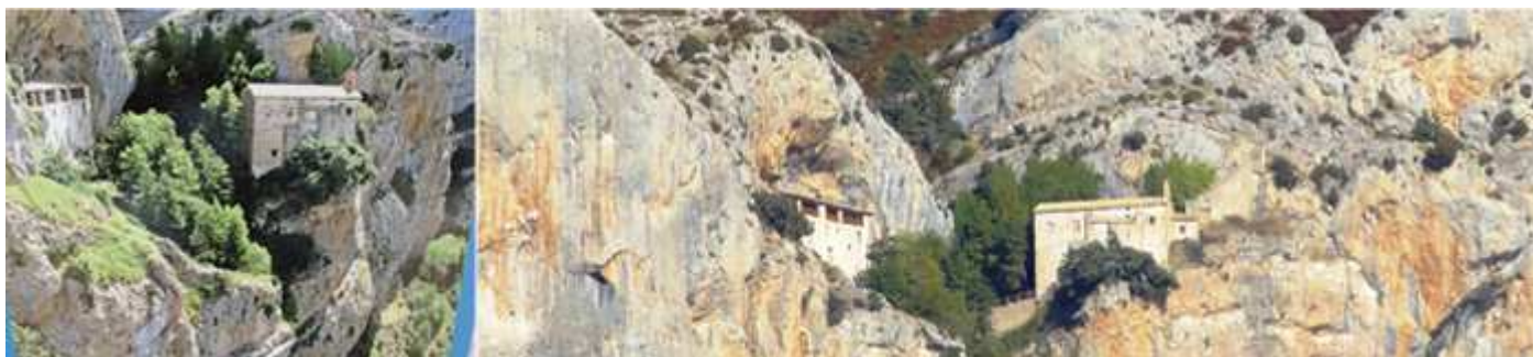
1 - 2 Dos instantáneas de la Ermita de la Peña y su situación en el roquedo. la primera del cartel de turismo.
