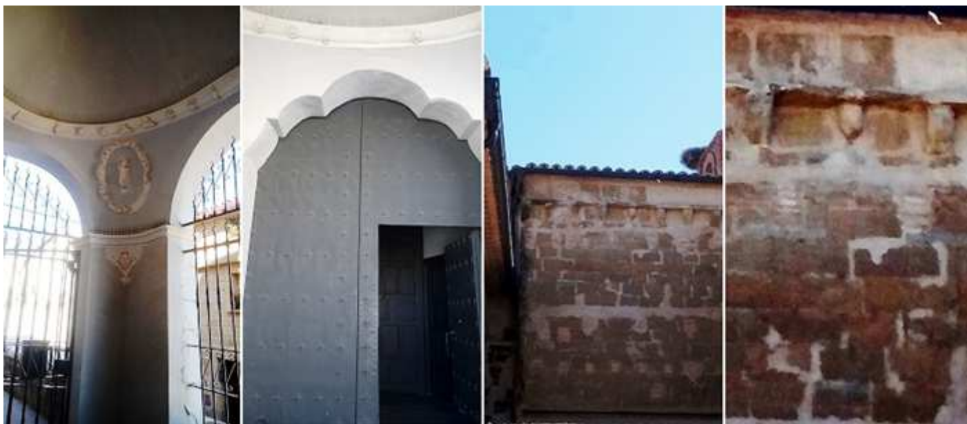
❶ El interior del pórtico cuenta con un casquete semiesférico y en las enjutas de los arcos decoración en relieve de yeserías. ❷ El arco de su puerta de entrada es polilobulado. ❸ En el muro norte del templo, entre las construcciones adosadas, hay un espacio que permite apreciar un trozo del muro original. ❹ Con su antiguo alero con modillones y canecillos muy deteriorados. Fotos: Pilar Grasa.
