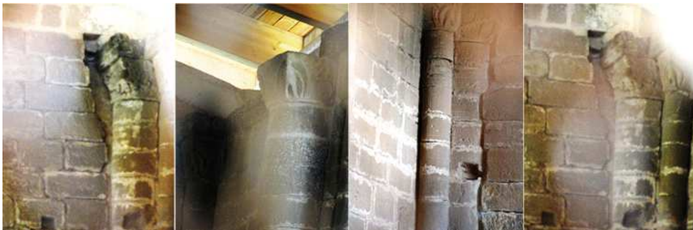
❶ Se conservan en la nave las diferentes columnas semi y redondas con sus capiteles. ❷ - ❸ - ❹ Diferentes detalles de las columnas acodilladas que hay en la cabecera del templo.
