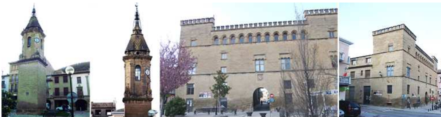
1 - 2 Es la torre del Reloj 1798-1799 de dos cuerpos. 3-4 Palacio de los Urries o de los Marqueses de Ayerbe, gótico renacentista, del que nos queda su fachada y del patio interior algunos restos de su lado este y sur de sus galerías.
