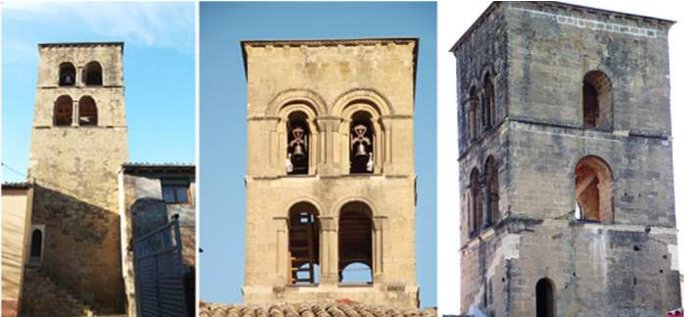
❶ Torre con su escalera de acceso, a su derecha está la sacristía que es una propiedad particular, con bóveda de cañón y restos de pinturas fechadas en 1567. ❷ Esta parte y la opuesta de la torre se abren arcos geminados superpuestos con columnillas. ❸ El otro lado de la torre. (para comprender la situación, la 2 es la izquierda de la 1 y la 3 la izquierda de la 2)
