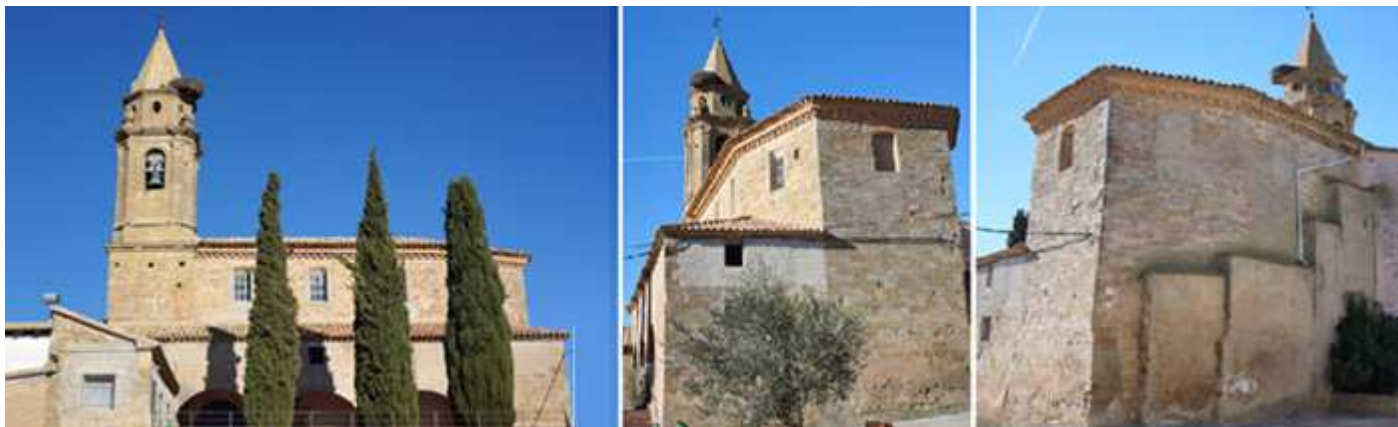
❶ La torre consta de dos cuerpos, a partir del primero su planta se convierte en octogonal con un piso para el campanario y sobre este uno más pequeño con óculos en sus caras y culminada con chapitel prismático. ❷ Su cabecera con tres lados. ❸ Lateral de la cabecera, presbiterio y lado del Evangelio. Fotos: Fotos: Marta Puyol Ibort / Archivo Fotográfico Hoya de Huesca (SIPCA – www.sipca.es )
