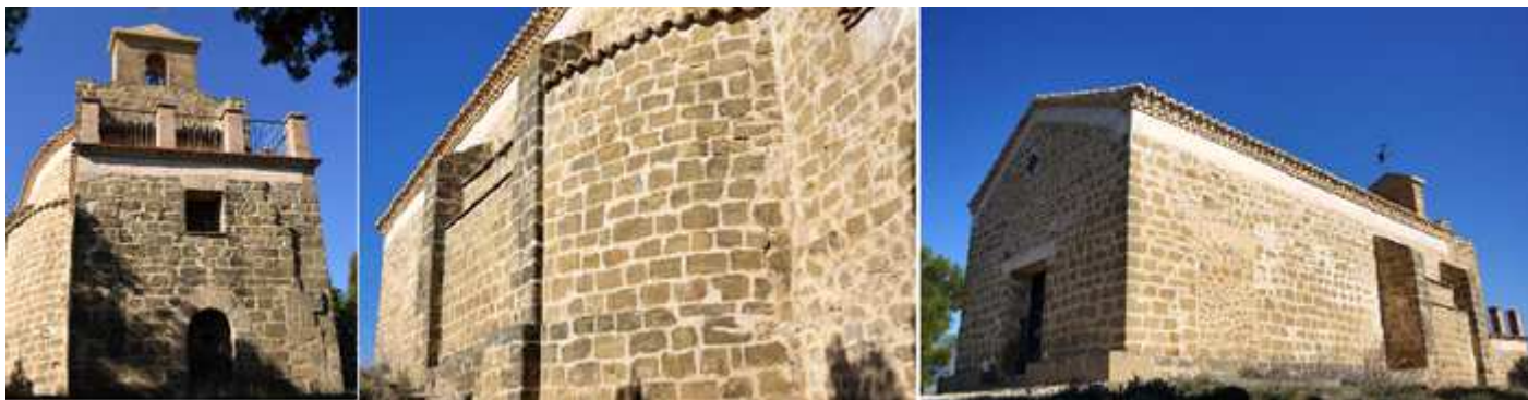
❶ La vivienda construida (la casa del Santero) y adosada a su cabecera original del templo semicircular. ❷ El lado actual de la Epístola y el tramo al descubierto de su cabecera. ❸ Su nuevo hastial con una puerta adintelada y la parte ampliada de este lado. Y con otra puerta cegada. Fotos: Marta Puyol Ibort / Archivo Fotográfico Hoya de Huesca (SIPCA – www.sipca.es )
