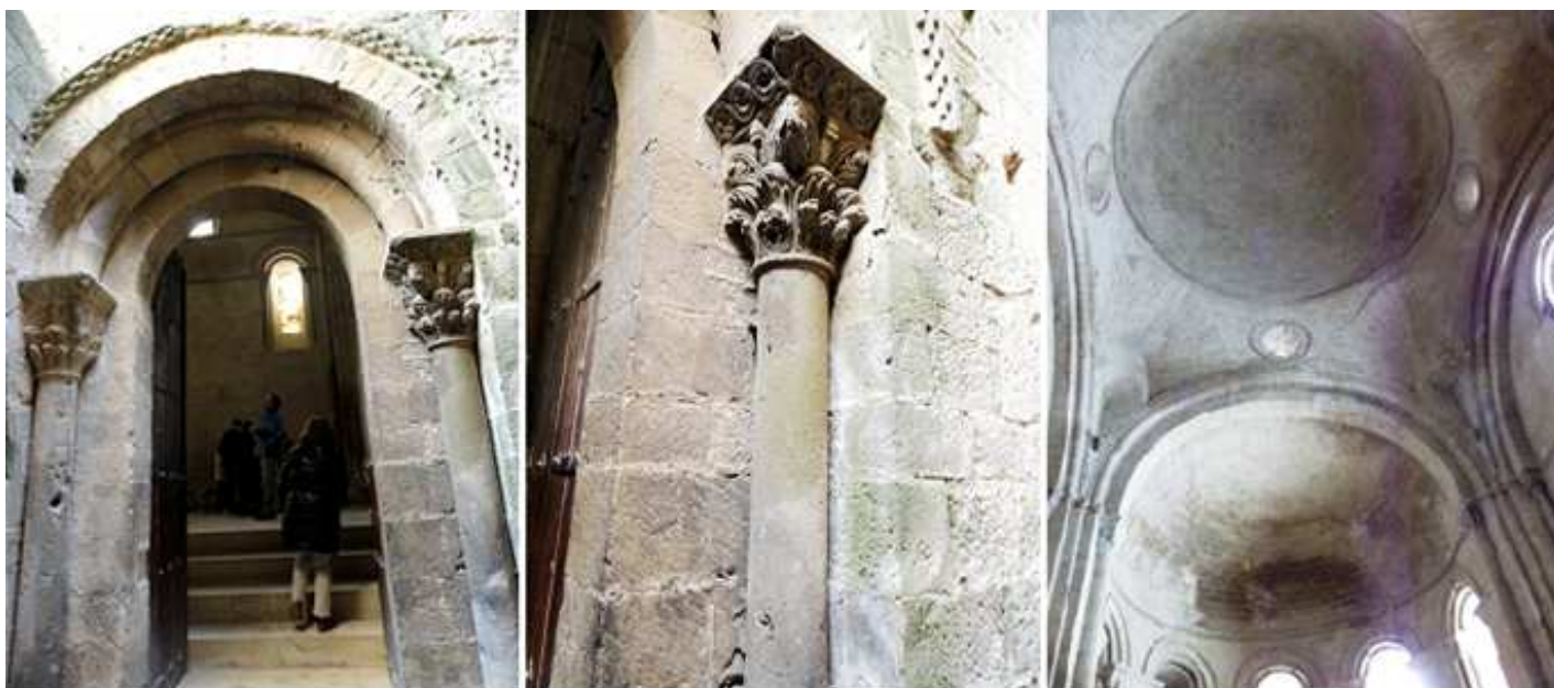
❶ Portada de la iglesia de San Pedro. ❷ Con hermosos capiteles con hojas de acanto sus columnas. ❸ Detalle de la cúpula, soportada por cuatro trompas, y por arcos torales
