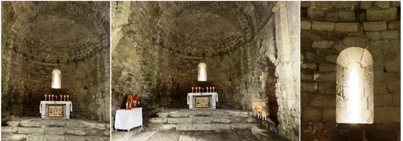
1 Cabecera elevada con tres escalones. 2 A los lados se aprecian los arcos apuntados de sus respectivas capillas, que actualmente están cegados. 3 Su ventana de medio punto con derrame interior. Fotos: Javier Torres.
