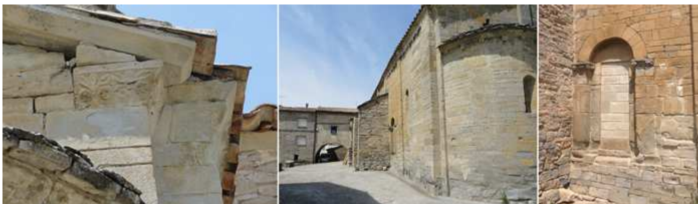
❶ Detalle decoración sobre el ángulo del presbiterio. ❷ Los contrafuertes del lado epistolar. ❸ Portada con un arquivolta dovelada sin decoración y descansan sobre jambas con un ábaco que en sus ángulos poseen cabezas de pájaro y figuritas humanas. Las jambas interiores sostienen un tímpano con una cruz griega y motivos alegóricos (una cruz trifoliada dentro de dos círculos a la izquierda y un dragón a la derecha ambas en la parte inferior), y la inscripción PETRUS sobre el arco y MAR sobre el brazo derecho horizontal.
