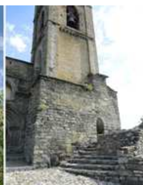
❶ Su torre abierta en el tercer cuerpo con ventanas apuntadas. Con uno o dos vanos por cara, con arquillos trilobulados junto a las impostas. ❷ Construcción de la abadía junto a la torre y el ábside. ❸ En esta parte inferior de la torre posee una puerta.
