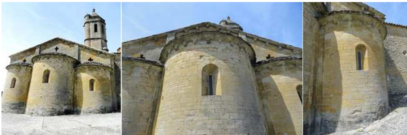
❶ Vista de sus tres ábsides que cuentan cada uno con una ventana con derrame exterior. ❷ Los ábsides son de una altura más baja que las naves. ❸ Ábside de la nave del Evangelio.
