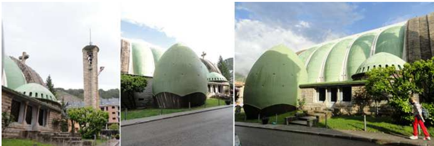
❶ En este lateral se encuentra el baptisterio con una bóveda semicircular con pequeñas ventanas alrededor de la misma. ❷ Parte exterior del Evangelio donde se puede apreciar los anillos de sus bóvedas y la capilla junto a su derecha el baptisterio.
