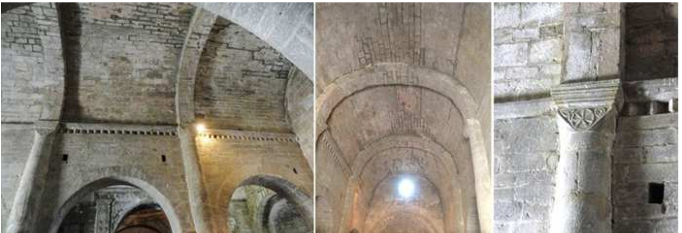
❶ Detalle de los arcos fajones de la nave central. ❷ Y de su bóveda. ❸ Columna, capitel y arco fajón de esta nave lateral en su tercer cuerpo.
