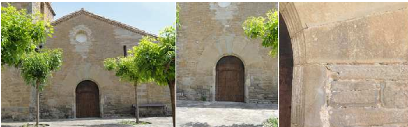
❶ Fachada a los pies del templo. ❷ Puerta de medio punto con dovelas lisas salvo el interior. ❸ Detalle de sus dovelas y en el lado izquierdo cuenta con esta pieza decorada con espiguillas.
