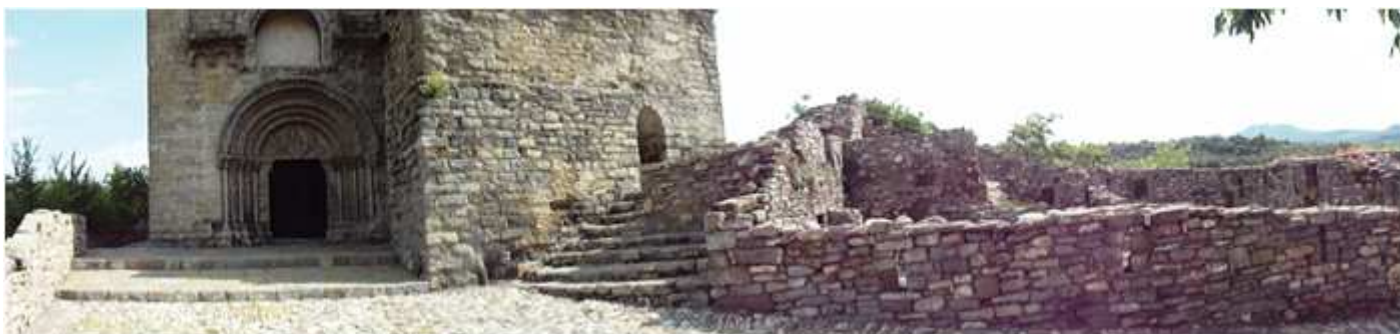
❶ Panorámica del templo y a la derecha las ruinas de parte de su abadía.
