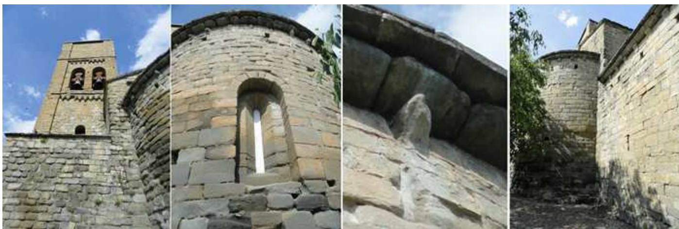
❶ La torre desde este lado de la cabecera. ❷ Con un sencillo ábside con una ventana de aspillera con derrame dentro de un arco de medio punto de arista viva. ❸ Bajo su alero con canecillos, que todos están tan erosionados que no se aprecia su estilo. ❹ Lateral a la derecha con una capilla.
