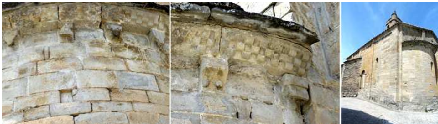
❶ Detalle del alero de uno de sus ábsides. ❷ Decorado con una ancha moldura con taqueado jaqués y canecillos con distintos motivos. ❸ Ábside y lateral de la Epístola.
