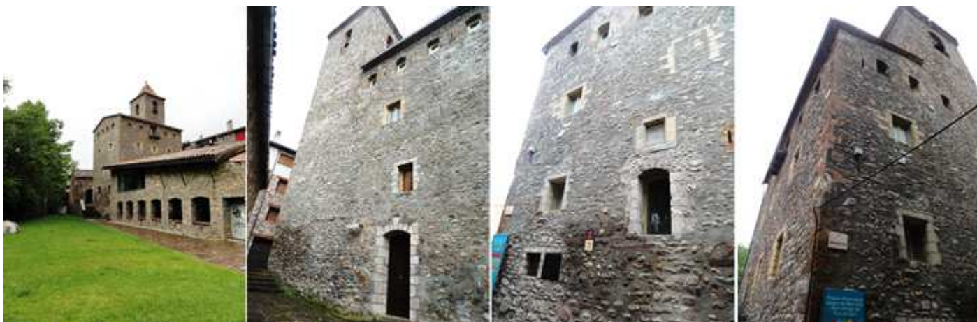
❶ Al fondo de esta campa el Palacio Abacial con su torre ❷ Dispone de ventanas mayormente adinteladas y de forma irregular dispuestas sobre las fachadas. ❸ Otro lateral, está cubierto con teja árabe a dos aguas. ❹ Este lateral da a la calle que continua con la pasarela que cruza el río.
