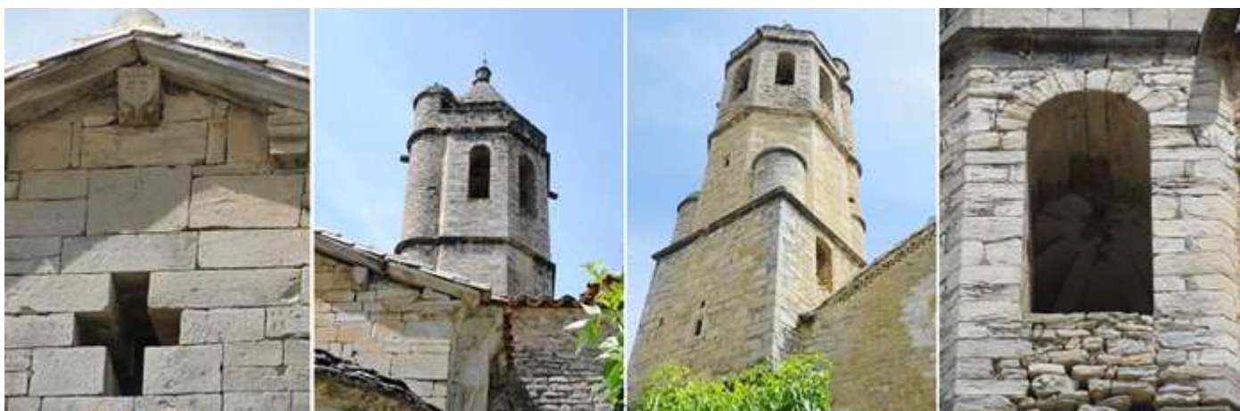
❶ Ventana cruciforme en el presbiterio central, y lo mismo ocurre en las otras dos naves laterales. ❷ En el exterior de los tres cuerpos octogonales dispone de una escalera de caracol. ❸ La torre de planta cuadra y octogonal, posee tres campanas de los años 1613, 1726 y 1849. ❹ Detalle de uno de los ventanales del campanario.
