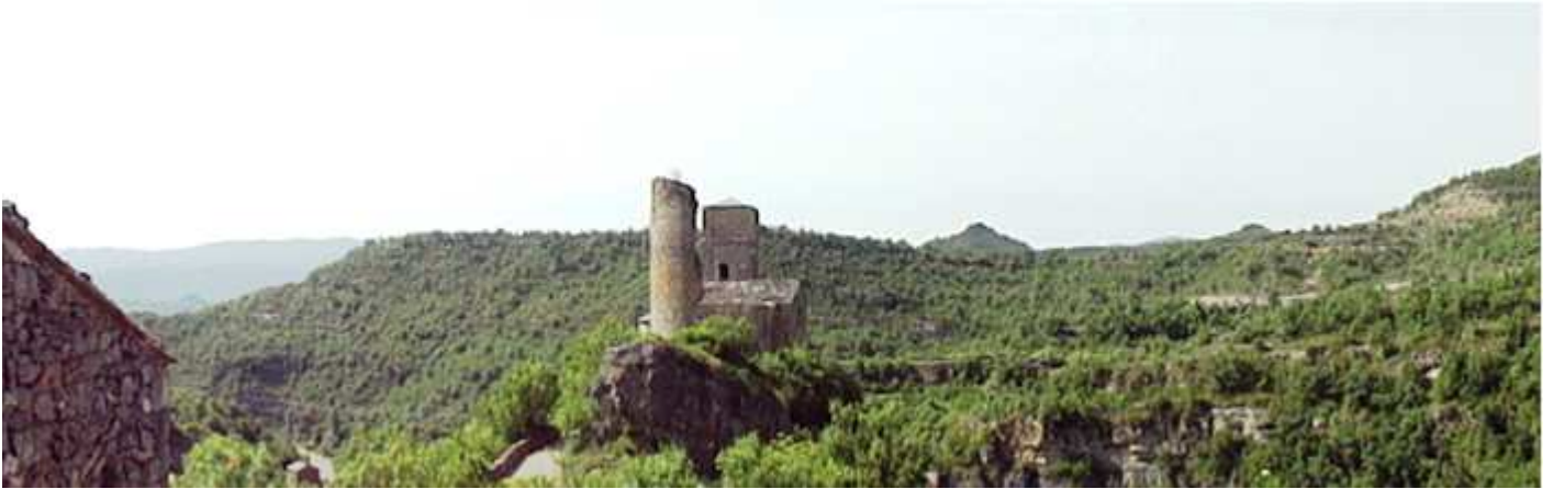
1 Panorámica desde la puerta del cementerio.
