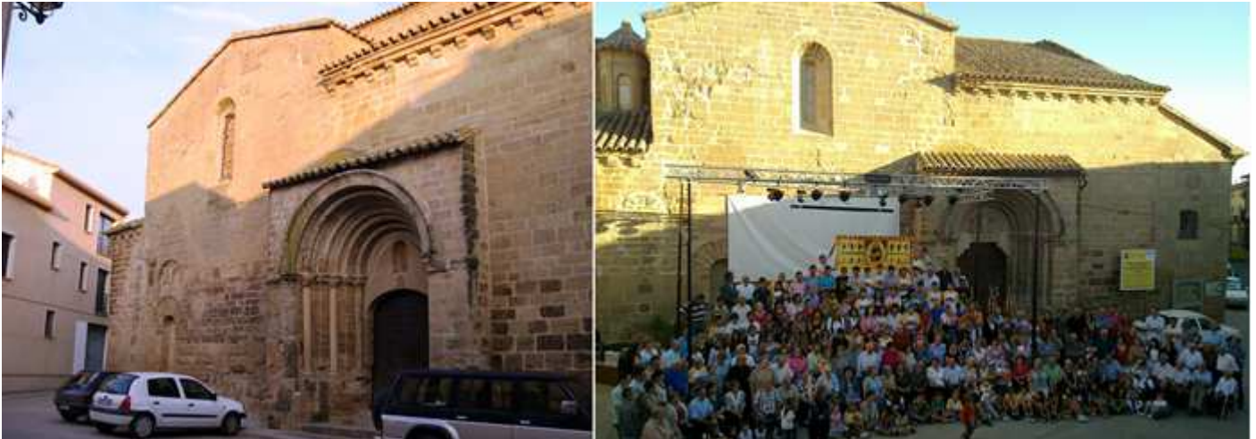
1 Fachada de la Colegiata antes de la reforma de su portada. 2 Instantánea con la reivindicación de las piezas de la Franja entre las que se encuentra el frontal del altar. Foto Ayuntamiento. En esta foto el pantocrátor ya se encuentra sobre la portada
