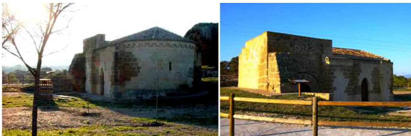
① Parte posterior con el ábside abierto con una ventana y bajo su alero una serie de canecillos. ② Lateral de la epístola con sus dos puertas. Fotos Ayuntamiento.
