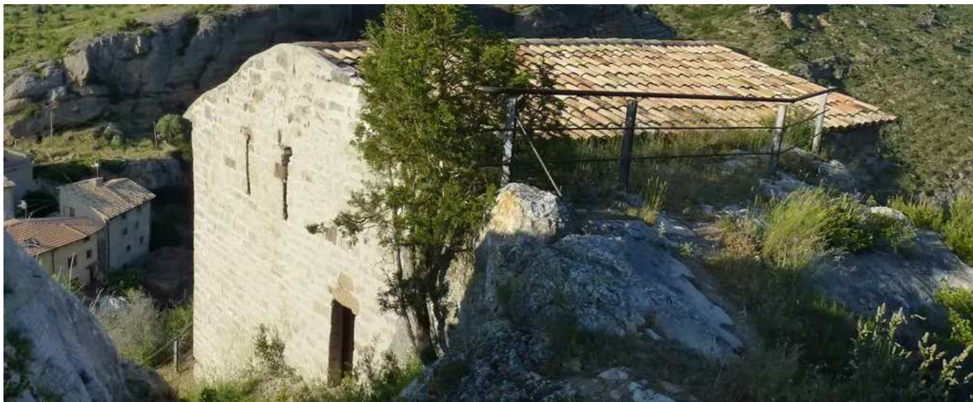
① Hastial de la ermita abierto con dos estrechas ventanas y puerta adintelada con una cubierta a dos aguas. Foto: bailandoconsarrios.com https://saritaymane.blogspot.com/2013/06/via-ferrata-santo-cristo.html
