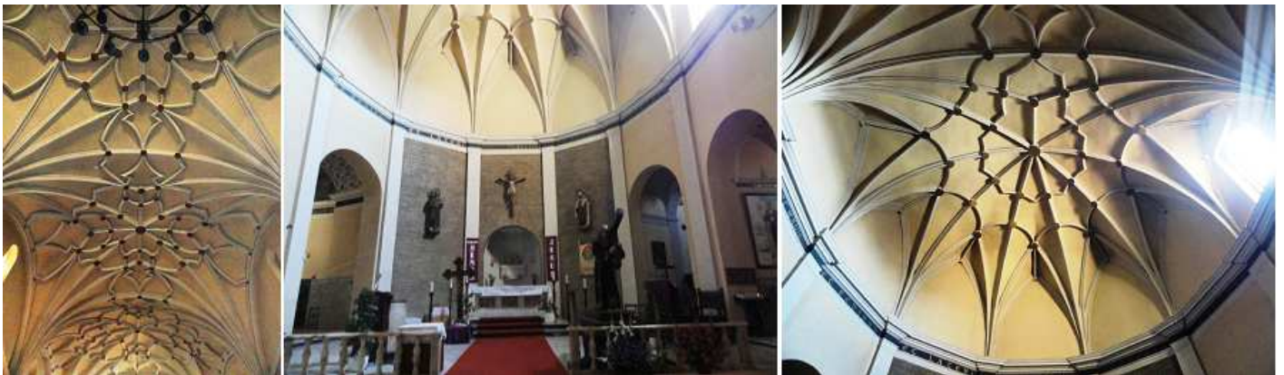
❶ Bóveda estrellada. ❷ Cabecera del templo. ❸ Y la bóveda de la misma.
