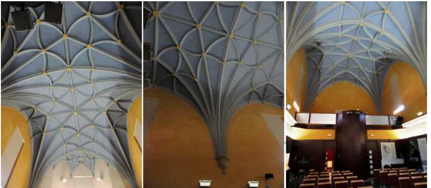
❶ Su bóveda de crucería. ❷ Un arranque de los nervios de la crucería, desde una ménsula. ❸ Parte de la cabecera plana del templo.
