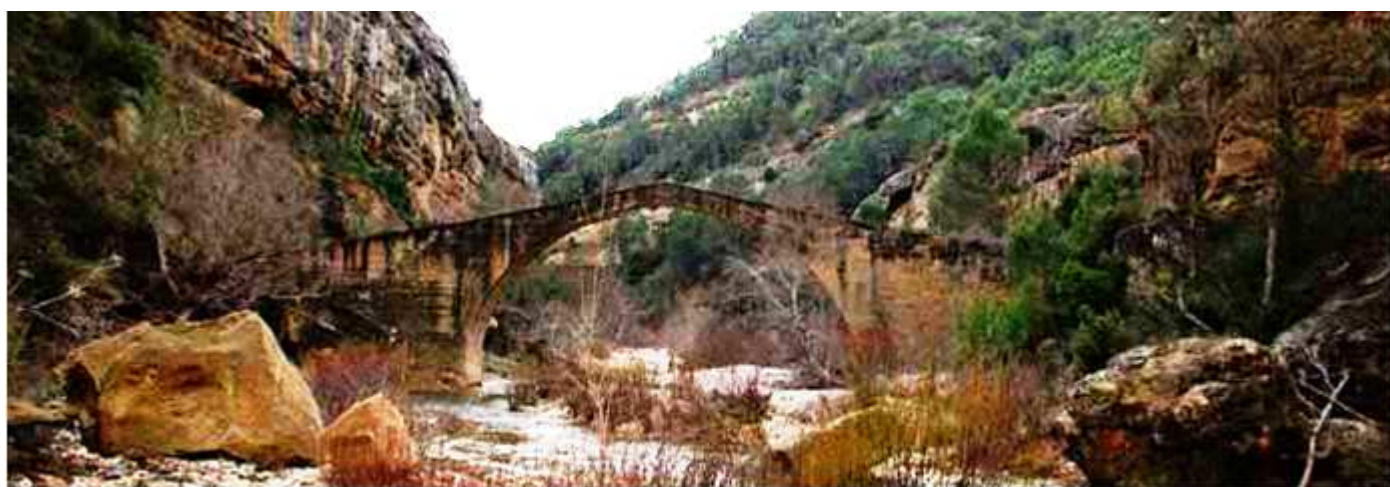
📍 Posee un solo arco, en su intradós conserva tres mechinales a cada lado de cuando su construcción. Foto: Ayuntamiento.
