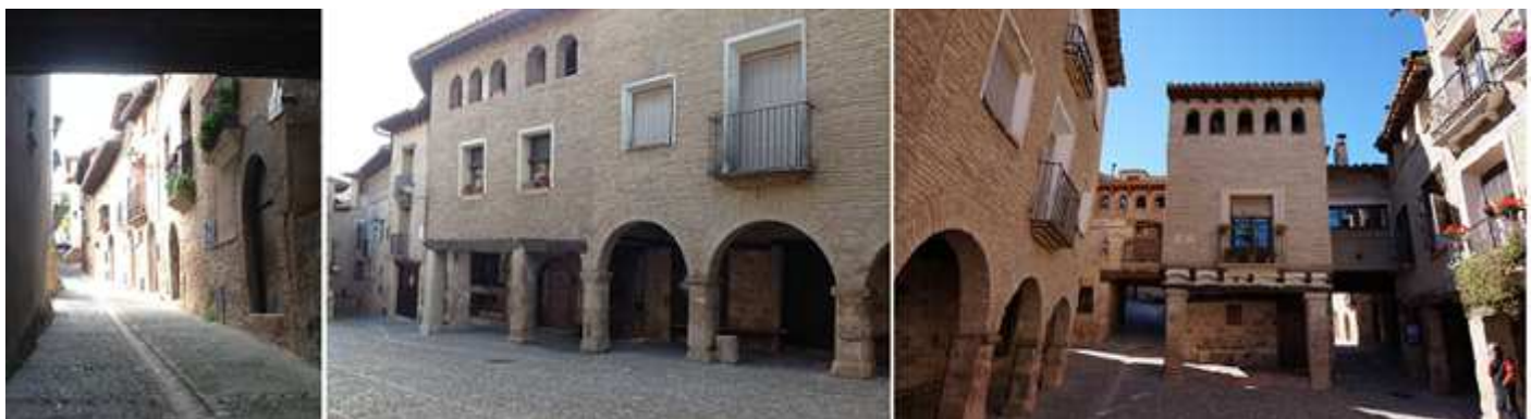
❶ Vista desde los soportales de la calle perpendicular a la misma. ❷ Un lateral de la plaza Mayor con los dos tipos de soportales. ❸ Imagen de la plaza con los dos carrizos que tiene a ambos lados esta casa
