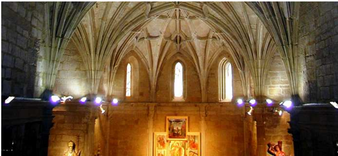
📍 Detalle de su cabecera poligonal con bóveda de crucería estrellada y ventanales apuntados, con las formas góticas. Y un retablo dorado de tres calles con pinturas. Foto: Ayuntamiento.
