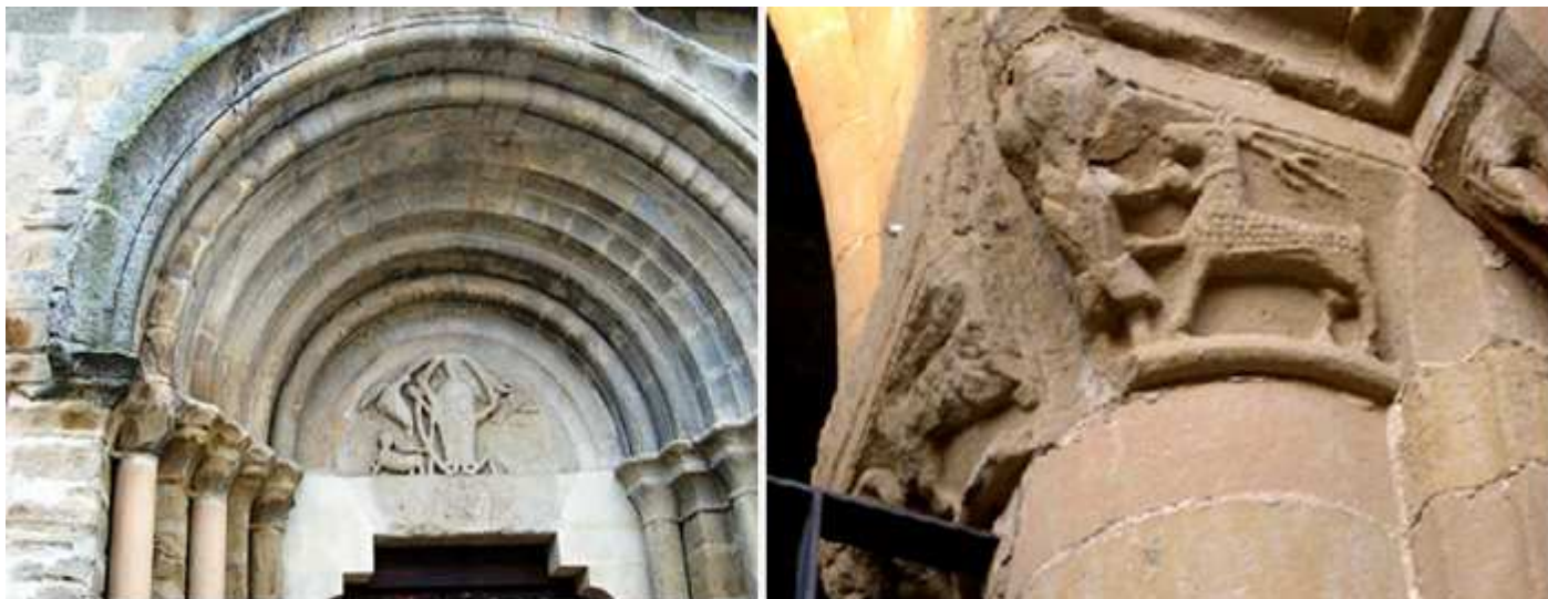
❶ Portada con la incorporación del tímpano que existía en su fachada. ❷ Detalle de unos de los capiteles del pórtico. Fotos Ayuntamiento.
