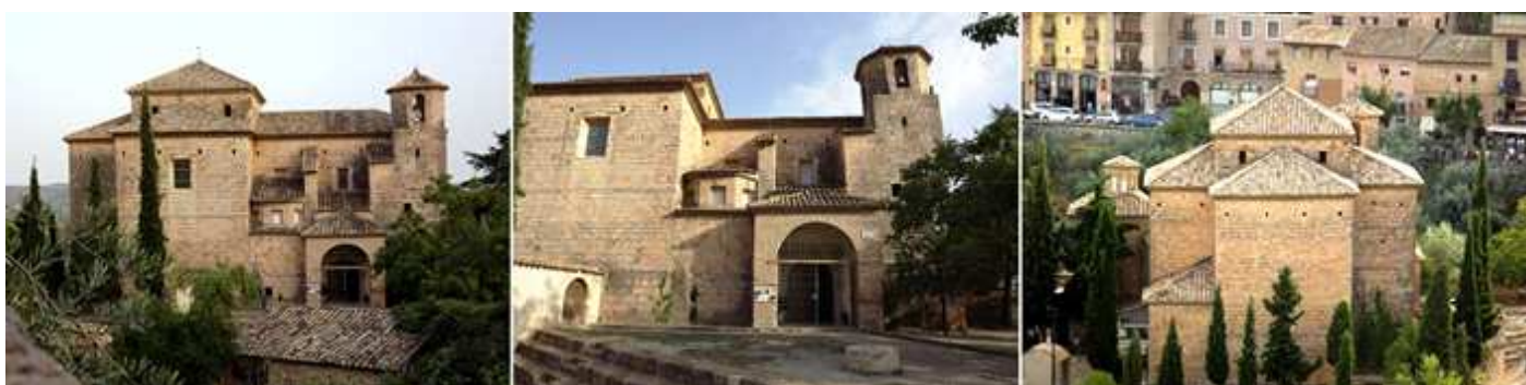
❶ Iglesia de San Miguel construida en piedra sillar. ❷ Su entrada en el lado del Evangelio, bajo un pórtico, y con su torre a los pies del templo de planta cuadrada y su último cuerpo para el campanario octogonal. ❸ Imagen exterior del crucero del templo, tomada desde el castillo.
