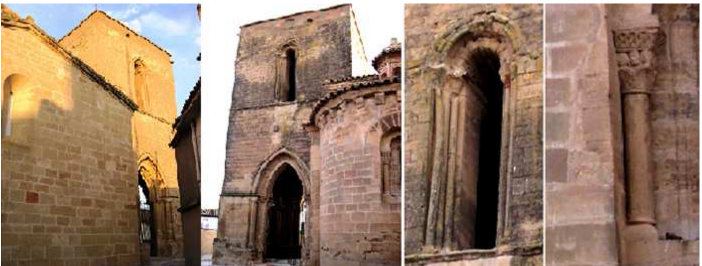
1 Lateral del templo y su torre pórtico con arcos apuntado y bóveda de crucería. 2 Torre adosada a los ábsides. 3 Ventana de medio punto con dos columnillas. 4 Detalle de la columna y capitel del ábside lateral
