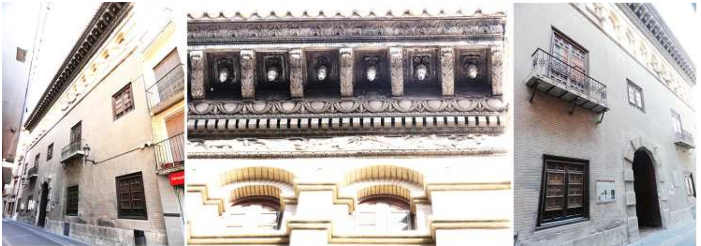
1 Palacio Argensola. 2 Artesonado de su alero, con exuberante decoración de hojas de acanto, piñas, ovas y dardos... 3 En la última planta una galería de arcos. Contaba con una monumental escalera que desapareció en la reforma del 1962.
