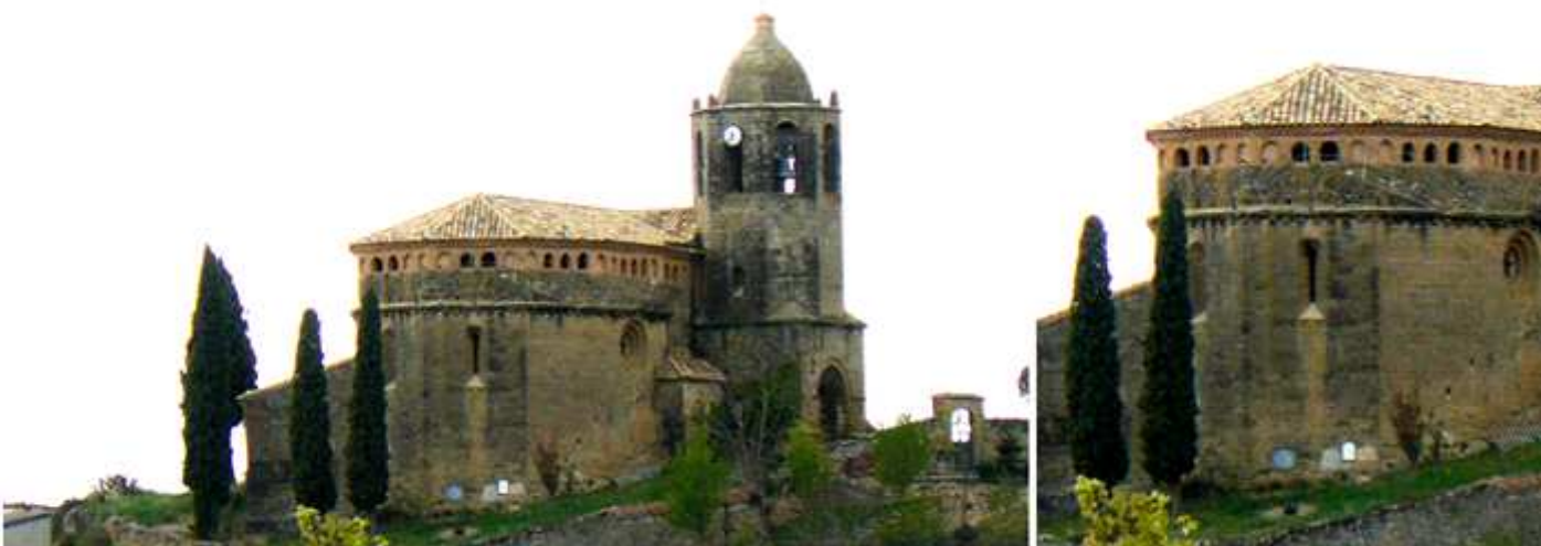
1 Panorámica de la iglesia con el recercamiento i la torre adosada al lado del Evangelio. 2 Con un ábside poligonal con contrafuerte y ventanas alagadas con derrame. Fotos CC BY-SA 3.0
