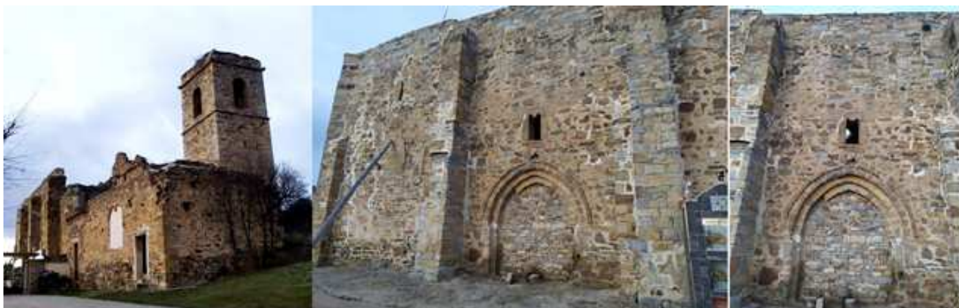
❶ Cabecera con las construcciones anexas y la torre. ❷ Lateral del muro de la Epístola con su puerta cegada en el segundo tramo de la nave. ❸ Y su puerta de arco apuntado con tres arquivoltas con un fino baquetonado en su arista interior, que descansaría en una imposta corrida inexistente, y cubierta con un guardapolvo con puntas de diamante. Sobre la puerta una sencilla ventana bífora a la que le falta su mainel o columnilla central. Fotos: Carlos Escribano Barrio.
