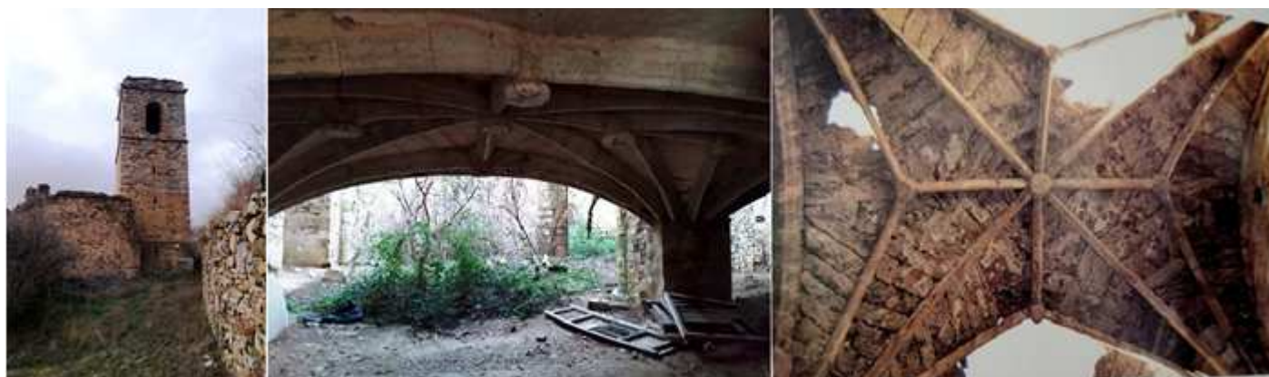
❶ La cabecera de la nave izquierda y su torre adosada. ❷ Desde los pies del templo sobre unos arcos rebajado del coro. ❸ Uno de los tramos de bóveda de crucería que subsisten. Algunas claves de sus nervios con rosáceas y flores. Fotos: Carlos Escribano. Barrio.
