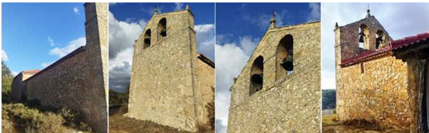
1 Exterior del lado del Evangelio. 2 En su hastial se alza una espadaña con dos vanos para las campanas de fabricación moderna se llaman Santa Bárbara y San Pedro, de 1895 y 1948 respectivamente. 3 Con un remate triangular y con pináculos. 4 El tramo meridional hasta el pórtico abierto de su entrada. Fotos: Sergio Fernández Barranco.
