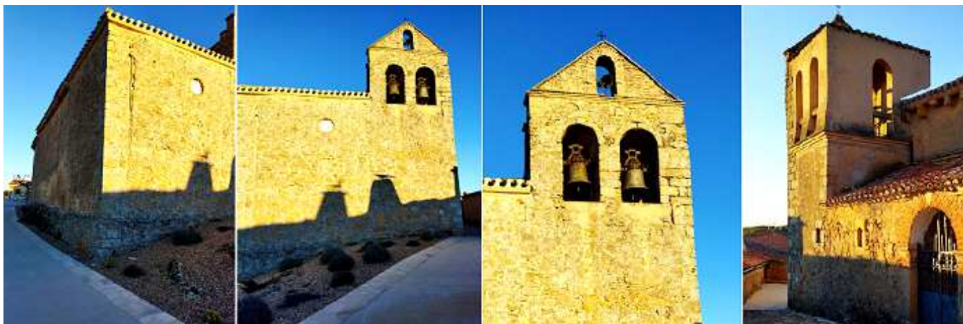
❶ Lateral exterior del Evangelio. ❷ Fachada a los pies dispone de un pequeño óculo. ❸ Y a la derecha una espadaña con dos grandes vano y uno más pequeño. ❹ Los vanos de la parte sur y este mucho más amplios y esta parte del campanario sobre el cuerpo anterior separado por una imposta. Fotos Sergio Fernández Barranco.
