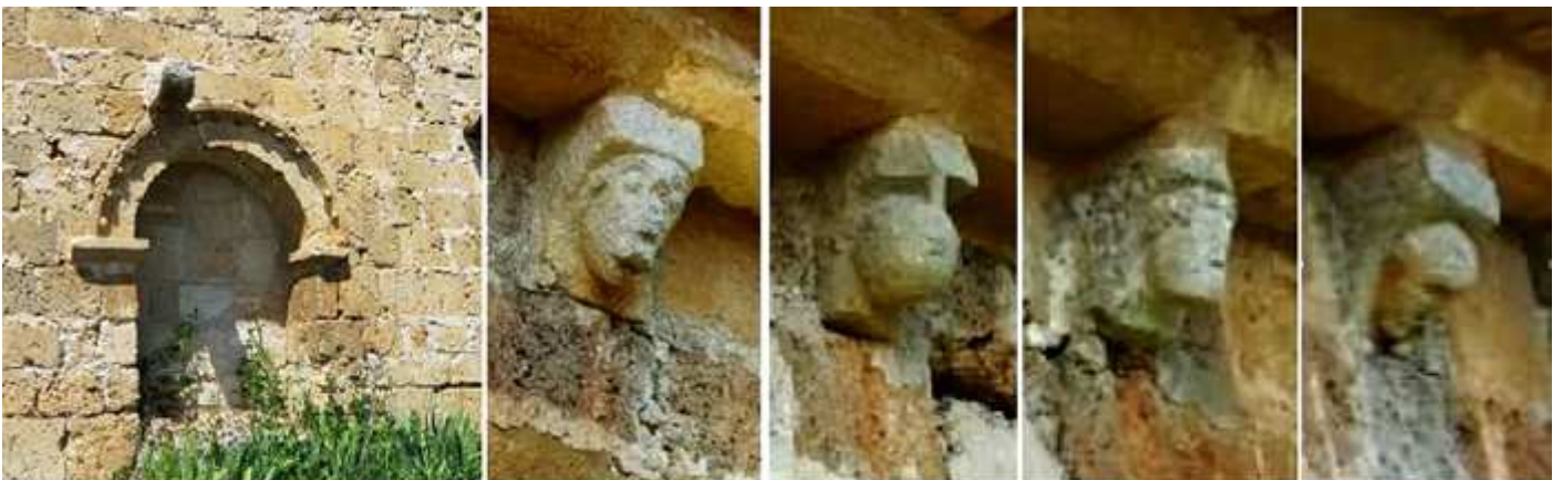
❶ La puerta de la Epístola, en este lateral se aprecia la parte inferior construida con sillería y la superior con piedra irregular. ❷ Cara con unos vivos ojos. ❸ Una bola pende del canecillo. ❹ Cara humana muy esquemática. ❺ Otra cara humana. Fotos Ayuntamiento.
