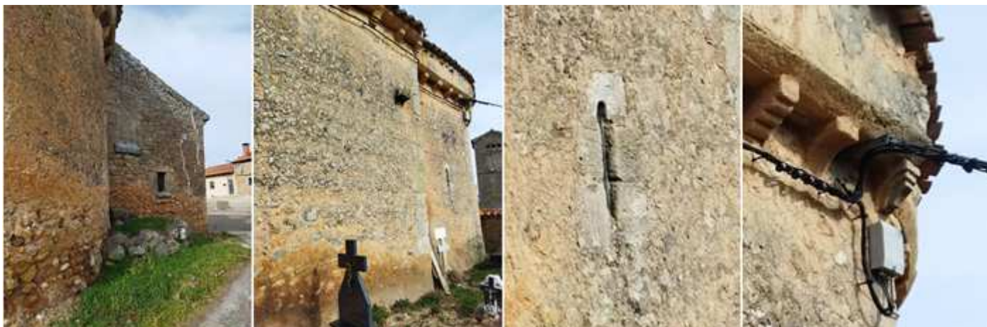
1 Detalle de la sacristía adosa con una ventana adintelada y otra más arriba de medio punto cegada. 2 Esta parte sur da al cementerio. 3 Ventana de aspillera del presbiterio. 4 Detalle de los últimos canecillos del presbiterio junto a la cabecera. Fotos Sergio Fernández Barranco.
