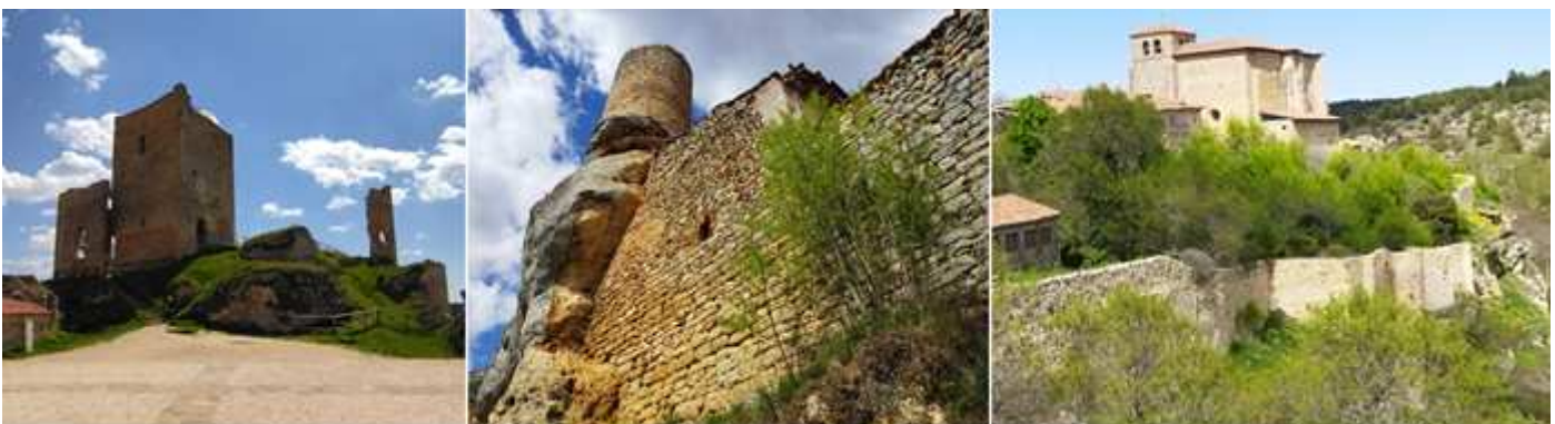
❶ Planicie ante los restos del castillo. Y en primer plano la torre del Homenaje. ❷ Detalle de un cubo del castillo sobre la roca y junto a los lienzos de las murallas. ❸ Las murallas se conserva preferentemente en las partes norte y este de la localidad. Fotos: Ayuntamiento.
