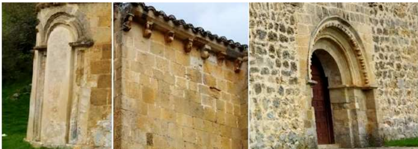
❶ Detalle de esta puerta cegada en la parte inferior del ábside. ❷ Posee una atractiva colección de canecillos con diferentes motivos con personajes, animales, figuras, etc., muy bien conservados, estos son los del presbiterio del lado de la Epístola. Cuenta también en la cabecera pero no los tiene en el alero de la nave ❸ Su puerta en este lado con tres arquivoltas sobre impostas y jambas rectas. Fotos: Ayuntamiento.
