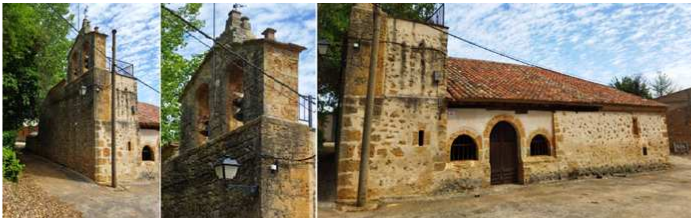
❶ A los pies se alza su sólida espadaña. ❷ Que cuenta con dos vanos de medio punto para sus campanas y tras ella una terraza para el volteo de sus campanas. ❸ En la fachada meridional dispone de una pequeña galería que cuenta con dos arcos y su puerta. Fotos Sergio Fernández Barranco.
