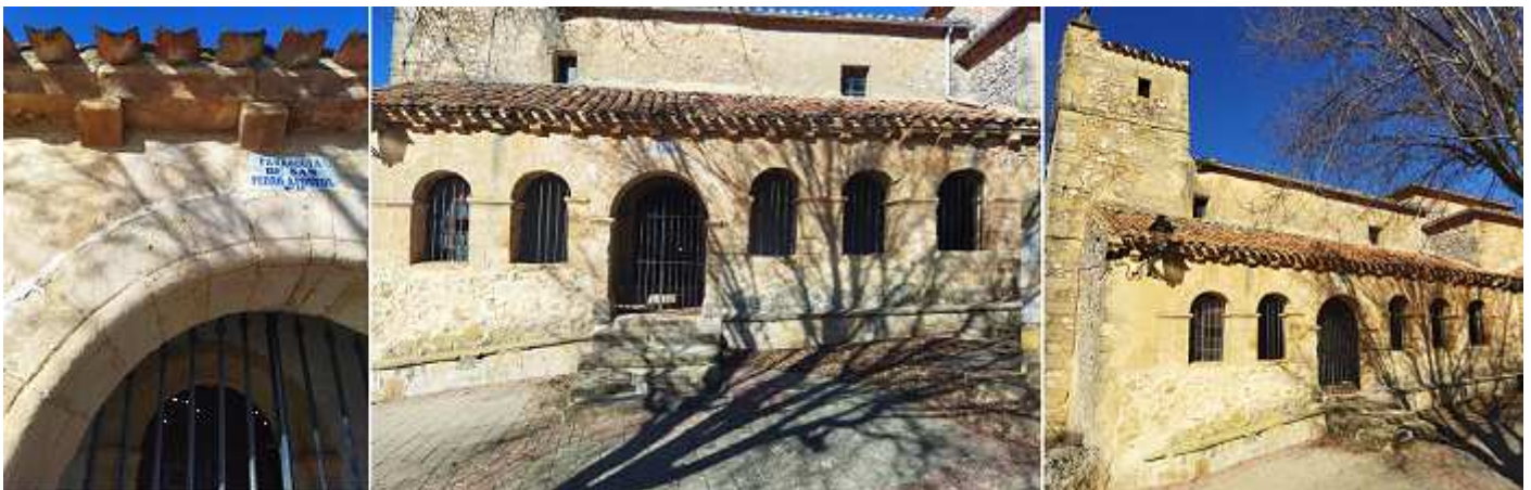
❶ El arco de entradas con baquetón de perfil fino. ❷ La galería compuesta por seis arcos de medio punto. . ❸ Cada arco con impostas de perfil de listel y sin columnas. Fotos: Sergio Fernández Barranco.
