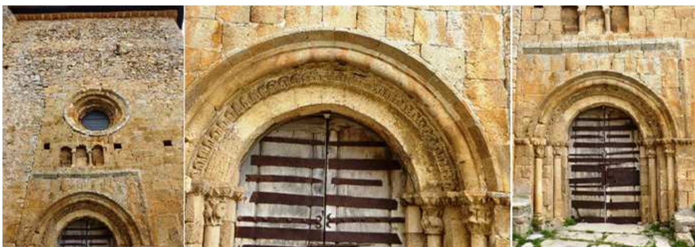
❶ Su portada occidental con un alfiz con un guirnalda ondulada y sobre ella tres arquillos (uno lobulado) ciegos con columnillas y capiteles vegetales. Encima un óculo baquetonado. ❷ Bajo su guarda lluvias dos arquivoltas, una con hojas de acanto y con perlas y la interior recta sobres imposta corrida con capiteles que exhiben animales y columnas. ❸ Sus capiteles muy degradados perimen apreciar sus animales en tres el 4º con hojas. Fotos: Andrés Ordoczynski .
