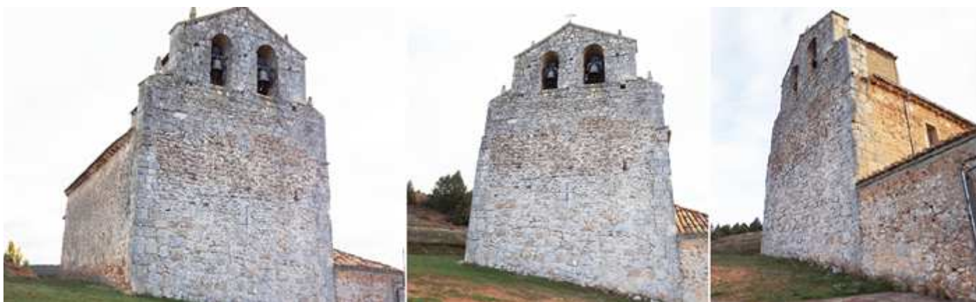
1 Su hastial con una fina aspillerera y culmina con una espadaña. 2 Con dos amplios vanos de medio punto para sus campanas. 3 En su parte posterior el habitáculo para tocar las campanas.
