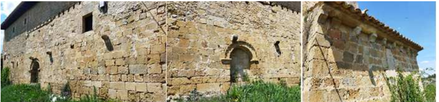
❶ Lateral del lado epistolar con su puerta románica cegada y que da al recinto del Campo Santo. ❷ Detalle frontal de la puerta. ❸ Alero con canecillos decorados en la parte en una construcción adosada al ábside del templo. Fotos Ayuntamiento.
