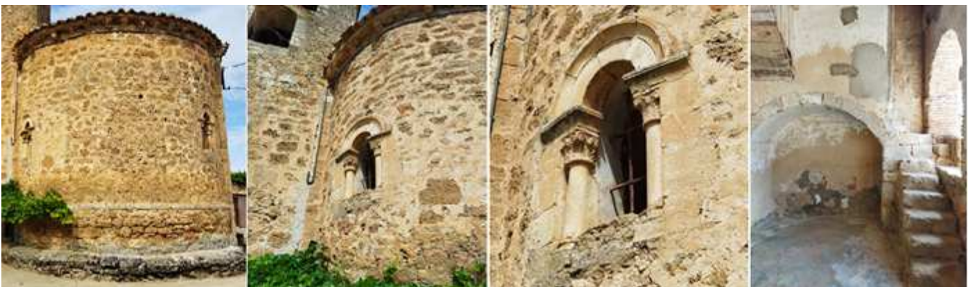
❶ Ábside con un pequeño basamento inferior y dotado con dos ventanas. ❷ Ventana del lado sur con arco de medio punto, con chambrana de nacela y columnillas laterales rematadas por capiteles, decorados hojas palmeadas. ❸ Primer plano de esta ventana. ❹ Arco en la galería en su lado este con la base de la torre. Fotos Sergio Fernández Barranco.
