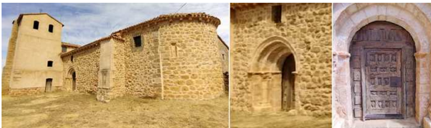
1 Fachada meridional del templo con la parte posterior de su espadaña adosada a los pies. 2 Su portada se abre en la parte central de su nave en el lado Epistolar. 3 Su puerta compuesta por tres arquivoltas sencillas las dos exteriores y de bocel la exterior, una se sustenta sobre columnillas y las otras dos sobre pilastras. Fotos Sergio Fernández Barranco
