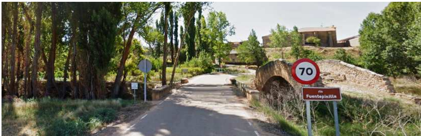
1 Panorámica con su antiguo puente románico de un solo arco y el cauce del río Fuentepinilla.
