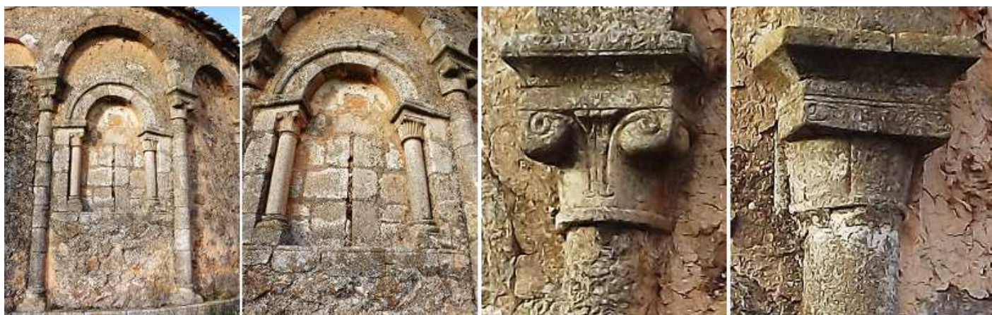
1 Detalle de su única ventana en el ábside en el arquillo central. 2 Con una arquivolta con guardapolvo sobre imposta y columnas con capiteles decorados, y en el centro una aspillera. 3 Los arcos ciegos descansan sobre capiteles decorados de distinta decoración y columnas redondas adosadas. 4 Otro capitel.
