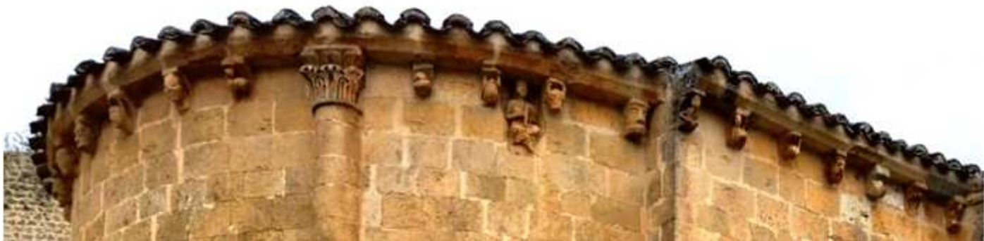
❶ Detalle de los canecillos que posee el templo en esta parte. Foto: Ayuntamiento.
