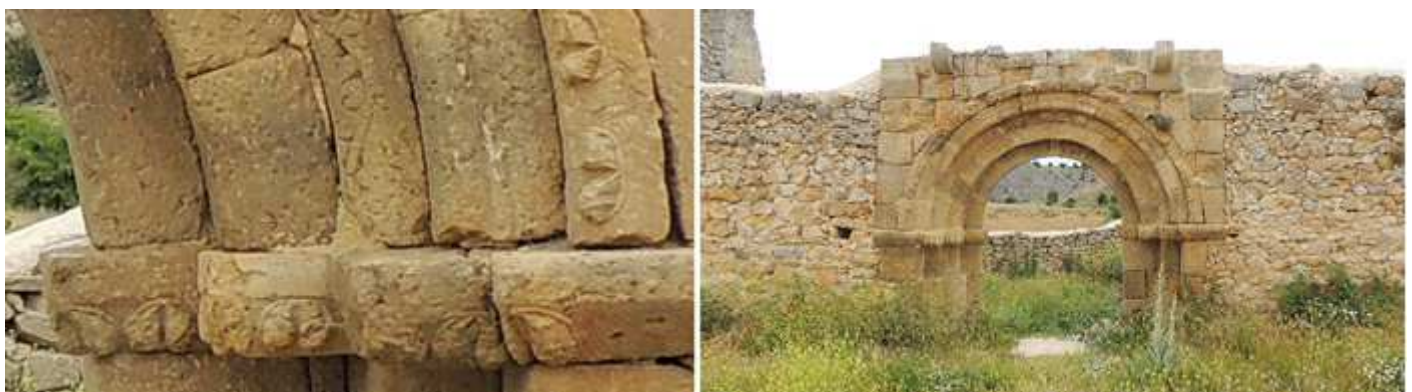
① Detalles en las impostas, y en la vaquetona interior y de su guarda lluvias. ② Puerta construida con piedra sillar con tres arquivoltas la exterior baquetonada y las otras dos de arista viva y cubiertas con un guardapolvo, todo ello descansan sobre una imposta corrida, presumiblemente las dos exteriores poseerían columnillas. Foto: Wikipedia. © De Borjaanimal, CC BY-SA 4.0,
