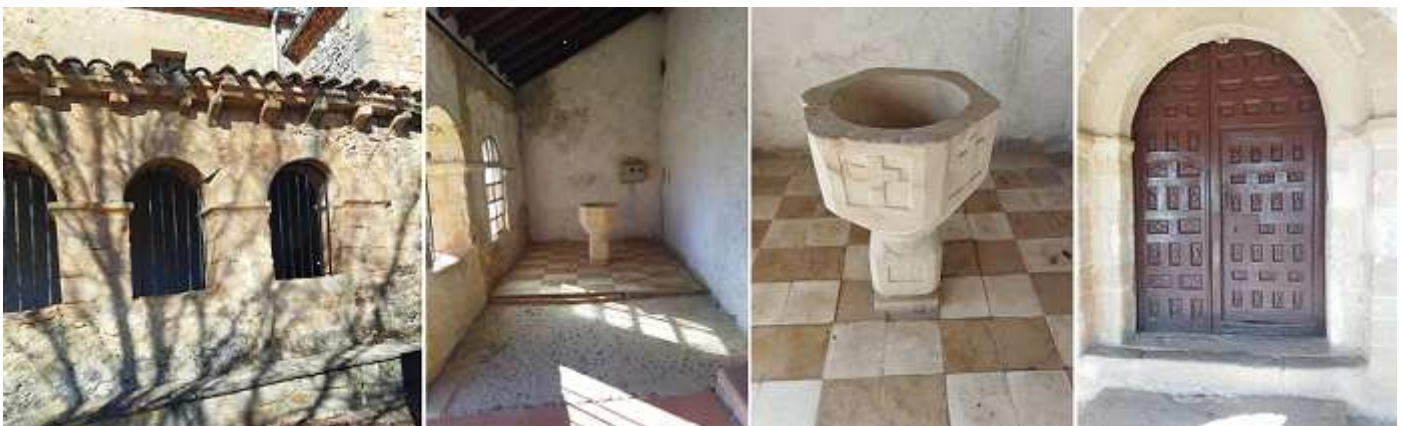
❶ La galería posee un alero con canchillos lisos. ❷ Interior de la galería con su pila bautismal. ❸ Pila de piedra blanca con hexagonal en cada cara dentro de un espacio cuadrada posee una cruz, con u pequeño fuste redondo con una gran basa cuadrada, su interior es una cavidad circular. ❹ Puerta románica del anterior templo. Fotos: Sergio Fernández Barranco.
