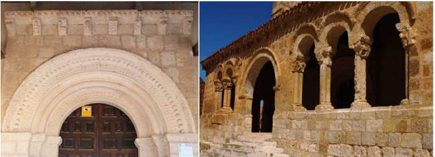
❶ Puerta con tejazar decorado con bolas y ocho canecillos decorados con bolas, hojas, rollos y animales figurados. En la parte central junto a su arquivolta exterior se aprecian los restos de un crismón pintado muy deteriorado e incluso tapado con cemento, trinitario de seis brazos, el central vertical de la P cubierto y lo mismo el inferior S, en los brazos superiores A a Alfa y \Omega \omega Omega pinjantes y todo rodeado de un aro también pintado. ❷ Los arcos de su galería se apoyan en capiteles y estos sobre dobles columnas de fuste monolítico. Fotos Camping Río Lobos.
