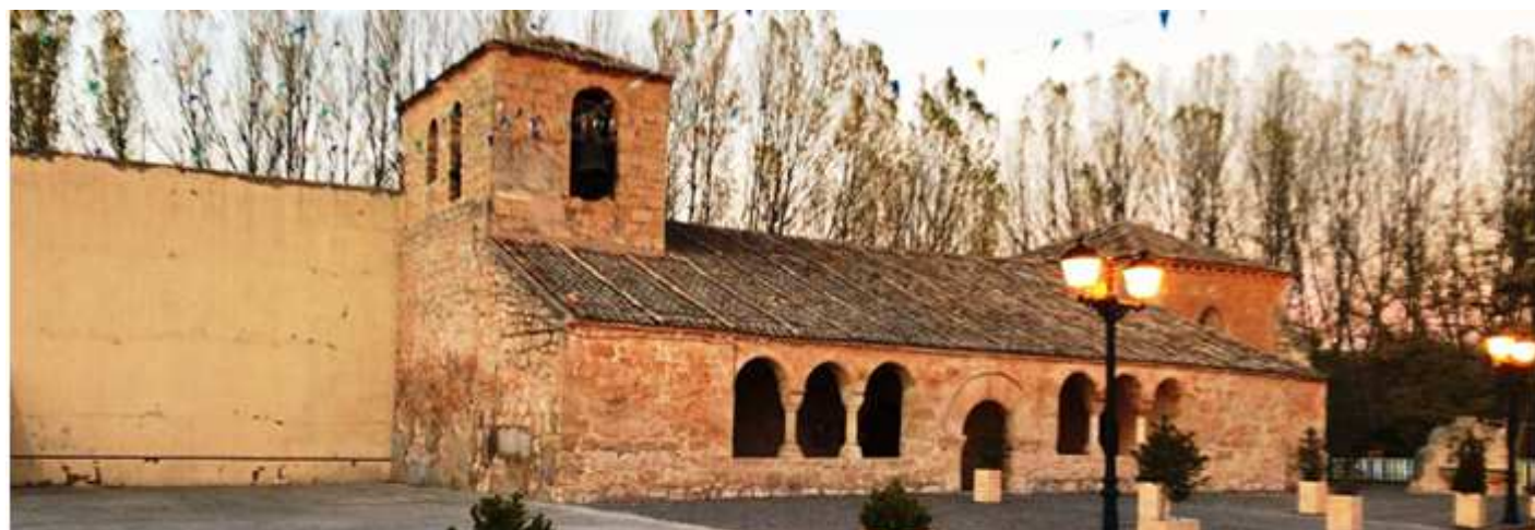
1 Su galería adosada a la nave del templo en su lado epistolar compuesta por seis arcos sobre el pretil dispuestos tres a cada lado de su puerta de medio punto con grandes dovelas y guardapolvo. Es una galería con reminiscencias románicas. Foto: Ayuntamiento
