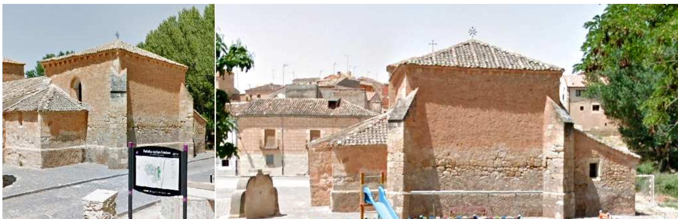
❶ Parte inferior del templo ❷ Su testero recto con grandes contrafuertes, es la parte del templo que está construida con mampostería. Faltan fotos: En el interior del templo: Capilla funeraria. Con la heráldica de D. Juan Sebastián y Ana Otañez
