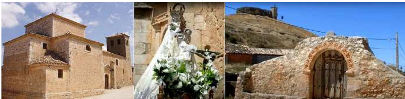
❶ Fachada de la iglesia con su puerta en el lado del Evangelio, y los volúmenes de su cabecera y crucero. ❷ Talla de la Virgen de Vallejo procesionando ante la puerta de la iglesia de San Esteban protomártir. ❸ Restos de una puerta románica con una arquivolta con flores excavadas. Fotos: Asociación Alcozar.
