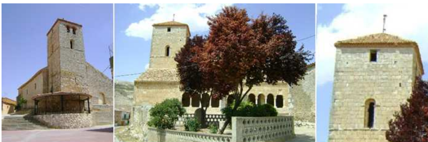
❶ En su hastial se levanta su torre de planta cuadrada de dos cuerpos y separados por una imposta corrida. El segundo cuerpo se abre con ventanas de medio punto, y el inferior de aspillera. Posee en dos de sus lados un pórtico abierto. En su interior no posee
