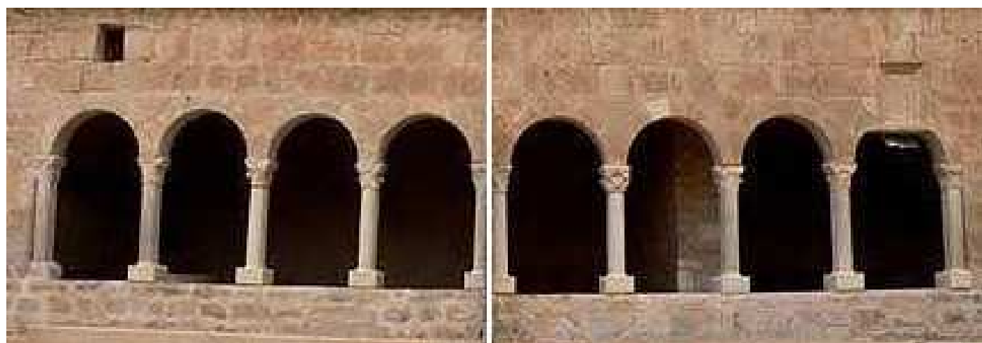
❶ Los capiteles de la galería donde encontramos: con motivos vegetales, Arpías, Caras femeninas, etc. ❷ Esta galería se mantuvo cegada hasta el año 2000. Los arcos de medio punto con columnas dobles sobre un pretil. Fotos: Ayuntamiento.
