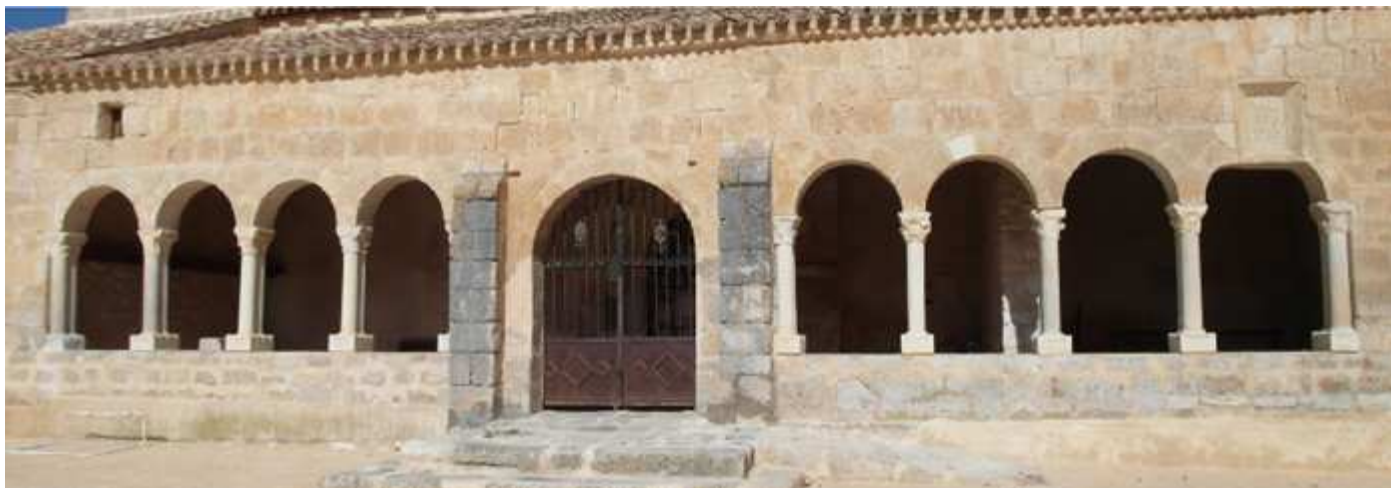
❶ La galería porticada cuenta con cuatro arcos a ambos lados de su puerta que está en el centro de la galería entre dos contrafuertes. Foto: Ayuntamiento
