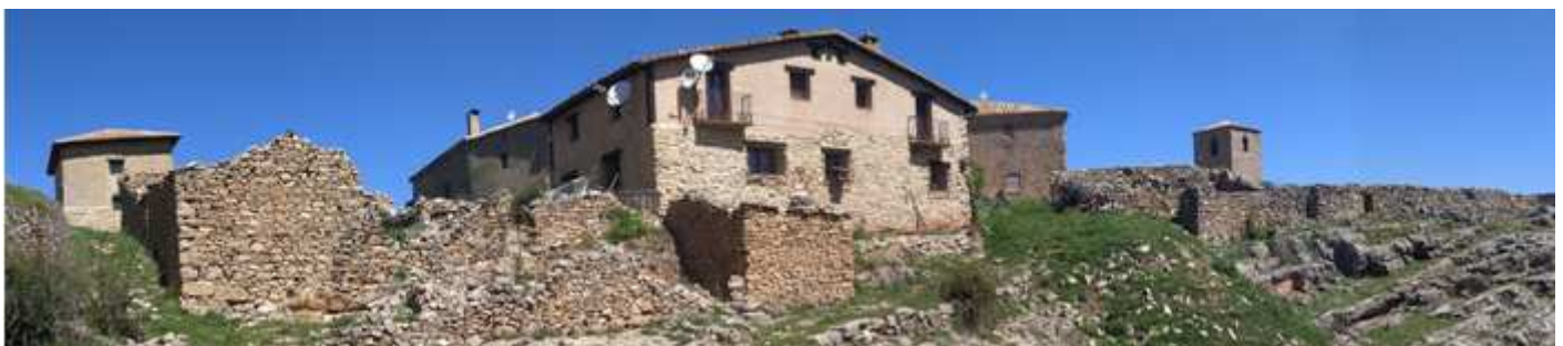
❶ Detalle de un pequeño tramo de las murallas. Fotos: Diego Pacheco Landero.
