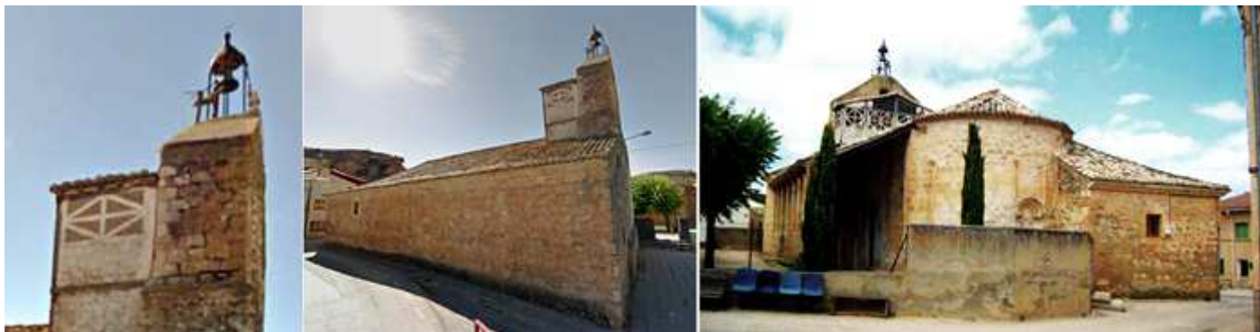
❶ Espadaña de tres vanos y un campanille metálico sobre la misma, en su parte posterior tiene el espacio para el volteo de sus campanas. ❷ Parte exterior del lado de Evangelio. ❸ Parte posterior del templo con su ábside semi-circular donde cuenta con una ventana con tres arquivoltas, con chambra taqueada y se encuentra cegada. Y seis columnas que conforman siete paños, alguna de ellas han desaparecido algunos capiteles y basamento. En su interior conserva algunas pinturas murales en el presbiterio y en el ábside donde tres ángeles están tocando con instrumentos arcaicos. Foto Ayuntamiento.
