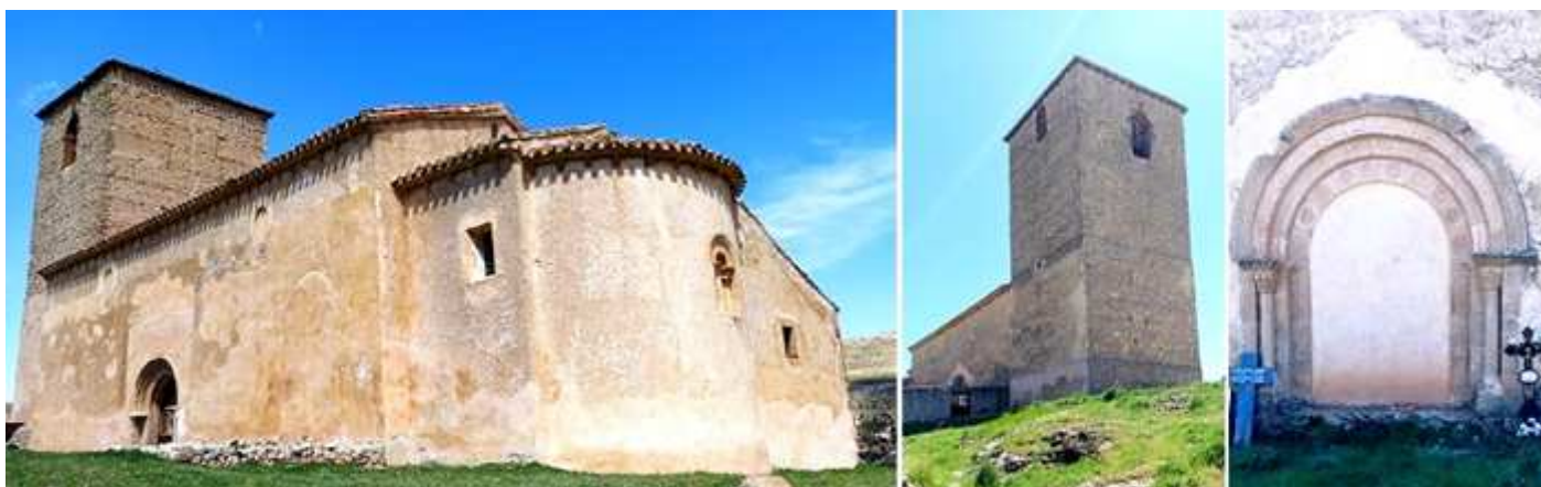
❶ Fachada sur, con su torre adosada a los pies, con la puerta de acceso en la parte central de la nave, con una ventana adintelada en el presbiterio y otra en el cilindro absidal con una arquivolta con decoración de lazos y capiteles historiados sobre columnillas. ❷ En el lateral norte la nave sobre su puerta posee dos óculos redondos y la torre adosada. ❸ Puerta cegada en la fachada norte que da al Campos Santo local. Fotos: Diego Pacheco Landero.
