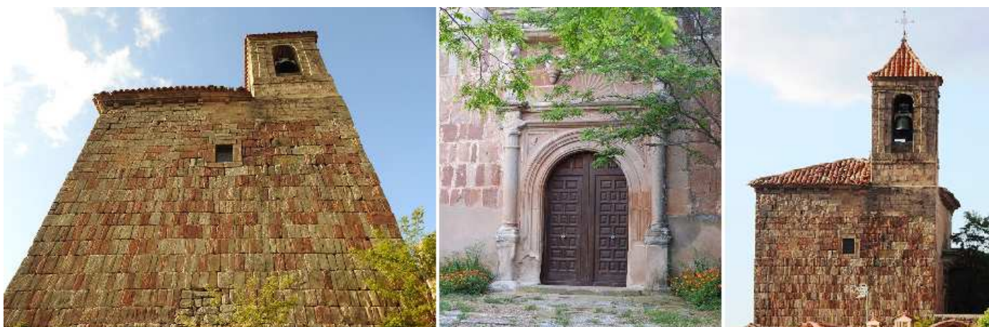
1 Hastial con una construcción de sus sillares a tizón. 2 Su portada plateresca con columnas acanaladas redondas adosadas a los lados. Sobre el entablamento una pequeña inscripción. Encima una venera en relieve... y cubierta con una gran visera de piedra. Al lado de la puerta tiene adosada una construcción. 3 Su torre se alza sobre el coro en el lado de la Epístola, con ventanas en sus cuatro lados (uno es distinto) y cubierta con un chapitel de tejas es de finales del S. XVI o principios del XVII. Fotos: Sergio Tierno.
