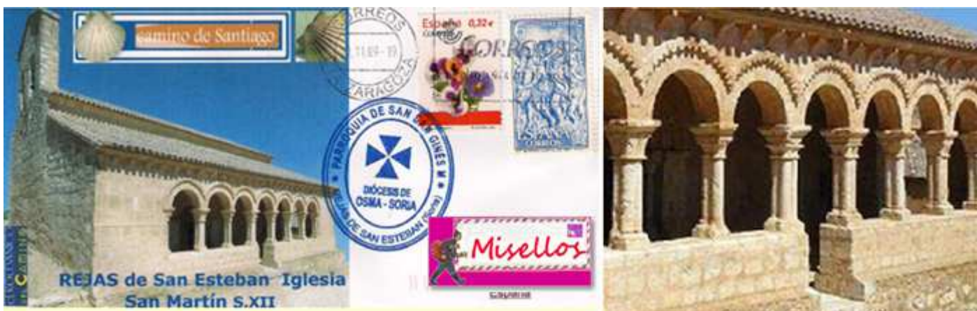
❶ Sobre circulado desde Las Rejas de San Esteban. ❷ Detalle de su preciosa galería, que en tiempos estuvo cegada. Y empleada como corral.
