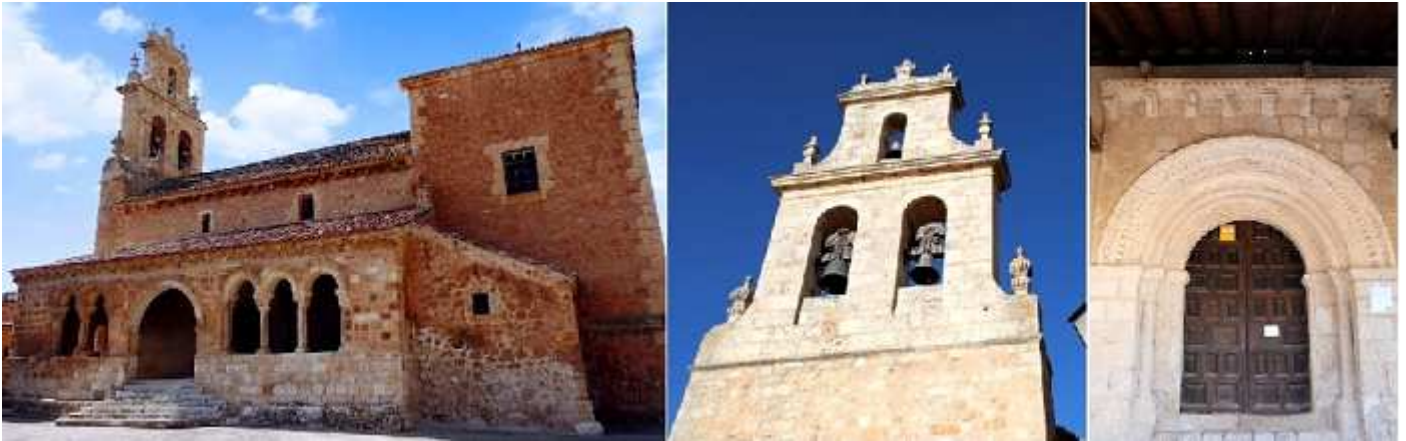
❶ Fachada sur del templo, cuya galería porticada hasta hace poco tiempo estuvo cegada y utilizada para usos agrícolas. En ella se puede apreciar el ensanchamiento de su arco central a costa de suprimir a la izquierda uno de los ventanales. ❷ Sobre el hastial dispone de esta espadaña de dos piso con tres vanos para sus campanas y decorada con pináculos. ❸ Su puerta de medio punto. Fotos: Camping Río Lobos.
