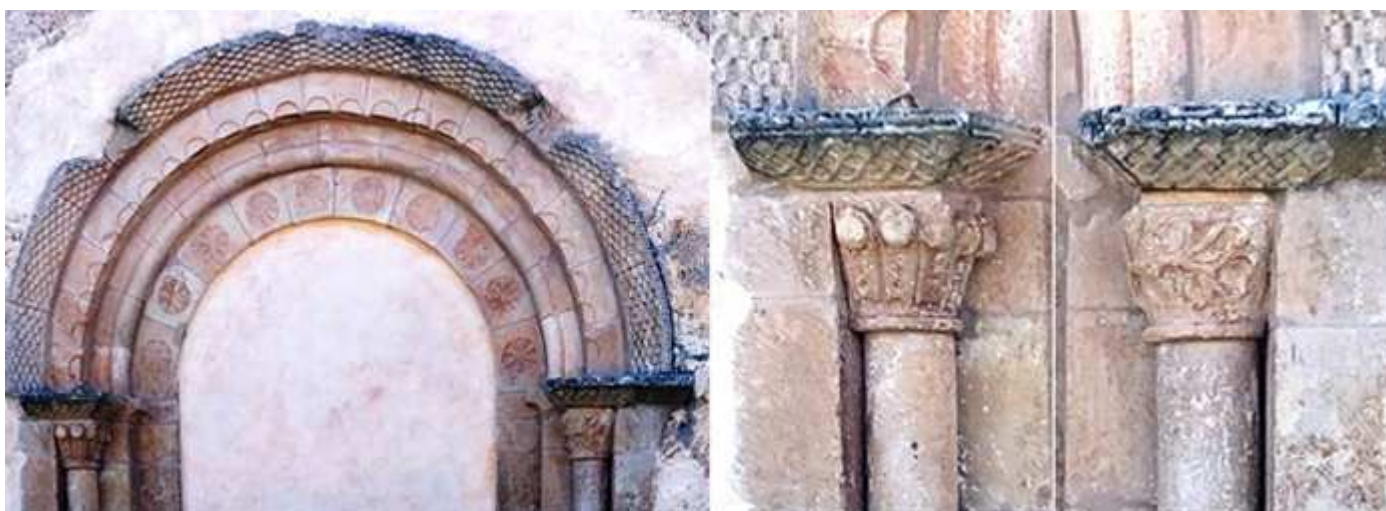
❶ La puerta norte protegida por una guardapolvo taqueado con una archivolta exterior decorada con arcos y que descansa en una imposta con capitel y columna, la central está baquetonada sobre jamba recta y la interior de arista viva su dovelas están decoradas con rosáceas de ocho pétalos. Esta puerta es la que está en el espacio del cementerio. ❷ Bajo impostas con labor entrelazada un capitel con hojas y volutas en el lado izquierdo. ❸. Y en el derecho otro vegetal con ramas y hojas. Fotos: Diego Pacheco Landero.
