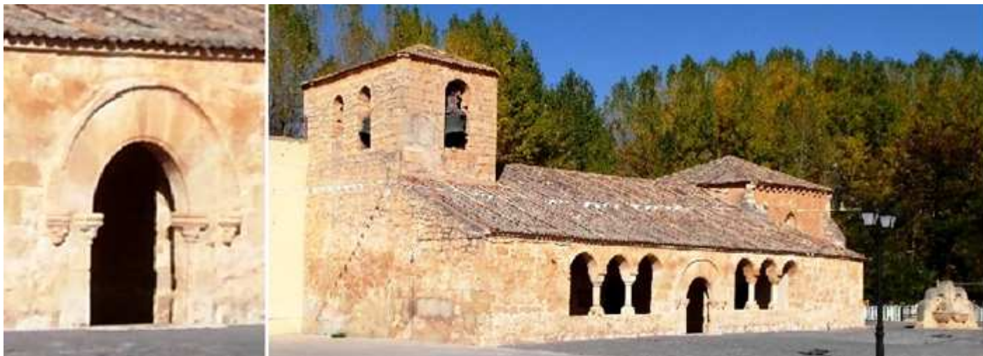
❶ Puerta de acceso al templo de medio punto con grandes dovelas lisas con un fino baquetón en si interior y cubierta con un guardapolvo, y descansa su arco en dos capiteles sin columnas con jambas rectas. ❷ Adosada al lado epistolar dispone de su galería porticada, y sobre los pies su torre campanario de planta rectangular y abierto con grandes arcos de medio punto su cabecera es recta. Foto Wikipedia De Rowanwindwhistler - Trabajo propio, CC BY-SA 4.0, Fotos: Ayuntamiento.
