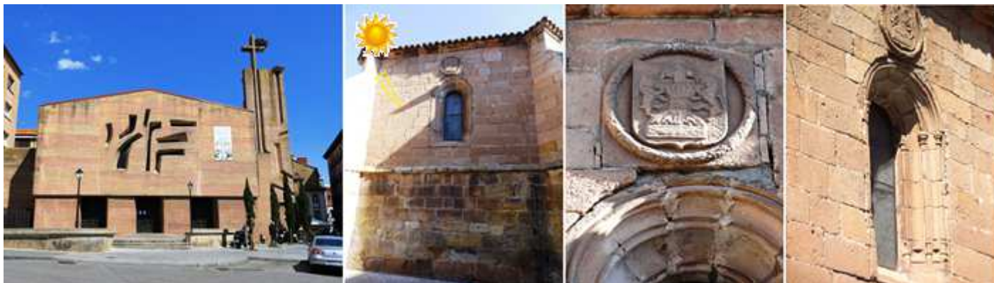
❶ Fachada modernista de hormigón del nuevo templo. ❷ Lateral del crucero de la Epístola. En el S. XVI se abrieron estas capillas góticas en sus laterales. ❸ -❹ Que cuenta con una ventana de medio punto con tres arquivoltas y sobre la misma un escudo de los Valles? En el exterior de la capilla del S. XVI. Existe un reloj de sol. Tipo: horizontal, rectangular, semicircular. Con los trazos excavados. Orientación al mediodía. Traza: de las 6 a las 6 h. p.m. en números romanos. Gnomon de varilla. Estado: perfecto. Año: S. XVI.
