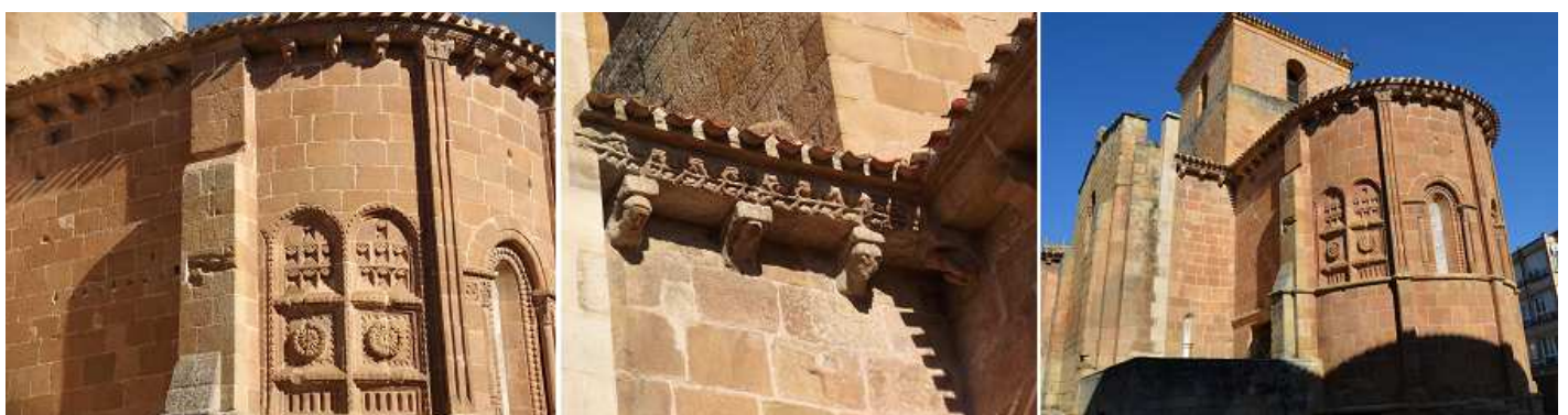
❶ Detalle de las ventanas ciegas con variada decoración en el interior de las mismas. ❷ Canecillos del ángulo del crucero y el presbiterio. ❸ Imagen exterior del ábside con la torre sobre el crucero.
