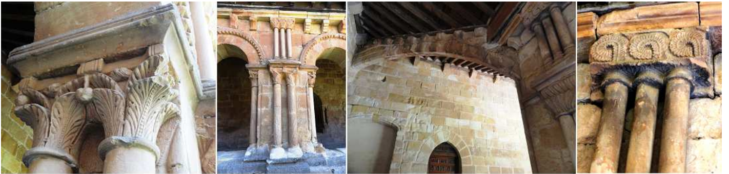
1 Capitel 1º a nuestra derecha doble con palmetas. 2 Pilastra con tres columnillas en la parte superior y dos en la inferior y sus capiteles con decoración vegetal. 3 Arco en la unión de las alas oeste y norte. 4 Pilastra de la esquina en su interior con tres columnillas arriba con un capitel con tres roleos formados por hojas.
