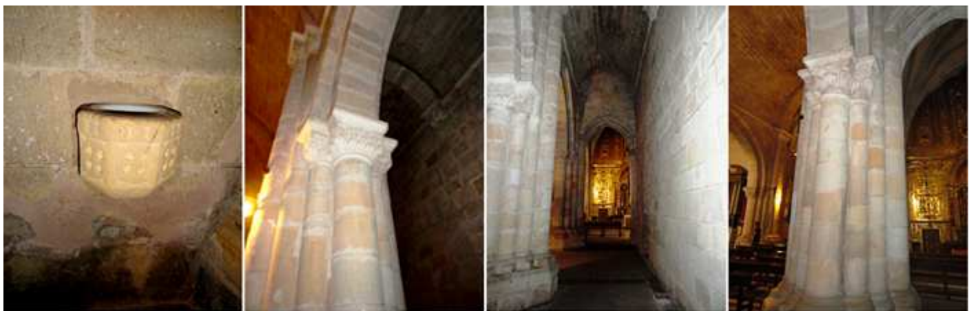
1 Pila de agua bendita de forma hexagonal encastrada a los lados de las naves laterales en la parte baja del templo. 2 Conjunto de columnas múltiples de la nave central. 3 Nave de la Epístola. 4 Grupo de los fustes de las columnas del último arco de la Epístola
