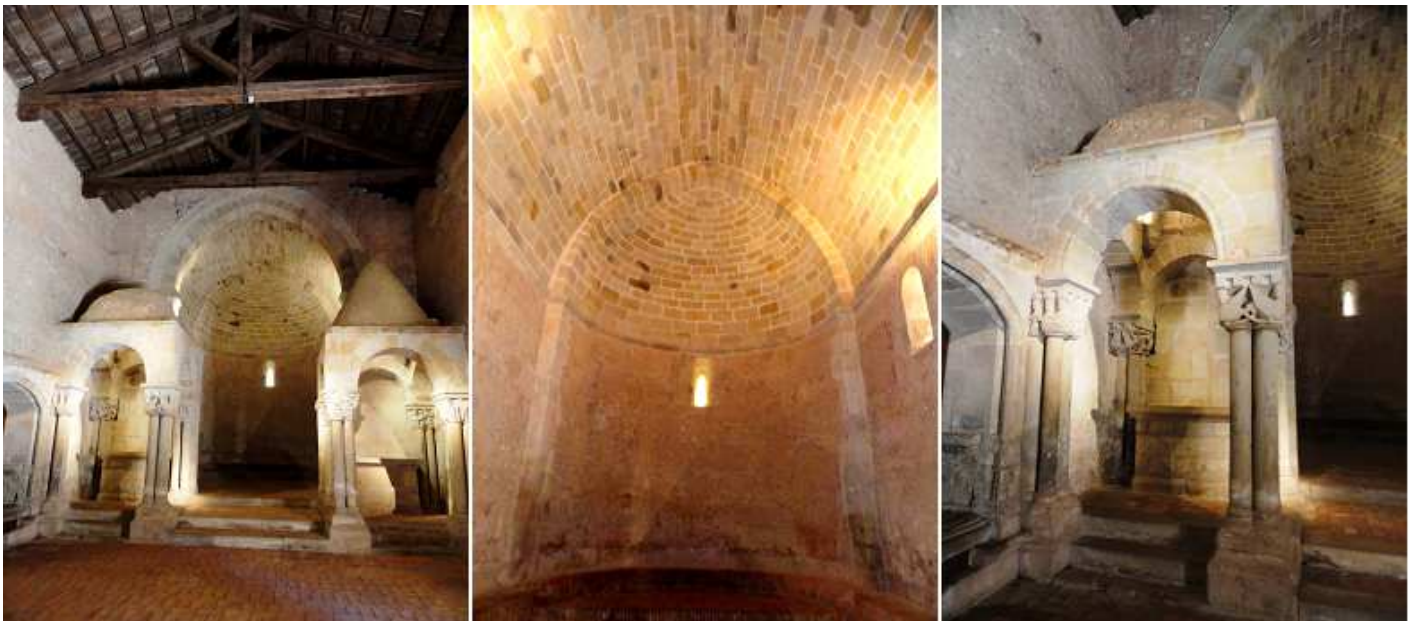
❶ Ante el presbiterio se encuentran los dos baldaquinos de influencia oriental que se colocaron en el S. XIII uno con cúpula esférica y el otro cónica; y su arco triunfal que es apuntado. ❷ Ábside con bóveda de horno y abierto por una ventana. ❸ Templete del lado del Evangelio.
