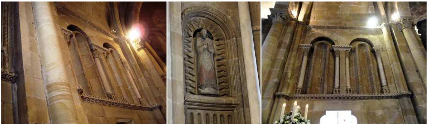
❶ Su presbiterio amplio y en sus laterales con arquerías ciegas. ❷ Imagen de San Pedro en una ventana del ábside. ❸ Ventanas ciegas con moldura interior en ziz-zag y sendas columnillas a sus lados.
