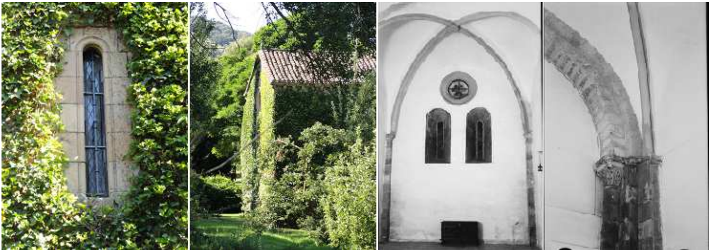
❶ Ventana saetera simplemente acanalada. ❷ El ábside plano también está totalmente envuelto por la vegetación. ❸ Ventanas con derrame interior pequeño óculo de seis lóbulos. ❹ Detalle de un arco con sus columnas y capiteles. Fotos Interior: "Archivo Histórico Provincial de Soria"
