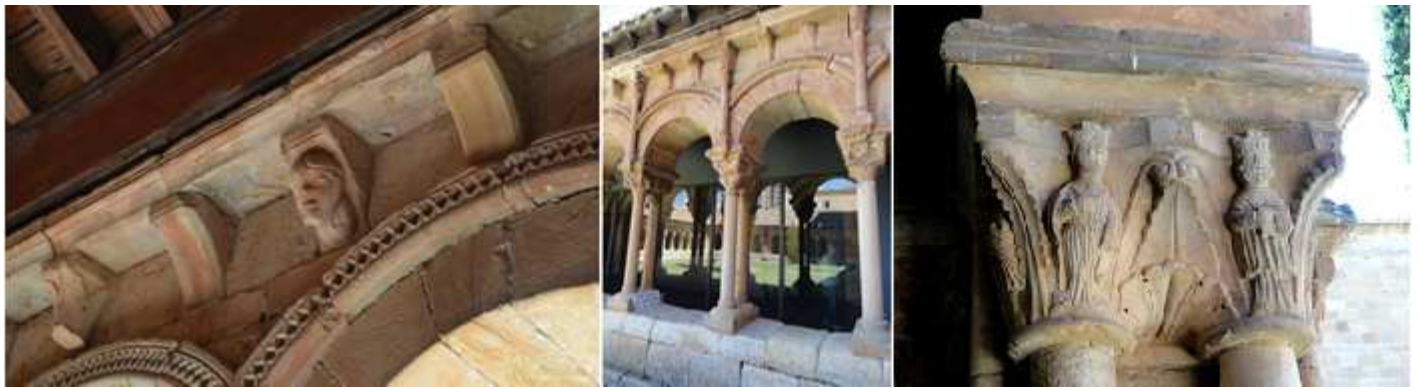
1 Canecillos por la parte interior de la panda este del claustro. 2 Arcadas por su parte exterior. 3 Canecillo con el Rey Salomón y la Reina Saba.
