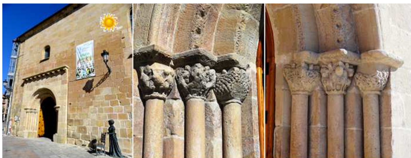
1 Portada adelantada bajo un tejazoz, con tres arquivoltas con arco de medio punto, que descansan sobre una imposta corrida y esta sobre tres parejas de capiteles decorados. Existe un Reloj de Sol en la parte derecha de su puerta. Debajo de una marca de
