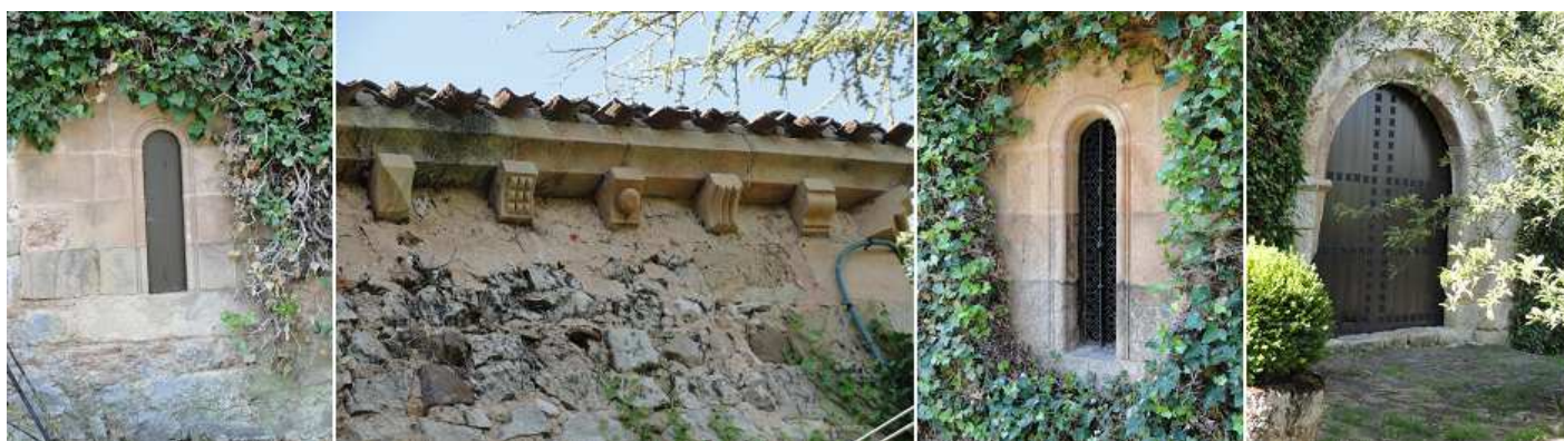
❶ Ventana de este lado de medio punto. ❷ Alero con canecillos modernos. ❸ Otra ventana de aspillera. ❹ Puerta con dos arquivoltas lisas y guarda lluvias también decorado con puntas o bolas entre dos molduras.
