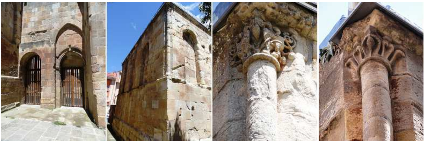
❶ A la izquierda la puerta de la torre y a su derecha la puerta del lado de la Epístola. ❷ Lateral de la torre a los pies del templo. ❸ Detalle de la columna y capitel de este lado. ❹ y del capitel del lado opuesto.
