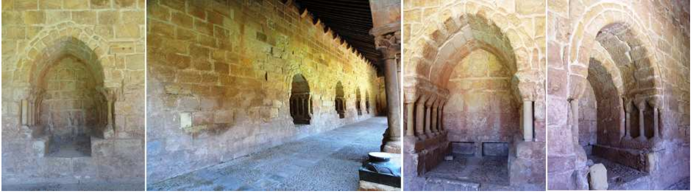
1 Primer arcosolio. 2 Lateral del ala oeste con los arcosolios. 3 Todos esta realizados con columnillas que sostienen la arcada. 4 Los arcos son apuntados.
