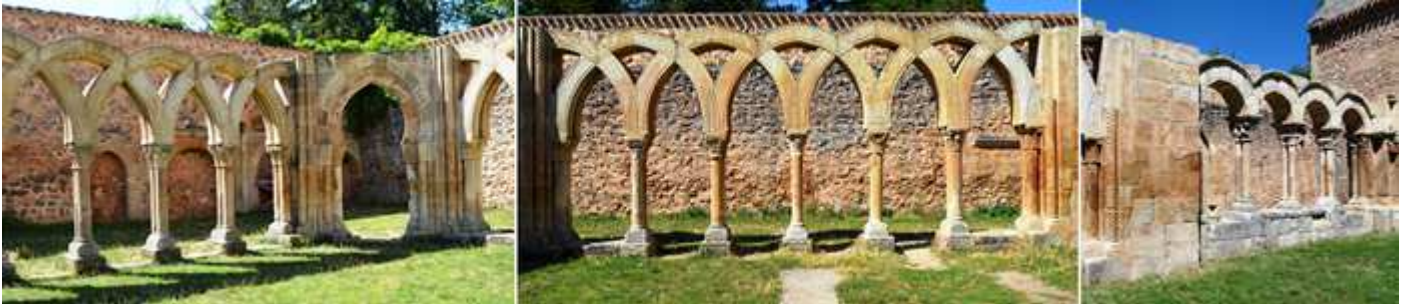
❶ La segunda parte de la panda sur ya con arcos cruzados y ligeramente apuntado con una bella puerta de herradura. ❷ Frontal del lado oeste, ya junto a la puerta de entrada en el recinto. ❸ Y su segunda parte que son con arcos de medio punto.
