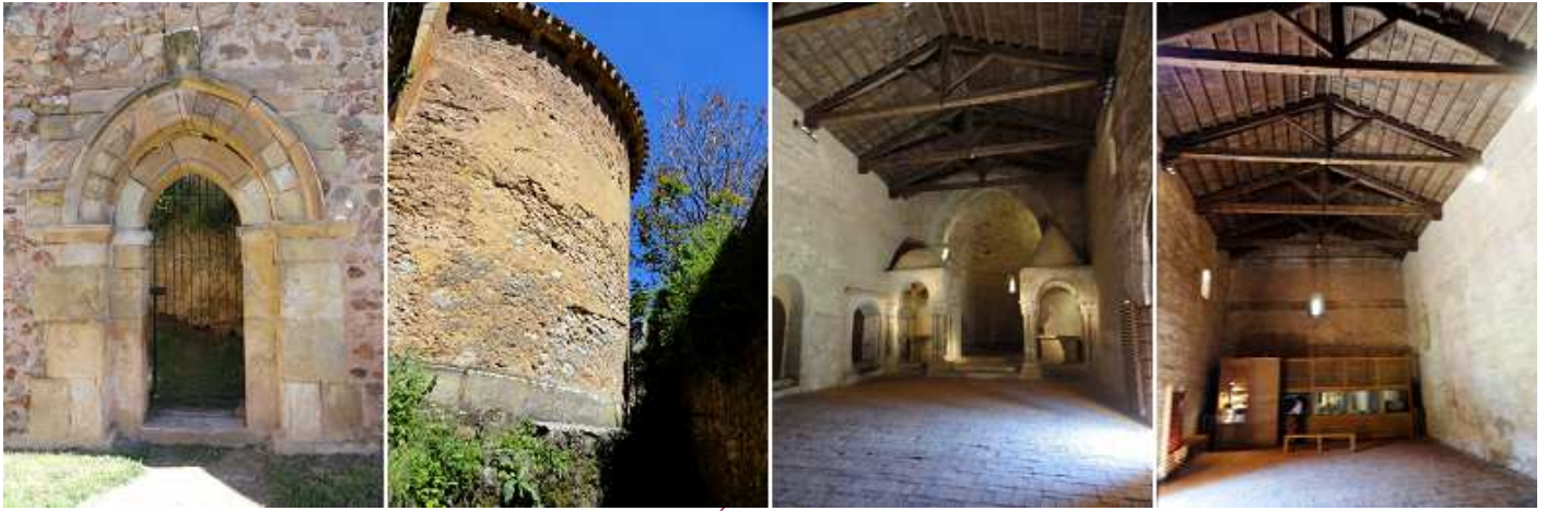
❶ Puerta de claustro a la parte posterior del templo. ❷ Ábside semicircular con alero y canecillos lisos. ❸ Cabecera con los templete. ❹ Parte inferior del templo y su cubierta a dos aguas de madera.
