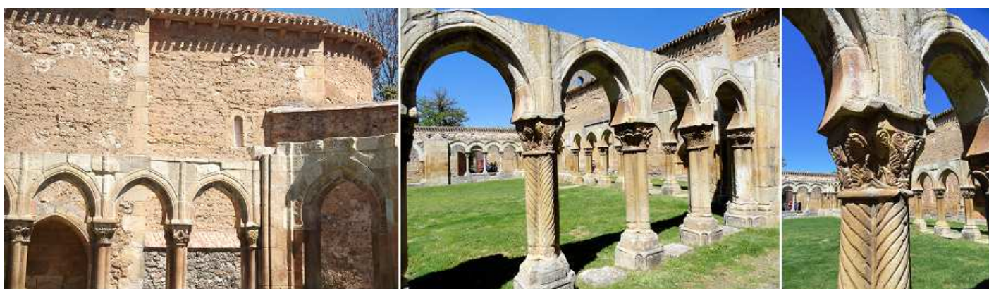
❶ La segunda parte de esta panda norte ya tiene los arcos apuntado y continua con doble pares de columnas y sobre basas. ❷ Continúa en el lado este con arcos apuntados insinuando arcos de herradura, con bellos capiteles. ❸ Detalle de uno de los arcos y su capitel con motivos vegetales y sus columnas en espiral.
