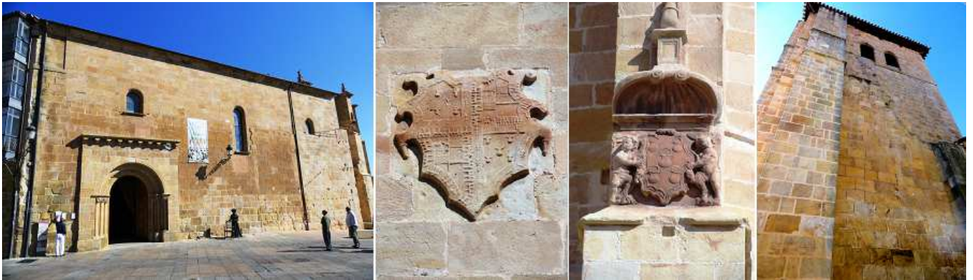
① Fachada meridional del templo a la plaza ② m. ③ Escudo de los Calderones, con cinco calderos. ④ Lado de la torre al muro norte abierto el campanario en este lado con dos ventanas de medio punto sin decoración.
