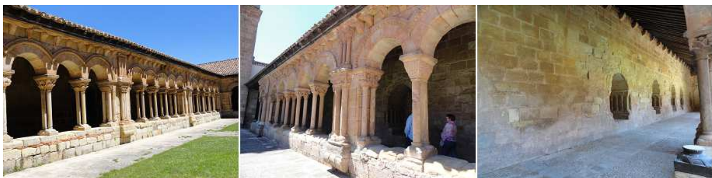
1 Parte exterior del ala oeste. 2 Otra imagen con el templo a la izquierda. 3 Interior de la galería y a la izquierda una serie de arcosolios.
