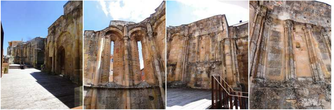
❶ Imagen del templo desde los pies, del que se conservan los muros de lado epistolar. ❷ Dos de las ventanas del ábside entre columnas redondas adosadas con capiteles de motivos vegetales. ❸ Muro lateral del presbiterio. ❹ Con tres vanos ciegos entre agrupaciones de columnillas a sus respectivos lados.
