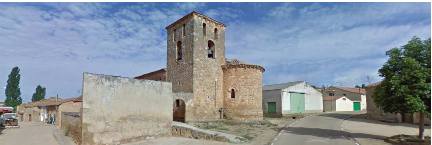
1 Adosada a la cabecera se encuentra su torre que en su parte inferior posee una bancada que recorre también el perímetro del ábside. 2 En su parte superior se abre para el campanario dos pisos con ventanales de medio punto, bajo un alero soportado por canecillos lisos con una cubierta a cuatro aguas. 3 Su ábside se encuentra abierto por dos ventanas. Su central tercera fue cegada. 4 Cada ventana posee una arquivolta de arista viva y cubierta con un guarda lluvias que ambos descansa en una imposta biselada con sendas columnas y capiteles con arpas y motivos vegetales. 5 El alero del ábside posee canecillos lisos, de nacela proa de barco y otros con motivos.
