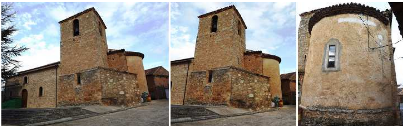
1 Fachada del templo realizada con cantería 2 Con la torre de posterior época, adosada. 3 Imagen del estado actual de su ábside por el exterior.
