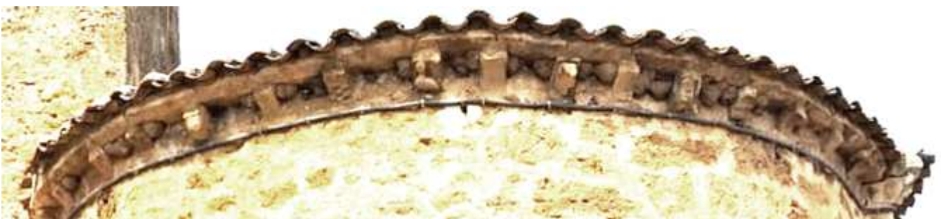
❶ Su ábside cuenta con un alero donde 16 canecillos con diversas formas donde se alternan los motivos geométricos con cabecillas y uno con una arpía. Fotos Sergio Fernández Barranco
