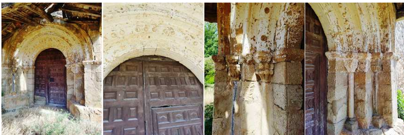
❶ Su puerta de acceso bajo un atrio parcialmente hundido. ❷ Con cinco arquivoltas en su arco de medio punto. ❸ Detalle de los capiteles del lado izquierdo con columnillas. ❹ Y los del derecho. Fotos Sergio Fernández Barranco
