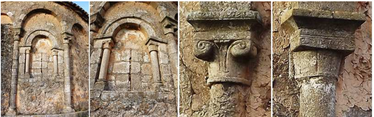
❶ Detalle de su única ventana en el ábside en el arquillo central. ❷ Con una arquivolta con guardapolvo sobre imposta y columnas con capiteles decorados, y en el centro una aspillera. ❸ Los arcos ciegos descansan sobre capiteles decorados de distinta decoración y columnas redondas adosadas. ❹ Otro capitel.
