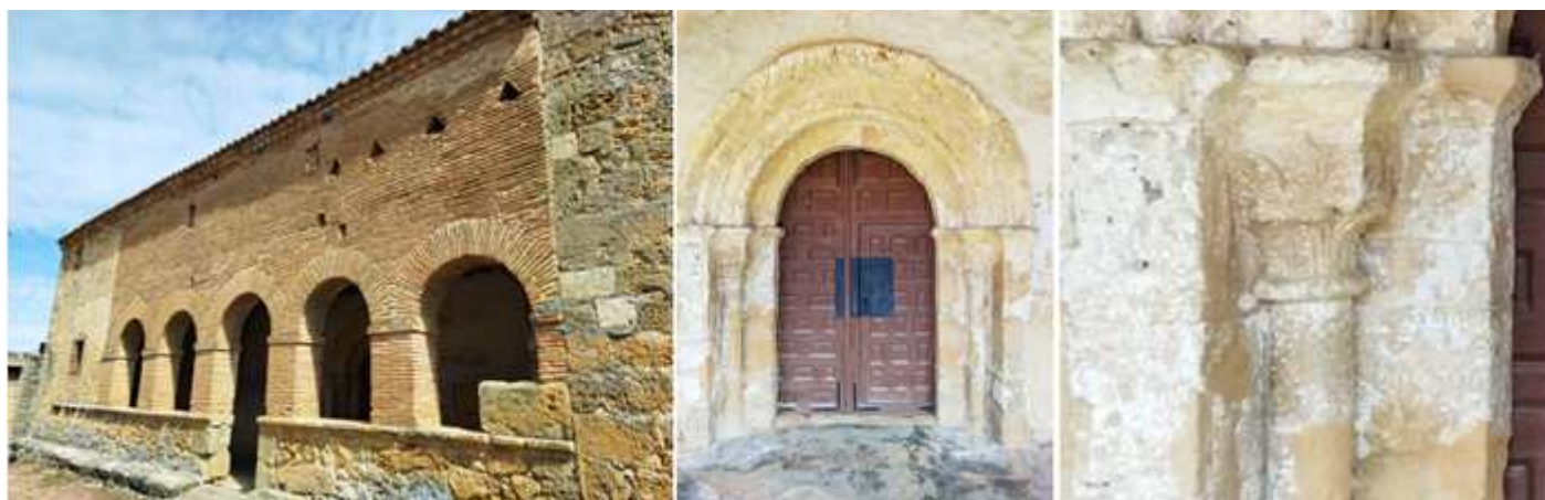
❶ Galería compuesta por cinco arcos (incluido el de ingreso) realizado en ladrillo sobre el S. XVI. ❷ Puerta con tres archivolts baquetonadas siendo la interior de arista viva, descansan sobre una imposta corrida y la central es la que posee capiteles y columnilla y las otras dos sobre jambas rectas. ❸ Detalle de la columnilla acodillada y un capitel con hojas palmeadas. Fotos Sergio Fernández Barranco.
