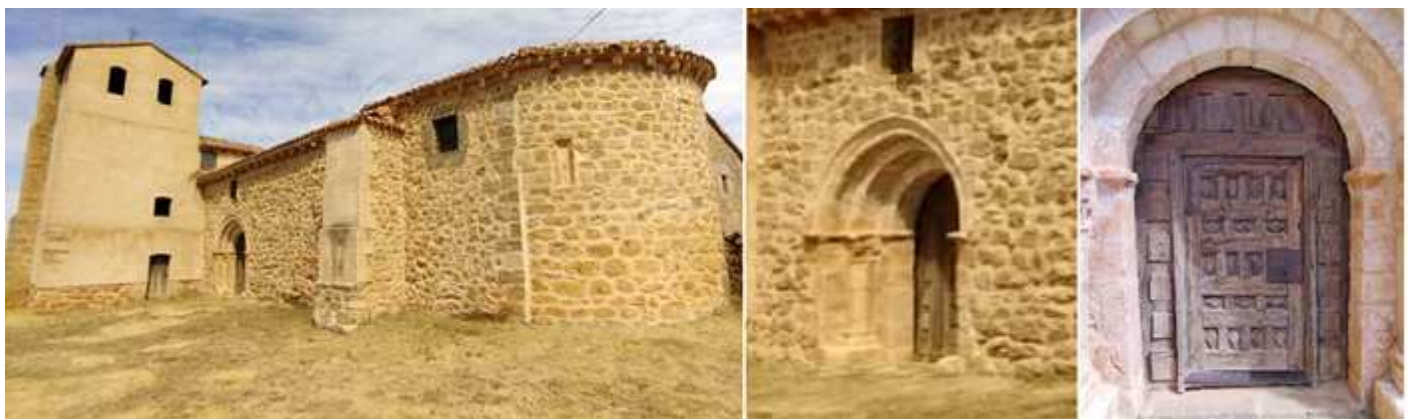
❶ Fachada meridional del templo con la parte posterior de su espadaña adosada a los pies. ❷ Su portada se abre en la parte central de su nave en el lado Epistolar. ❸ Su puerta compuesta por tres arquivoltas sencillas las dos exteriores y de bocel la exterior, una se sustenta sobre columnillas y las otras dos sobre pilastras. Fotos Sergio Fernández Barranco
