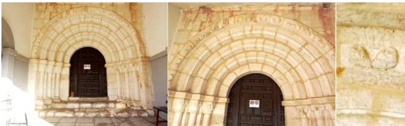
❶ Portada con tres arquivoltas de bocel y un guardapolvo. ❷ Realizada en piedra calcárea blanca ❸ Su arquivolta exterior decorada con bifolias.
