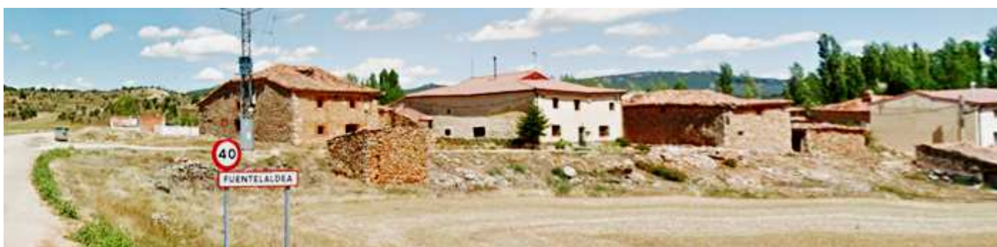
❶ La entrada a la localidad de Fuentelaldea con grandes casonas.
