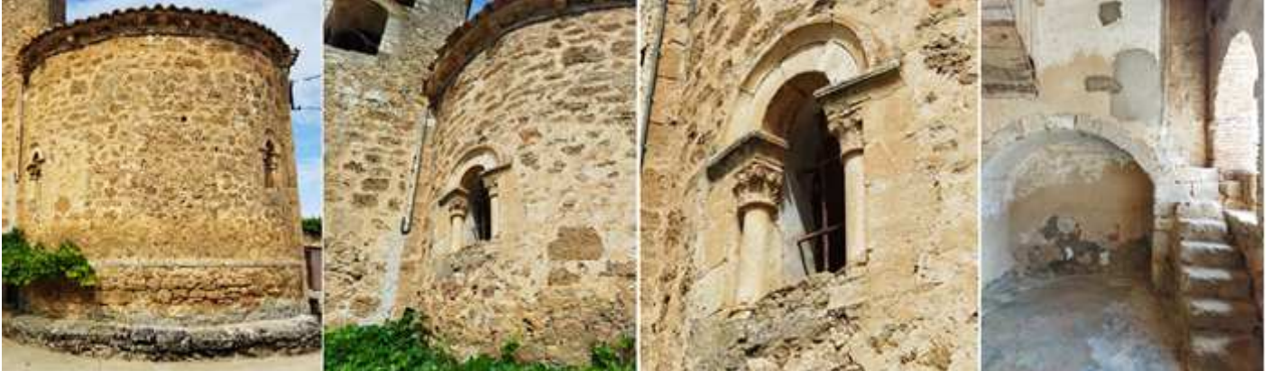
❶ Ábside con un pequeño basamento inferior y dotado con dos ventanas. ❷ Ventana del lado sur con arco de medio punto, con chambrana de nacela y columnillas laterales rematadas por capiteles, decorados hojas palmeadas. ❸ Primer plano de esta ventana. ❹ Arco en la galería en su lado este con la base de la torre. Fotos Sergio Fernández Barranco
