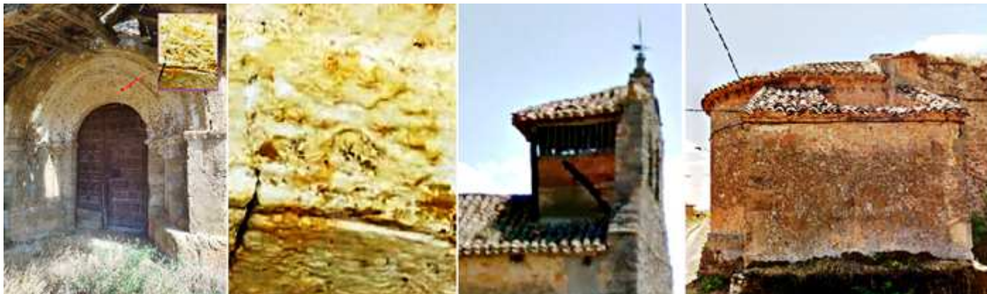
❶ En la clave de la arquivolta interior dispone de un crismón. ❷ Del que apenas es perceptible por su erosión y capas de cal. ❸ tras su espadaña de dos vanos cuenta con el cobertizo para tocar sus campanas. ❹ La sacristía que cuenta con su cubierta hundida. Fotos Sergio Fernández Barranco
