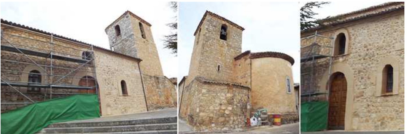
1 Exterior epistolar que están obrando actualmente. 2 La torre de planta cuadrada. 3 Su fachada sur con varios vanos de medio punto.
