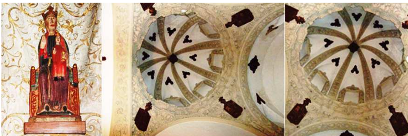
1 Imagen de la virgen de Casbas, del S. XII. 2 Detalles de la decoración de la cúpula barroca de la capilla. 3 Cúpula sobre pechinas con escudos y abierta entre sus nervios con ocho lunetos.
