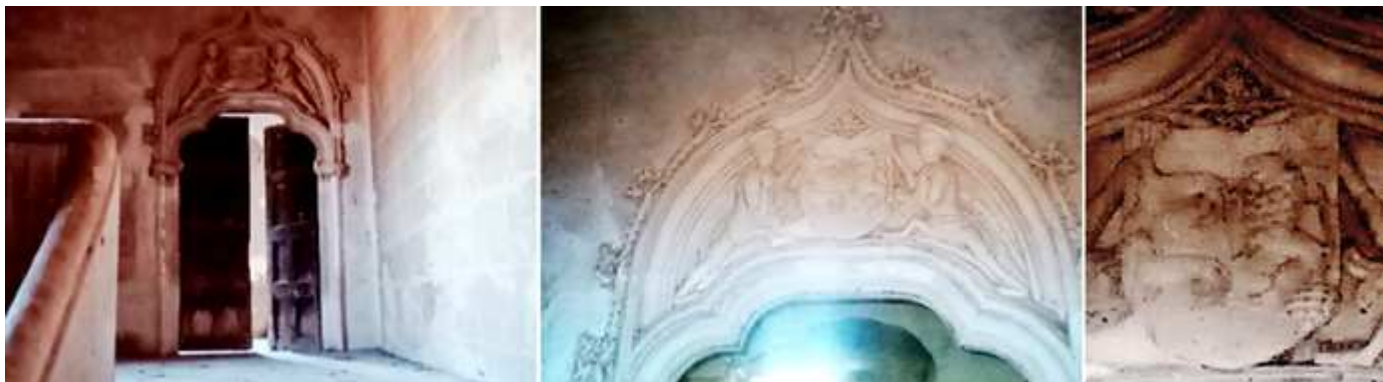
❶ Detalle de la escalera lateral, la puerta de arco trilobulado con su tímpano decorado con dos niños que sostienen el escudo nobiliario y un arco conopial con crestería que lo envuelve. ❷ Primer plano del tímpano, en su escudo aparecen dos canes superpuestos y un león rampante. ❸ Que posee dos canes en unos de sus cuarteles y un león en el otro.
