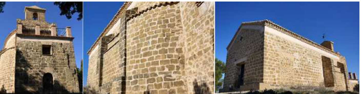
① La vivienda construida (la casa del Santero) y adosada a su cabecera original del templo semicircular. ② El lado actual de la Epístola y el tramo al descubierto de su cabecera. ③ Su nuevo hastial con una puerta adintelada y la parte ampliada de este lado. Y con otra puerta cegada. Fotos: Marta Puyol Ibort / Archivo Fotográfico Hoya de Huesca (SIPCA – www.sipca.es )
