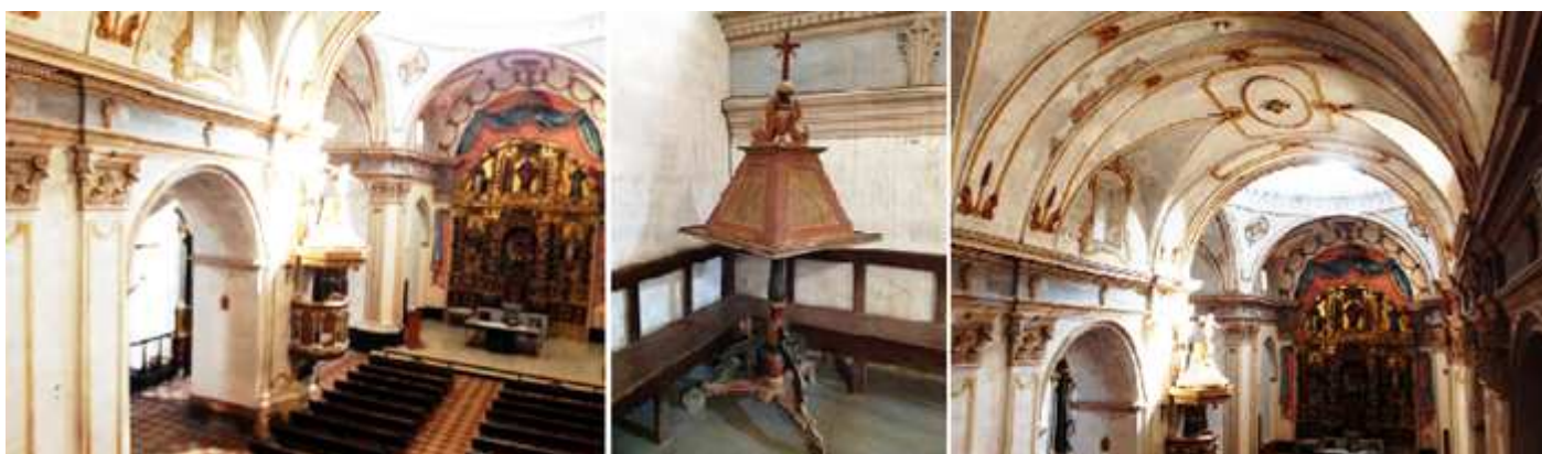
❶ Lateral de la nave del Evangelio. ❷ Facistol del coro. ❸ Su bóveda de cañón con lunetos y decorada con estucos.
