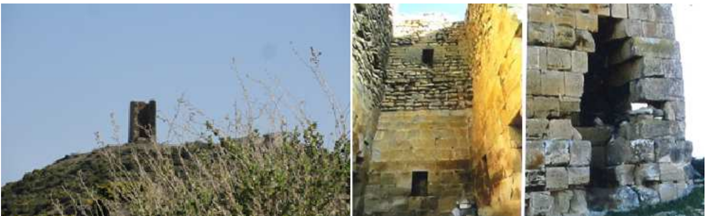
❶ Vista de la parte sur que es la que ha perdido su lienzo. el acceso se hace en el muro oeste a cierta altura. ❷ - ❸ Interior de la atalaya fotos del cartel informativo de A. García Omedes.
