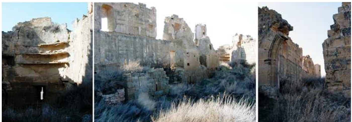
1 Interior del cubo oeste. 2 El interior del castillo con sus piedras entre la maleza. 3 Restos de la puerta de medio punto en el lienzo este. Fotos: Francisco Bolea (SIPCA – www.sipca.es )
