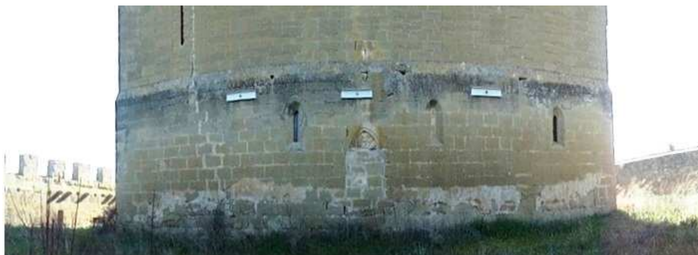
❶ Panorámica de la parte interior ante la facha principal del palacio. Con ventanas apuntadas con derrame exterior y una puerta con tímpano decorado que ha sido cegada. Con un amplio espacio entre la torre y las murallas, que las de la parte izquierda aun conservan sus almenas.
