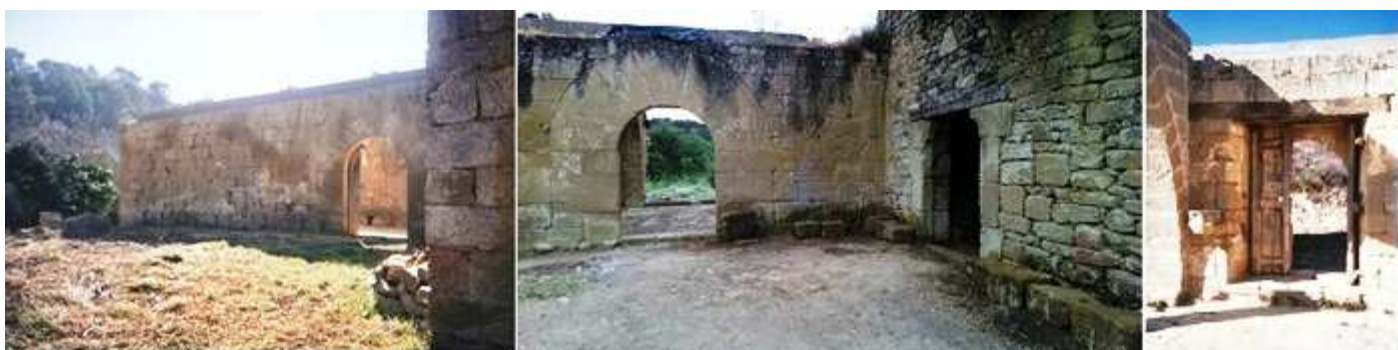
❶ Esta ermita que después de muchos trabajos de desescombro y limpieza se ha intentado restaurar sin conseguir colocar su cubierta. ❷ Lateral del evangelio junto a la casa del ermitaño. Casa del santero con su puerta de arco apuntado restaurada. ❸ Puerta del lado del Evangelio por el interior del templo con su pila de agua benditera.
