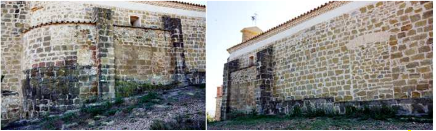
① Lateral exterior del Evangelio con el otro tramo al descubierto de su cabecera. ② En este lado aparece un vano cegado. Fotos: Marta Puyol Ibort / Archivo Fotográfico Hoya de Huesca (SIPCA – www.sipca.es )
