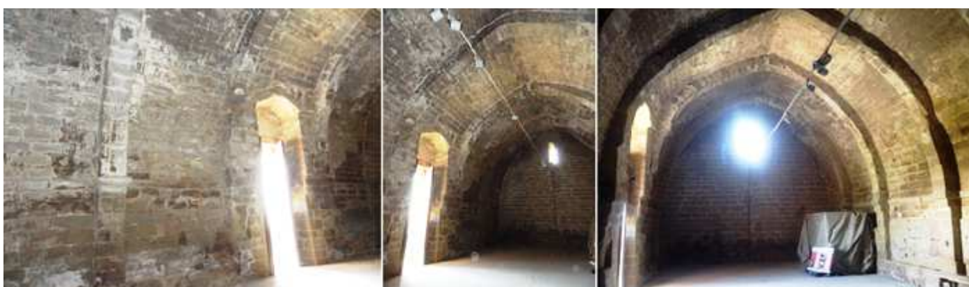
❶ Lateral de la Epístola con su puerta. ❷ La nave con bóveda de cañón apuntado sostenida con arcos fajones. ❸ Vista de la parte inferior del templo.
