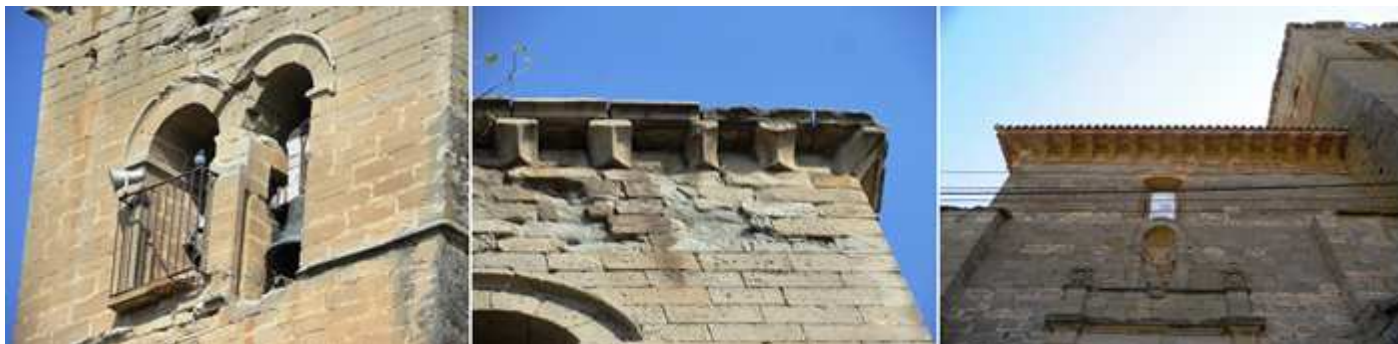
❶ Ventanas de la torre que dan al mediodía. ❷ El alero de la torre con canecillos de nacela. ❸ Parte superior de la fachada.
