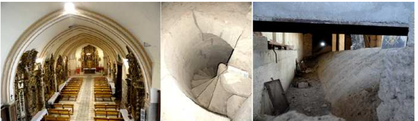
❶ Vista del templo desde el coro apreciándose los arcos fajones apuntados que sostienen la bóveda. ❷ Escaleras. ❸ Detalle la bóveda original que estaba con una cubierta a dos aguas.
