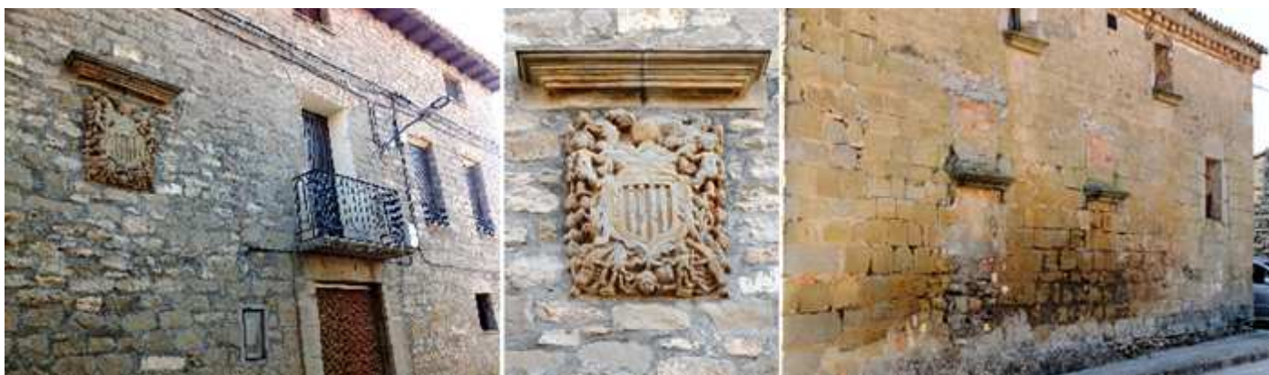
❶ Casa de los Otales en la calle Mayor, 4. ❷ Sobre su fachada construida con cantería ostenta este escudos con su armas cuatribarradas rodeada de amorcillos, y a los pies dos figuras con armas de fuego. ❸ Casa construida con piedra de sillería de dos alturas en la calle xxxx.
