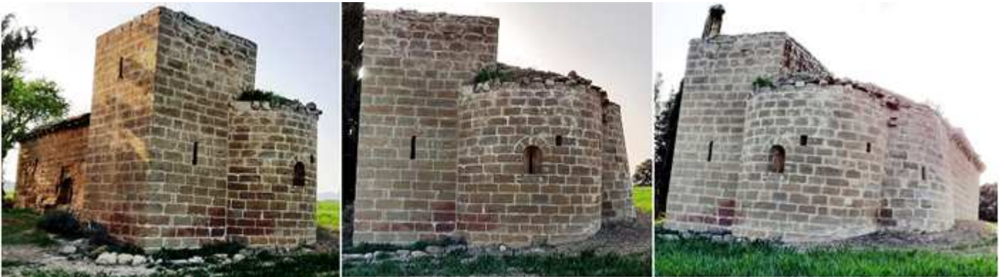
① Parte posterior adosada al ábside se encuentra su torre de planta cuadrada. ② Detalle de su ábside central abierto con una ventana. ③ Lateral del lado del Evangelio. Fotos Ayuntamiento.
