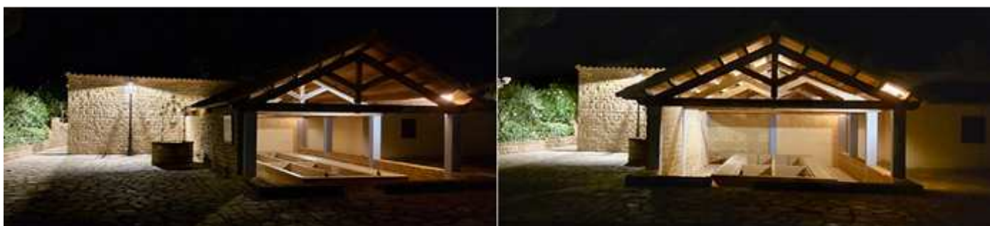
1 Junto al lavadero posee un pozo que capta las aguas del río. 2 Tras la restauración del mismo, posee una poza con dos lados para hacer la colada. En uno de los laterales posee una reproducción del mismo en azulejos y con la fecha de construcción de 1904 y su restauración en el 2008.
