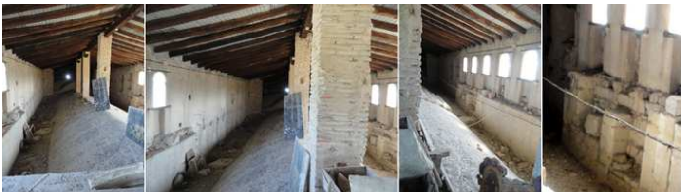
① Lateral izquierdo. ② Se aprecian los muros de piedra, sobre los que se recreó esta galería de arcos y la altura que representa. ③ Lado derecho. ④ En este espacio hacia la mitad, hay unos vanos.
