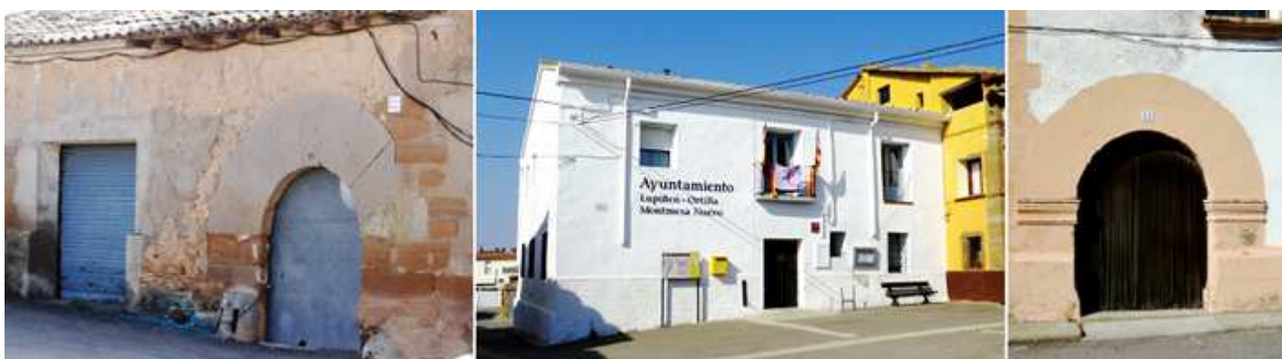
❶ Casa en plaza Torraza, nº 16 con una simple puerta dovelada. ❷ Fachada del Ayuntamiento. ❸ Puerta con la inscripción del año 1764.
