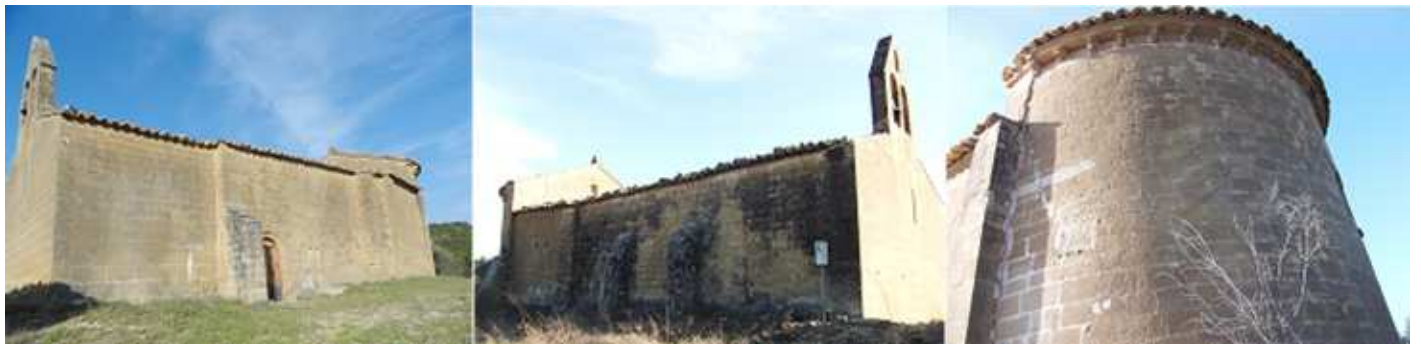
❶ Lateral epistolar con un pequeño contrafuerte junto a la puerta en este lado. ❷ El lateral del lado opuesto, en su hastial dispone de una espadaña de tres vanos. ❸ Su cabecera es semicircular con una altura mayor que la nave.
