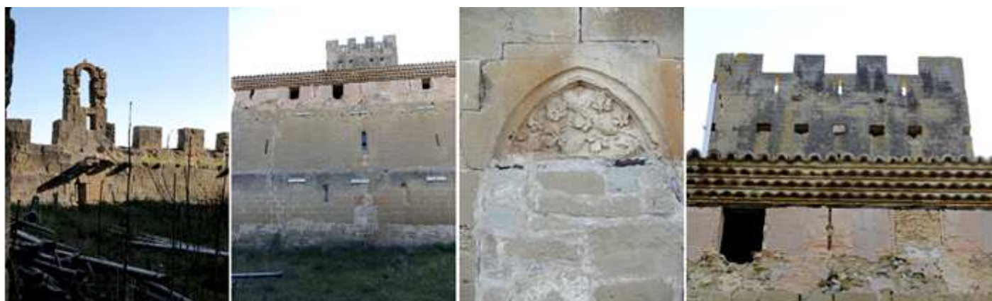
❶ Detalle de la cerca que da junto al río Gállego y que conserva la espadaña de su antigua iglesia. ❷ Fontal del palacio con su puerta de arco apuntado cegada a su lado dos ventanas medio punto con derrame exterior en la parte sur. ❸ Tímpano de la puerta del palacio. Donde se aprecian cuatro piñas y hojas de parar con sus tallos y racimos de uva. ❹ Alero con 4 filas de tejas.
