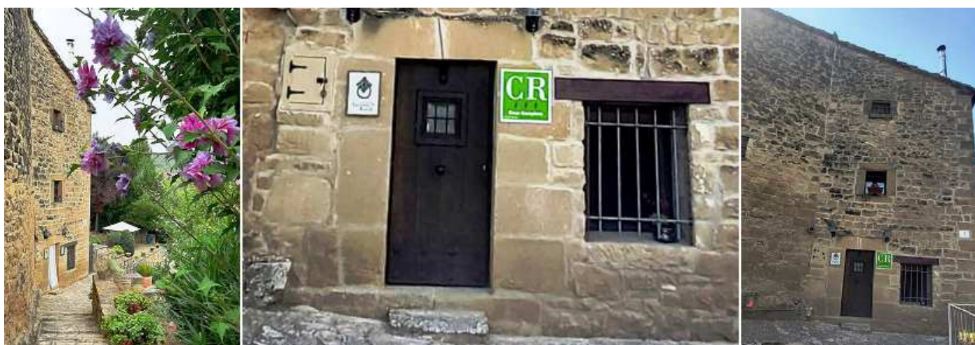
1 La casa da frente al río Gállego, en un paraje que es la cola del pantano de Ardisa. 2 Acceso a los dos apartamentos. 3 Dispone de tres plantas.
