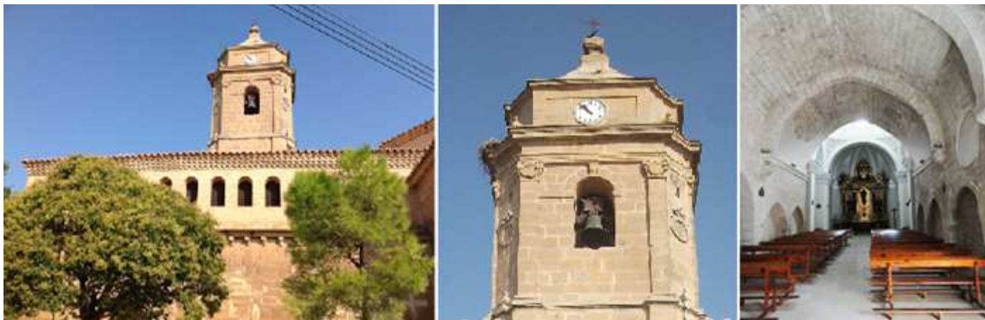
❶ Recrecimiento de la galería sobre el muro románico en los S. XVI-XVII ❷ Cuerpo superior de la Torre con sus ángulos achaflanados. ❸ Interior de la nave con bóveda apuntada sostenida por arcos fajones que arrancan sobre ménsulas.
