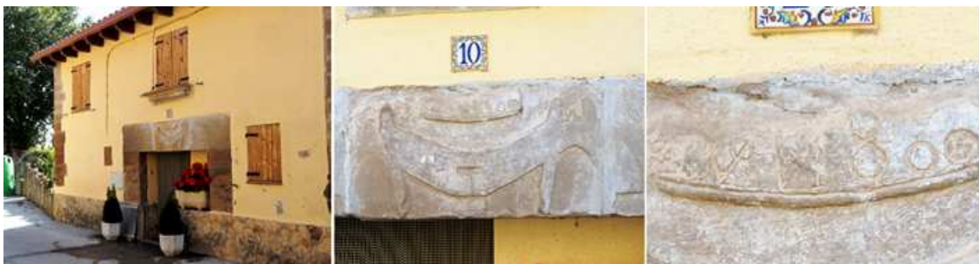
❶ Casa Carretero en la calle xx, nº 10. ❷ En su dintel dispone de una zo varias piedras de arenisca grabadas. En una, una moldura con varios aros y signos. ❸ Moldura con varios signos grabados.
