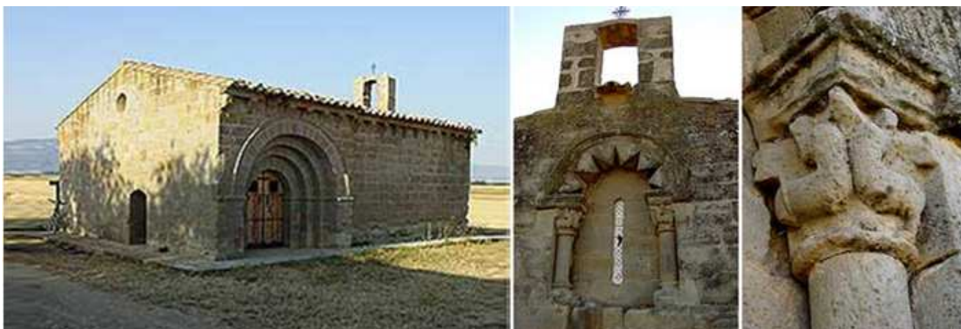
➋ Templo de planta rectangular construido en piedra sillar. ➌ Ventana de su cabecera, con una arquivolta con gruesas puntas de diamantes. ➍ Capitel de la con dos animales enfrentados (leones). Fotos: Miguel Soler Gracia en BTT. http://hoyadehuesca.huescaenbtt.es/pueblos0.htm
