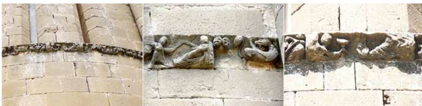
❶ - ❷ - ❸ Diferentes detalles de la imposta exterior de los ábsides, en la última imagen, la mano de Dios.
