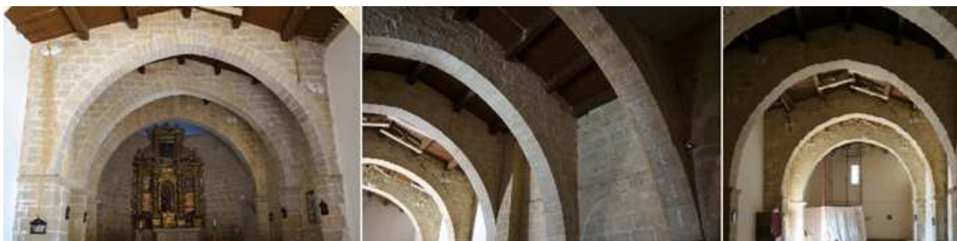
❶ Arcos sobre columnas rectas con unas impostas. ❷ Con un artesanado de madera cubierto de teja a dos aguas. ❸ La parte inferior del templo. Fotos: Marta Puyol Ibort / Archivo Fotográfico Hoya de Huesca (SIPCA – www.sipca.es )
