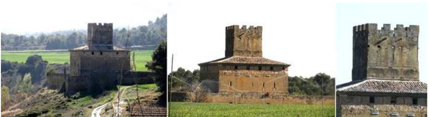
❶ Vista del castillo desde la carretera, antes de cruzar la presa con el río bajo nuestros pies que nos separa. ❷ El conjunto se compone de la primitiva torre que está envuelta por el palacio construido en torno a ella en el S. XV-XVI. ❸ La torre central con planta cuadrada de 7 m de lado y 15m de altura y con estancias abovedadas.
