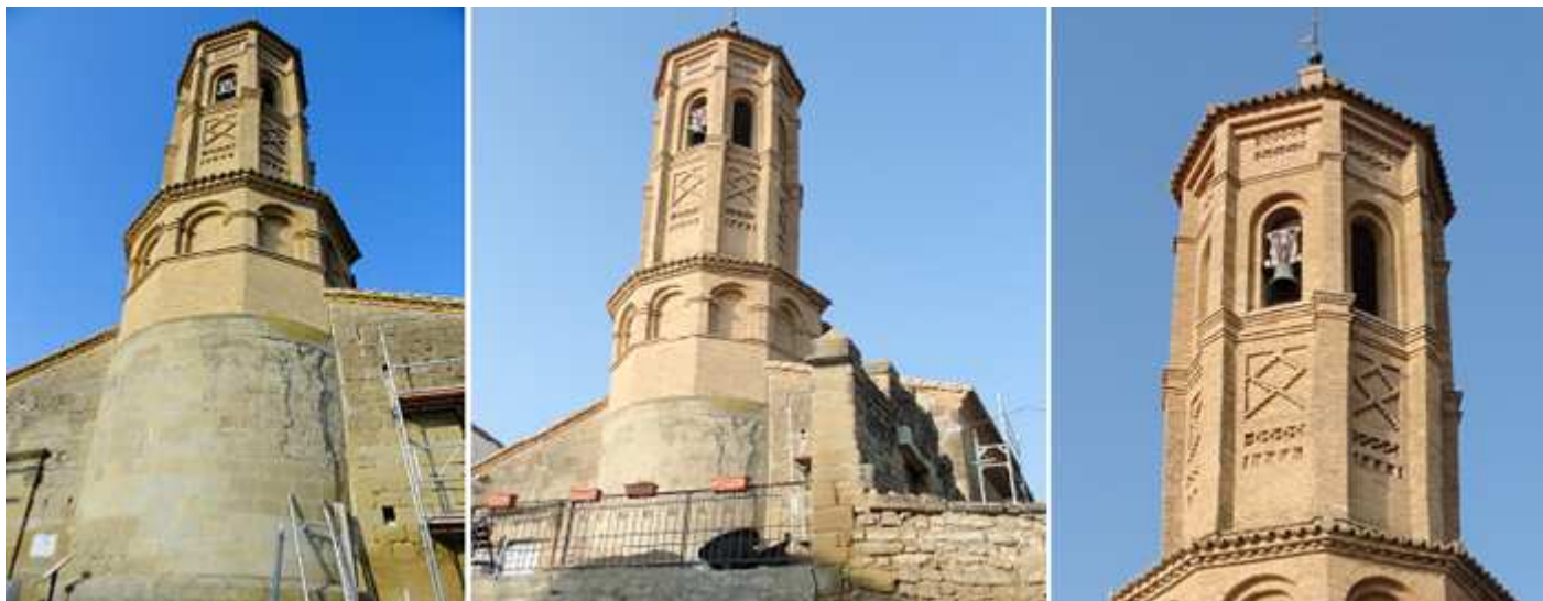
❶ Sobre la cabecera de piedra se alza su torre mudéjar en ladrillo del S. XVII. ❷ La torre dispone de un primer cuerpo octogonal que se ven cinco lados con arcos ciegos. ❸ Parte superior de la torre con ventanas de medio punto en su campanario.
