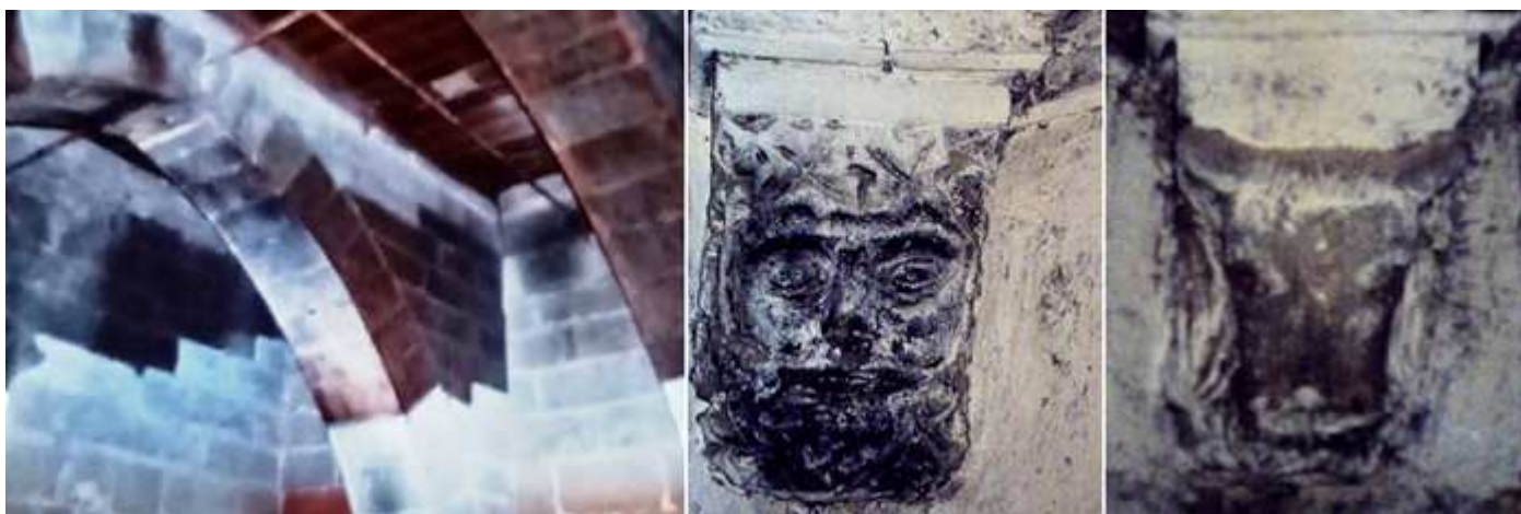
❶ Arcos fajones en la planta de la bodega de arista viva. ❷ En la planta siguiente de la torre cuenta con bóveda de crucería cuyos nervios arrancad de cuatro ménsulas como estas. ❸ Además de una cara grotesca, o una cabeza de toro, cuenta con otras dos con los motivos en una, hojas y dos pájaros y al otro solo las hojas vegetales.
