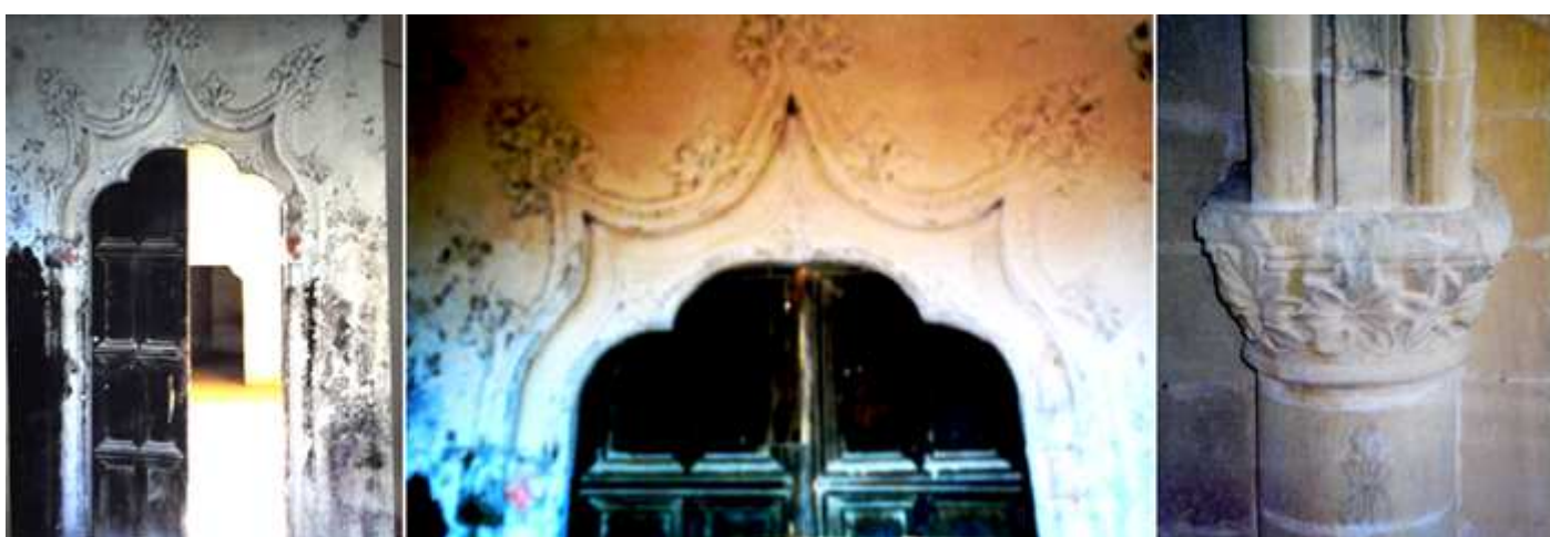
❶ Otra puerta de características similares sin tímpano y su crestería con hojas vegetales. ❷ Detalle de su parte superior. ❸ Otra estancia en el arranque de su escalera dispone de arcos fajones baquetonados que descansan en estas columnas con capiteles con motivos vegetales, y en sus muros ventanales de aspillera con gran derrame interior.
