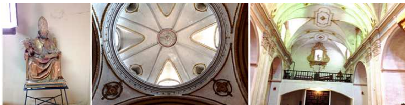
❶ Imagen sedente de San Pedro en la sacristía. ❷ Cúpula sobre pechinas sin tambor. ❸ A los pies sobre un arco rebajado el coro elevado.
