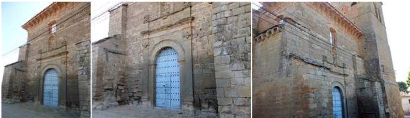
❶ Portada a los pies del templo. ❷ De medio punto entre dos pilastras. ❸ entre los contra fuertes de los pies se levanta su fachada con un alero de canecillos lisos.
