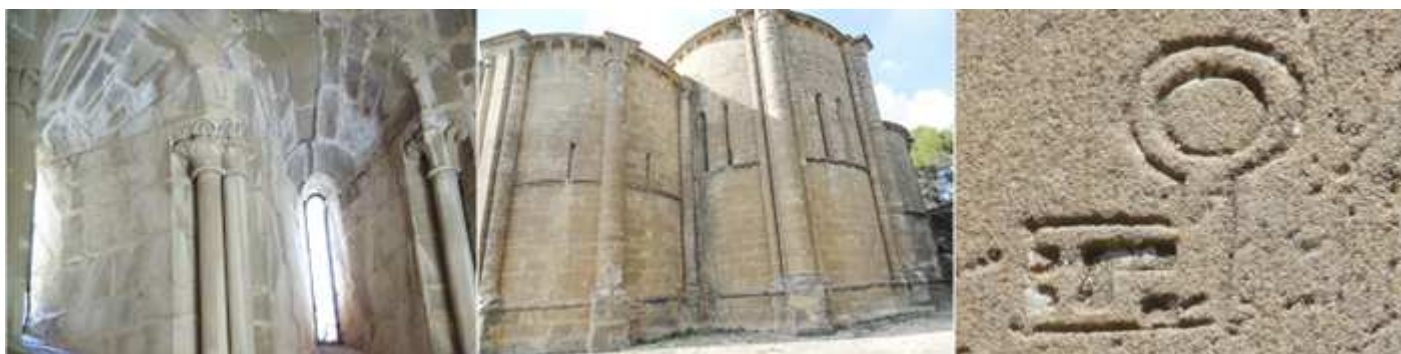
❶ Ventanales de los Absidiolos de derrame interior y con columnillas en su exterior. ❷ Vista exterior de los ábside, ❸ Primer plano de una de las innumerables marcas de los canteros con las que conto para su construcción.
