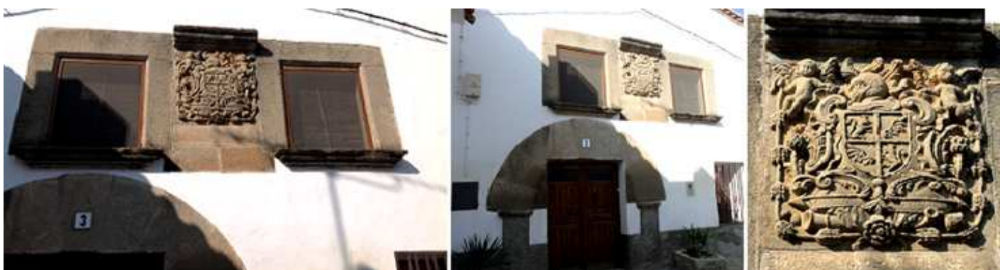
❶ Casa Oliva en la placeta del mismo nombre, nº 3 con un escudo entre sus dos ventanas adinteladas, del S. XVIII. ❷ Posee una puerta de grandes dovelas lisas que ha sido reconvertida en adintelada. ❸ Escudo con profusa decoración, con dos angelitos que sostienen un cordón que lo rodea con yelmos sobre el mismos y cuatro cuarteles con dos leones rampantes y dos alas, bajo el mismo la inscripción: "Armas de los Oliva de Lupiñén".
