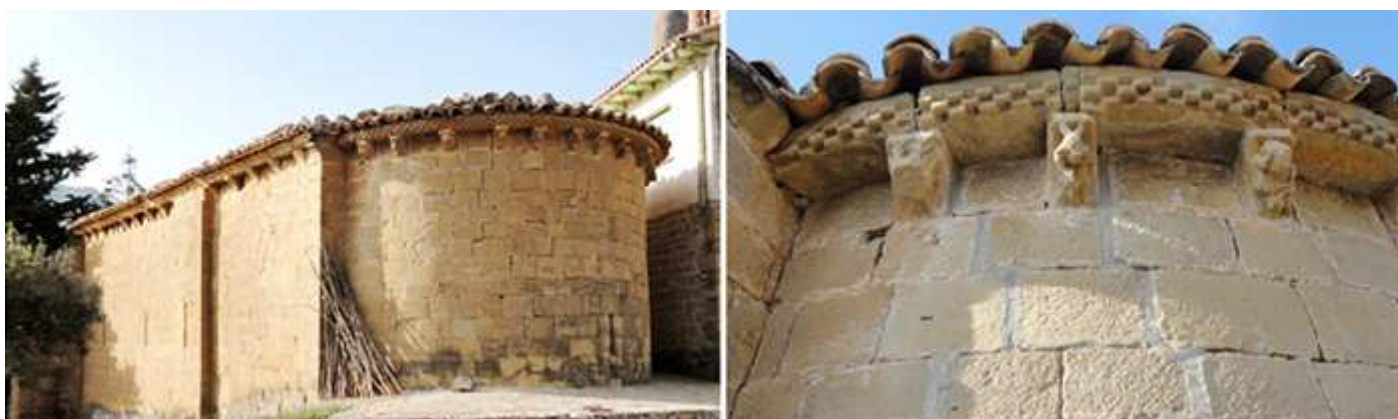
❶ Imagen posterior de su cabecera semicircular, presbiterio y nave. ❷ Detalles de su tejado ajedrezado y sus interesantes canecillos.
