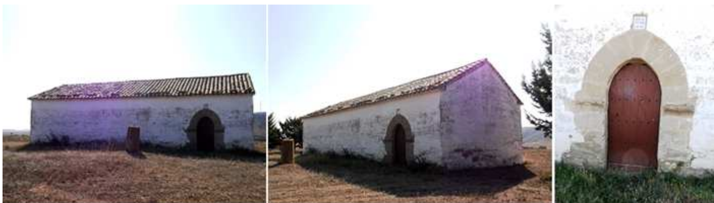
❶ No dispone de otra apertura que la de su puerta. ❷ Lateral exterior del lado del Evangelio donde se encuentra su acceso. ❸ Su puerta de piedra sillar con un arco de medio punto apuntado que sus dovelas lisas salvo unas cruces en los laterales grabadas y un aro en la clave con una estrella de seis puntas, que apenas se perciben. Y que descansa sobre unas impostas.
